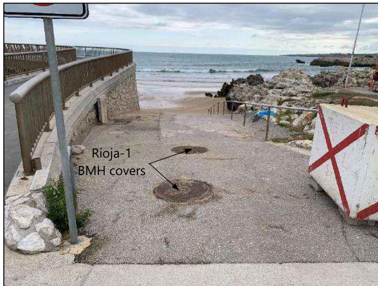
Figura 14.- Rampa de acceso a la playa de la Virgen del Mar. Fuente: Tecnoambiente, 2021.
