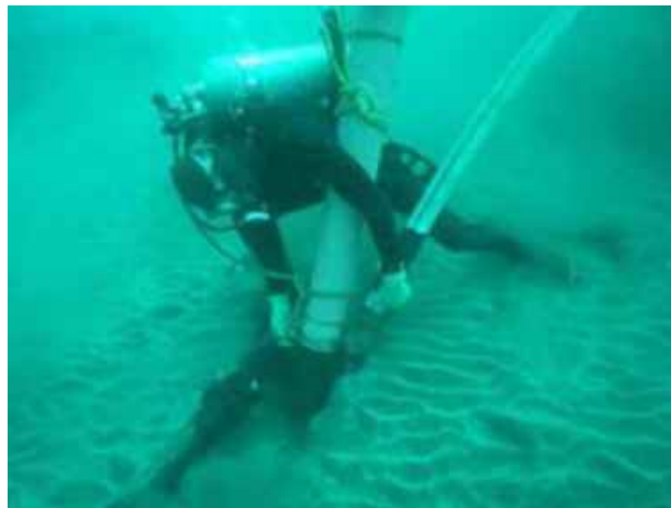
Figura 26. Chorro de agua manual ( Airlift ). Fuente: NEC.
