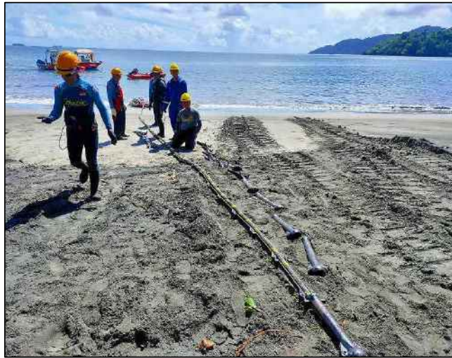
Figura 7.- Instalación de la protección articulada en la zona de playa. Fuente: NEC.
