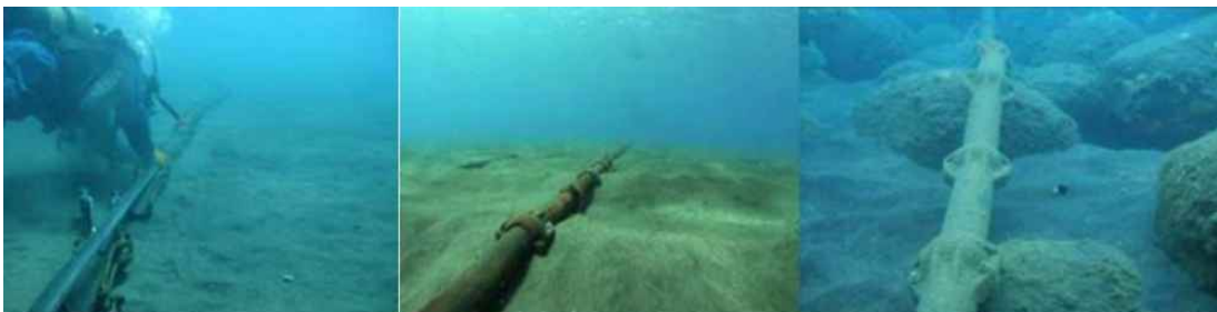
Figura 22. Instalación de tuberías articuladas. Fuente: NEC.
