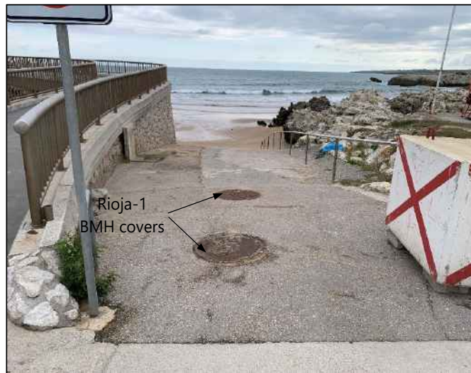
Figura 14.- Rampa de acceso a la playa de la Virgen del Mar. Fuente: Tecnoambiente, 2021.
