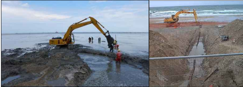
Figura 23. Enterrado en la playa con una excavadora. Fuente: NEC.
