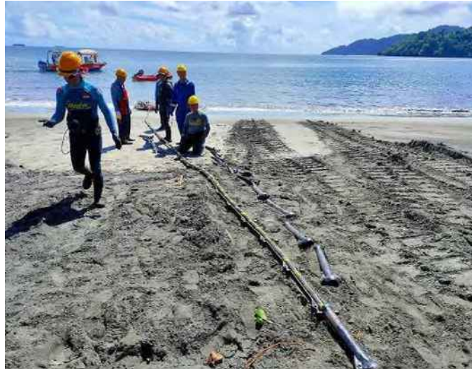
Figura 21. Instalación de tuberías articuladas en la playa. Fuente: NEC.
