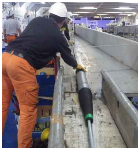
Figura 35. Ejemplo de caja de empalme que aloja un equalizador. Fuente: NEC.
