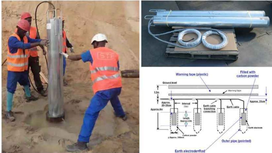
Figura 18. Ejemplo de un conjunto de ánodos introducidos en las carcassas (izquierda), ánodos (derecha-arriba) y diagrama de instalación (derecha-abajo). Fuente: NEC.
