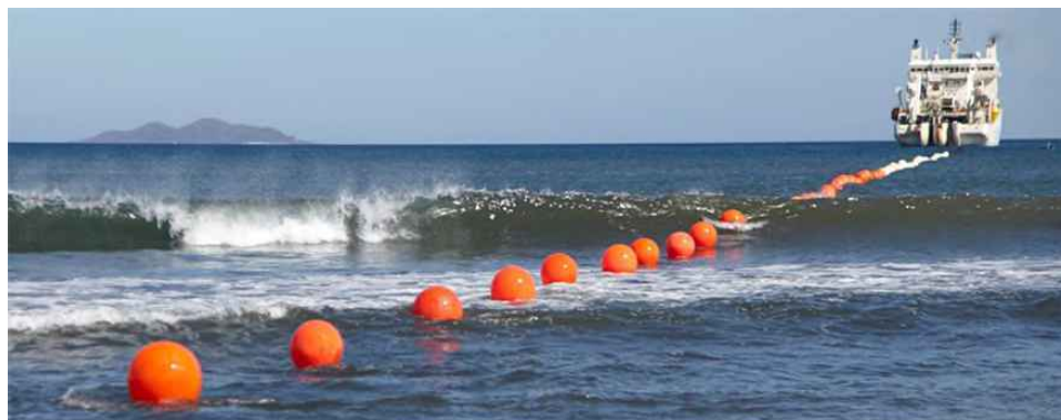
Figura 16. Operación de aterraje del cable. Fuente: NEC.
