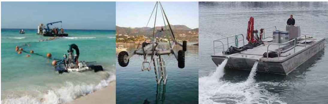
Figura 25. Buque de apoyo a las operaciones de enterrado en tierra (izquierda), máquina de enterrado (centro), plataforma de buceo (derecha). Fuente: NEC.
