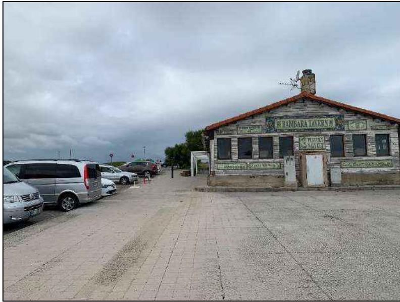
Figura 16.- Bar ubicado a lado del aparcamiento. Fuente: Tecnoambiente, 2021.
