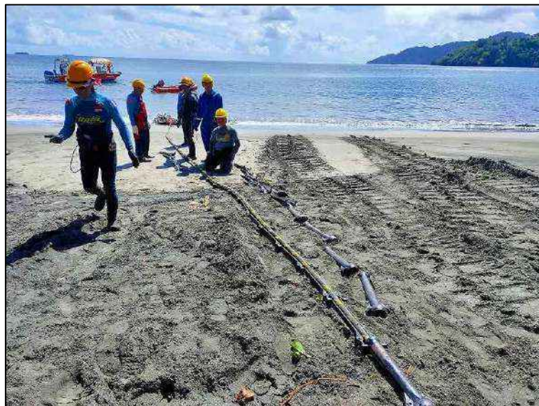
Figura 7.- Instalación de la protección articulada en la zona de playa. Fuente: NEC.
