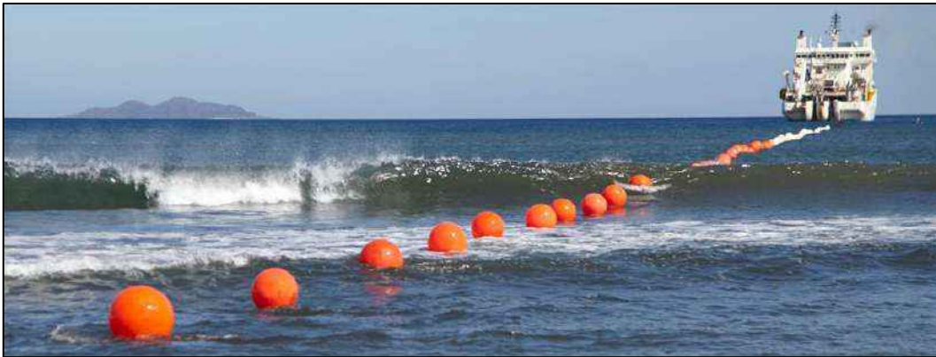
Figura 5.- Operación de aterrizaje del cable. Fuente: NEC.
