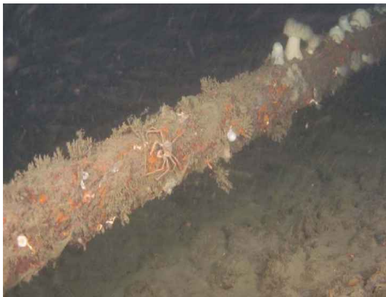
Figura 33. Cable submarino, expuesto durante aproximadamente 50 años, cubierto de organismos sésiles incrustantes. Fuente: OSPAR, 2009.
