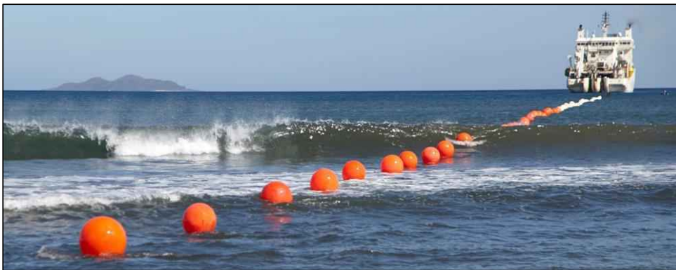
Figura 5.- Operación de aterrizaje del cable. Fuente: NEC.
