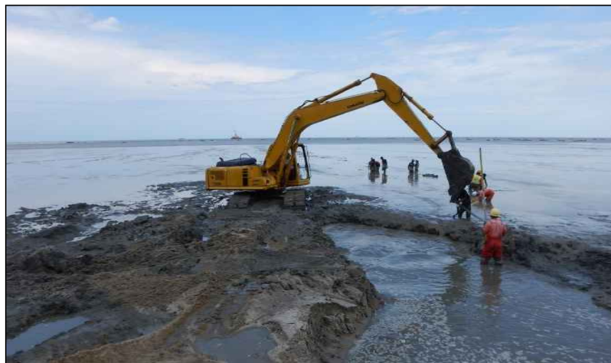
Figura 8.- Enterramiento del cable en la playa por medio de una excavadora. Fuente: NEC.
