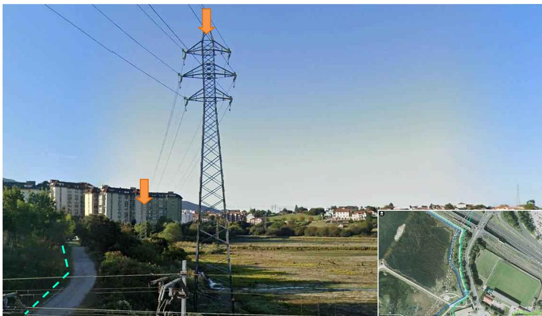
Imagen 7.4.2.3. Ubicación de apoyos a desmontar (flecha naranja) y trazado de la línea soterrada (línea discontinua azul), todo dentro del DPMT.
