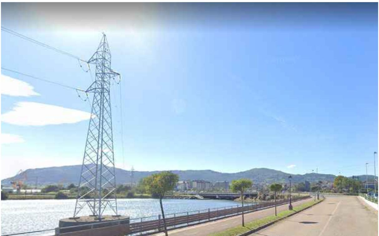
**Línea 55 kV Maliaño-E.Nucleares a desmontar y avda. Juan Carlos I por la que se proyecta el soterramiento del tramo de línea.**
