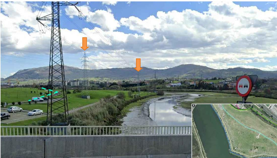
Figura 7.4.2.2. Ubicación de apoyos a desmantelar (flecha naranja) y trazado de la línea soterrada (línea discontinua azul, todo dentro del DPMT)
