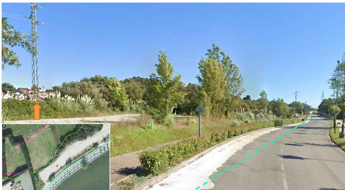
Figura 7.4.1.4. Ubicación de apoyo a desmontar (flecha naranja) y trazado de la línea soterrada dentro de DPMT (línea discontinua azul), ambos dentro del DPMT.
