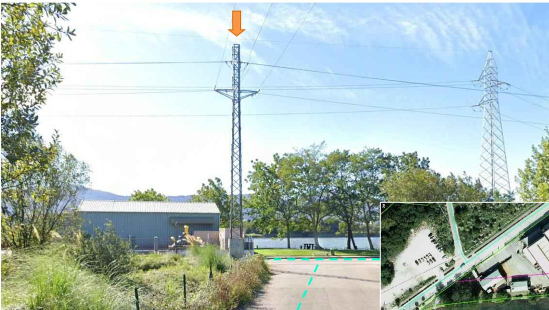
Figura 7.4.1.3. Ubicación de apoyo a desmontar (flecha naranja) y trazado de la línea soterrada (línea discontinua azul), ambos dentro del DPMT.
