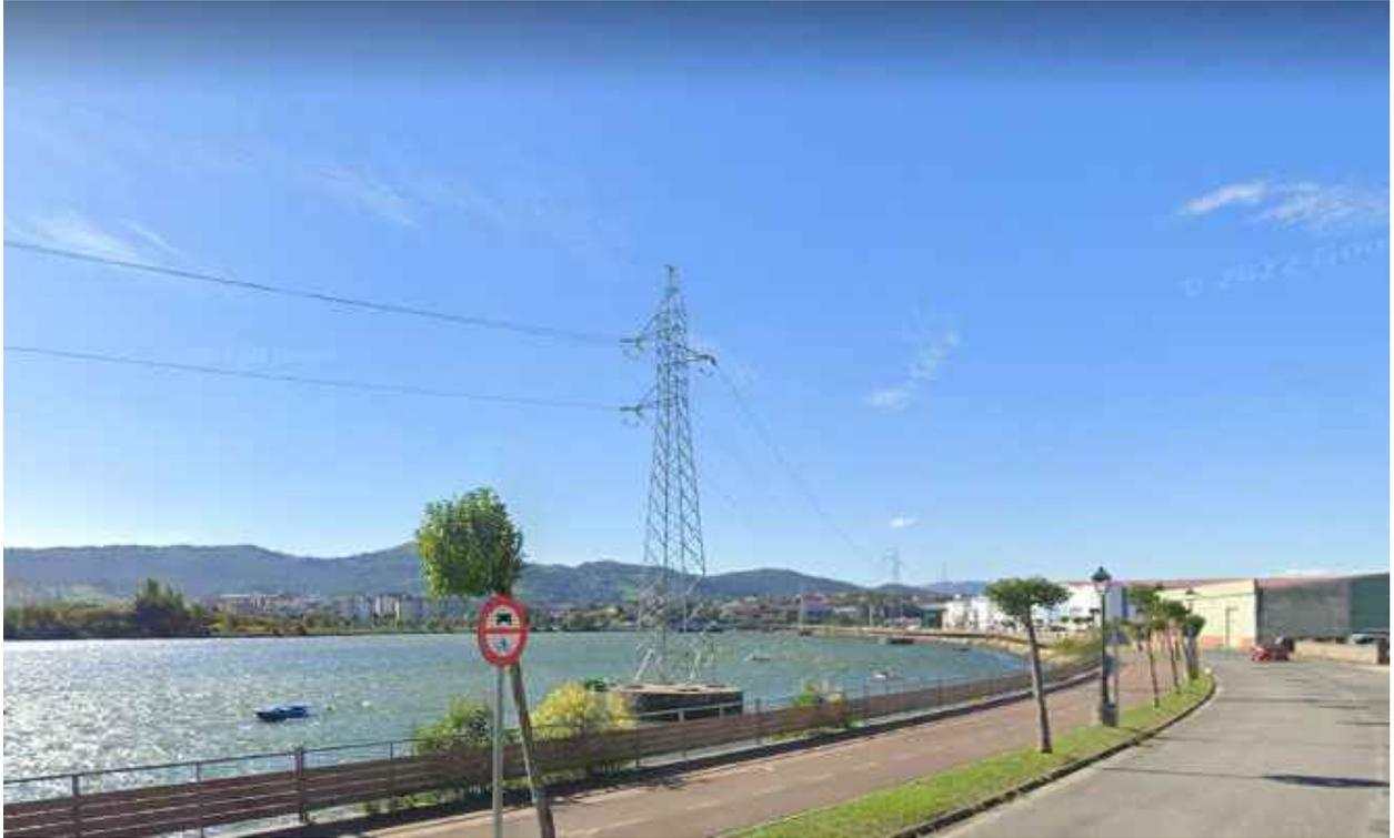
**Línea 55 kV Maliaño-E.Nucleares a desmontar y avda. Juan Carlos I por la que se proyecta el soterramiento del tramo de línea.**
