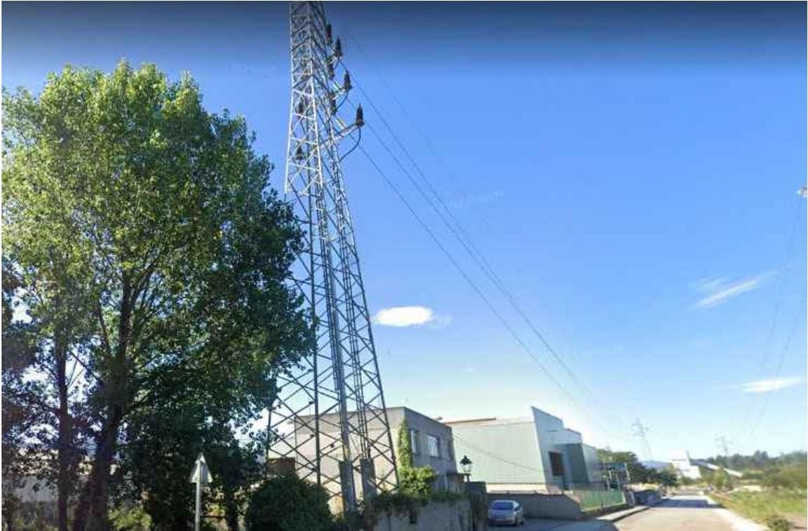
**Línea 55 kV Maliaño-E.Nucleares a desmontar y avda. Juan Carlos I por la que se proyecta el soterramiento del tramo de línea.**
