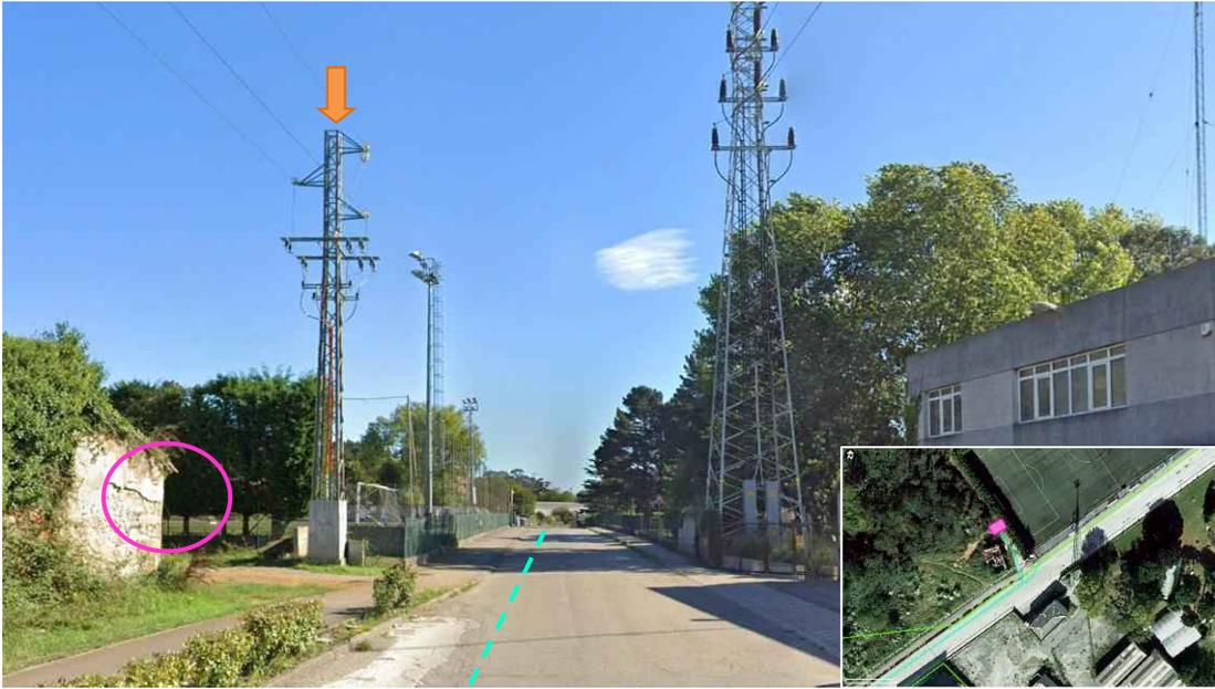
Figura 7.4.1.2. Ubicación de apoyo a desmontar (flecha naranja) y nuevo CT Solana (círculo rosa) fuera del DPMT y trazado de la línea soterrada (línea discontinua azul) dentro del DPMT
