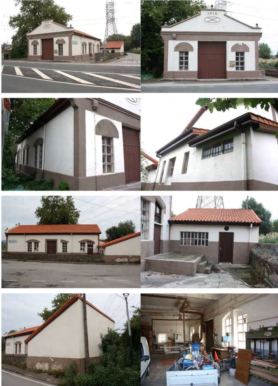
Sistema de depuración de los talleres municipales de Micedo, Muriedas (Cantabria)
