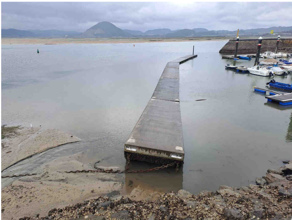
Figura 2. Rompeolas de hormigón varado en la esquina este
