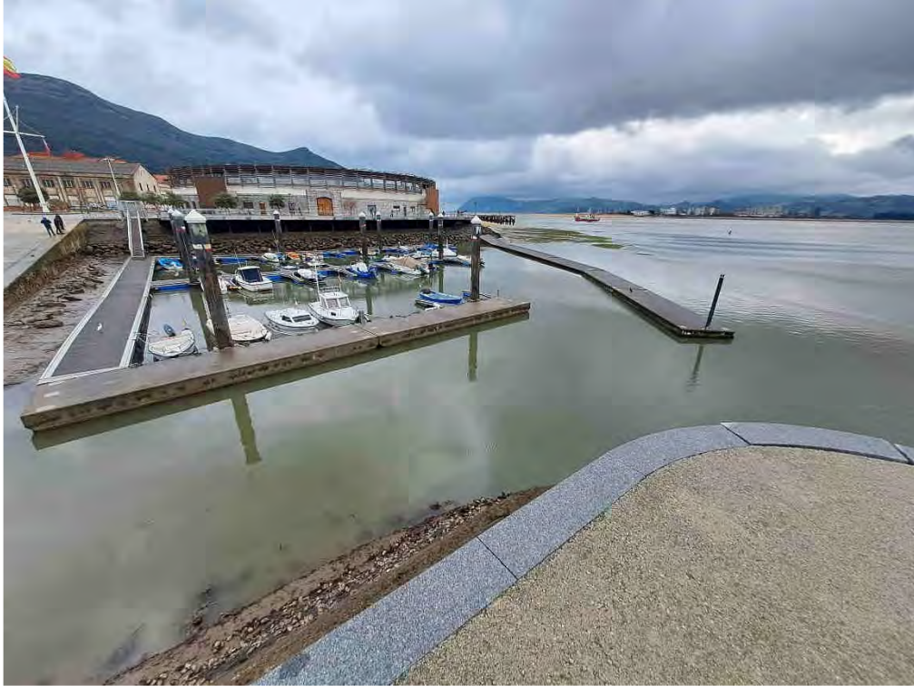
Figura 1. Vista general de la dársena en bajamar
