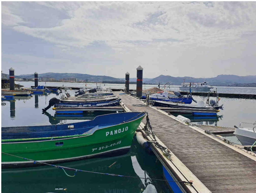
Figura 6. Vista del pantalán 2 a desmontar para la ejecución del dragado
