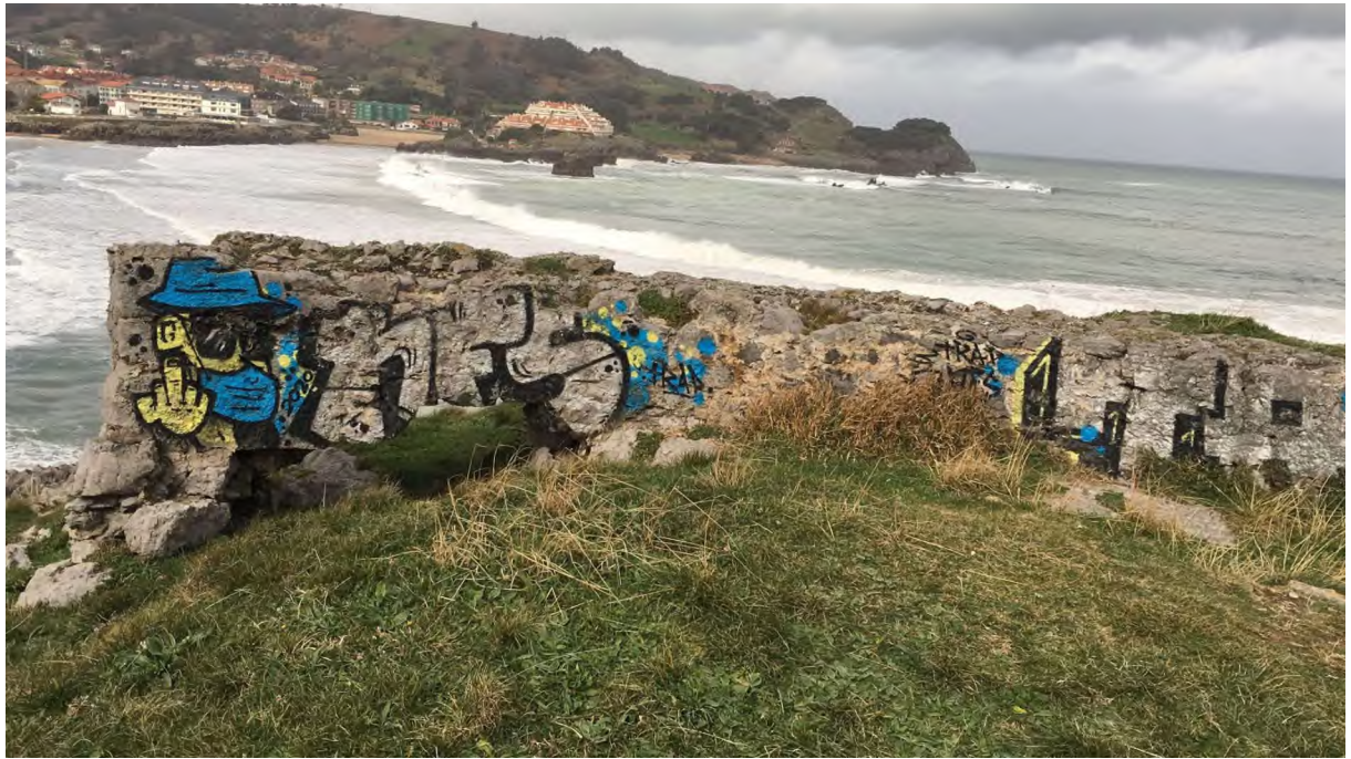
Ilustración 11: Vista, en detalle, del parapeto norte
