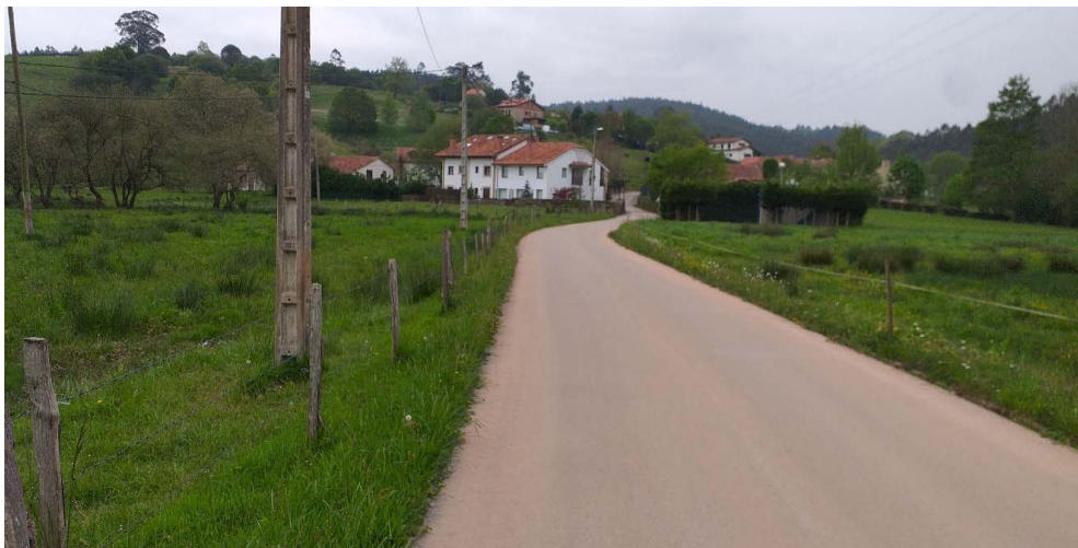
Foto 3: zona a realizar nueva canalización y línea aérea BT a desmontar.
