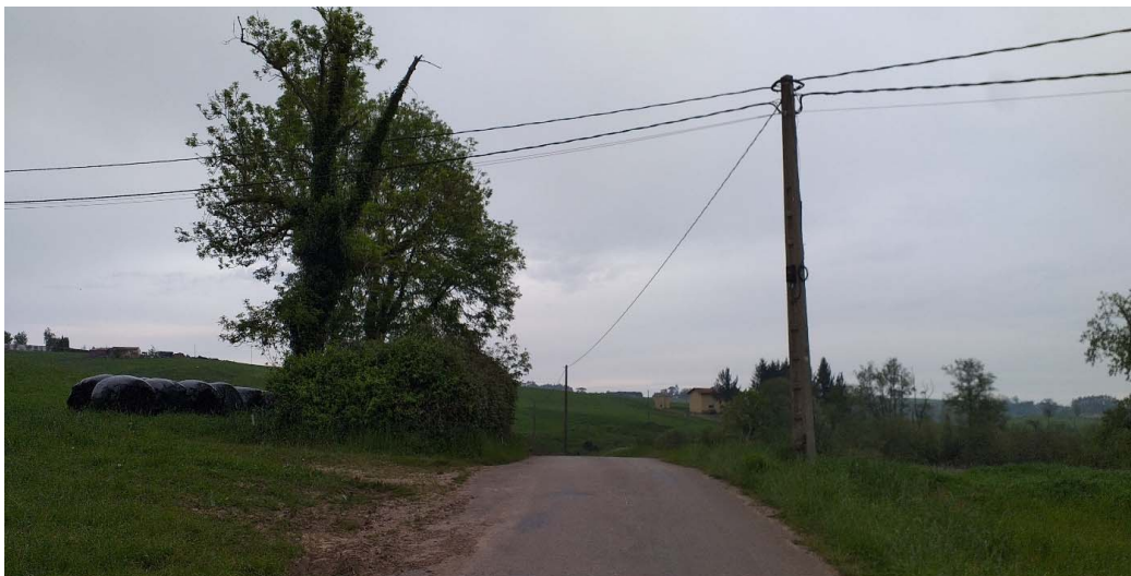
Foto 5: línea aérea BT a desmontar y zona a realizar nueva canalización.
