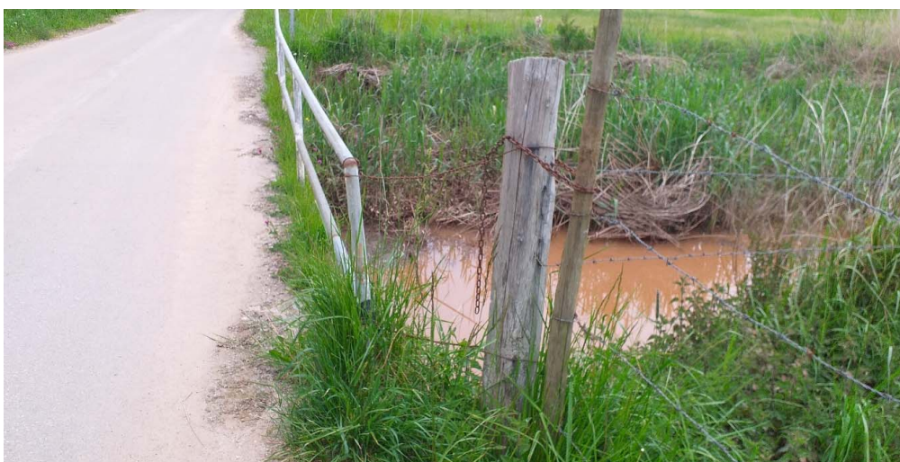
Foto 4: zona a realizar perforación horizontal dirigida.
