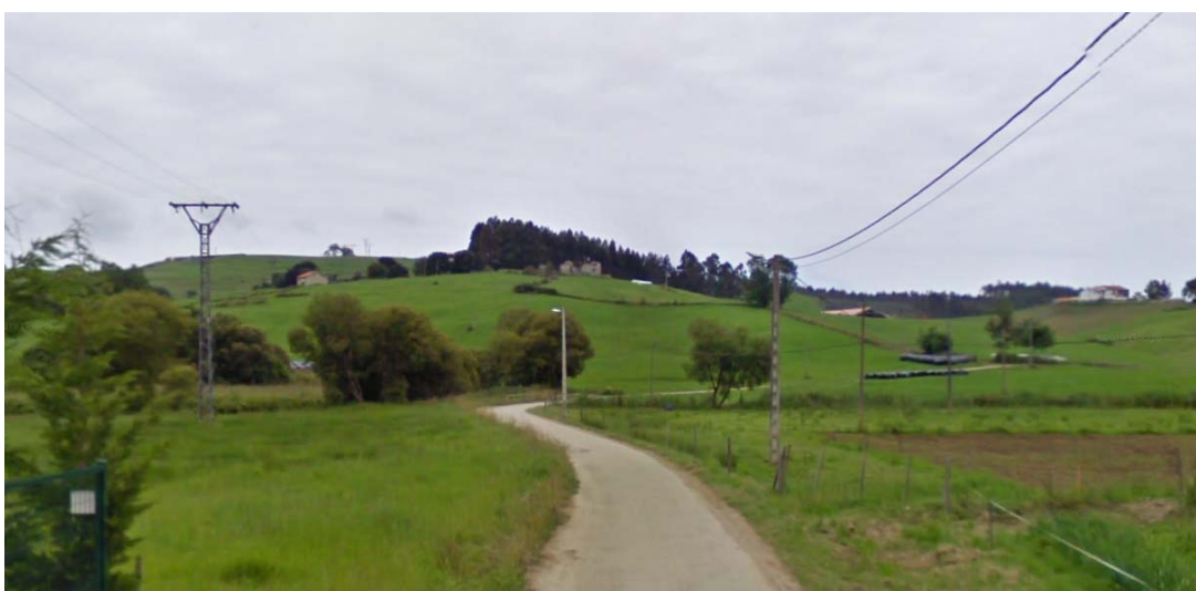
Foto 8: líneas aéreas BT y AT a desmontar y zona a realizar nueva canalización
