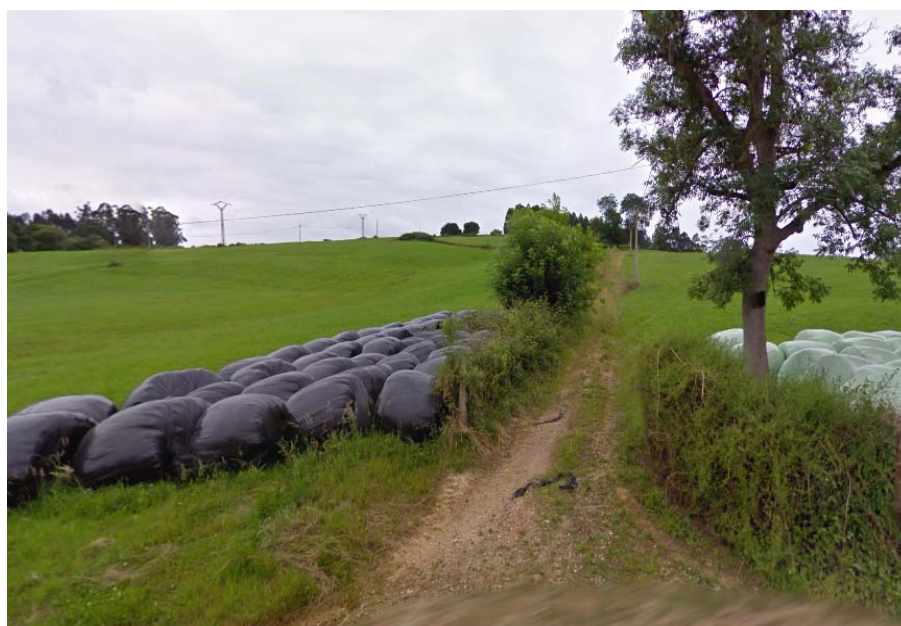
Foto 6: líneas aéreas BT y AT a desmontar y zona a realizar nueva canalización
