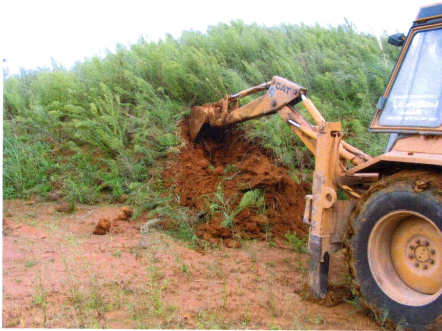
PEQUEÑA EXCAVACIÓN REALIZADA PARA OBSERVAR EL ESTADO DEL RELLENO REALIZADO CON RESTOS DE PLUMEROS Y ARCILLA AMARILLENTA
