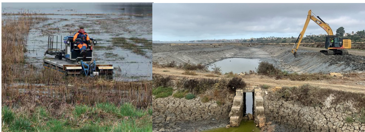
Foto 7. Los trabajos proyectados incluyen la siega del carrizal con maquinaria especializada y la excavación y reperfilado de las nuevas áreas de humedal.
