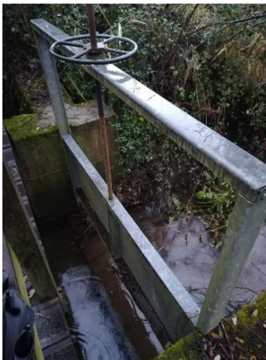
Foto 9. La colocación de una esclusa regulable permitirá controlar los niveles de inundación de la laguna y evitará la intrusión excesiva de agua marina.
