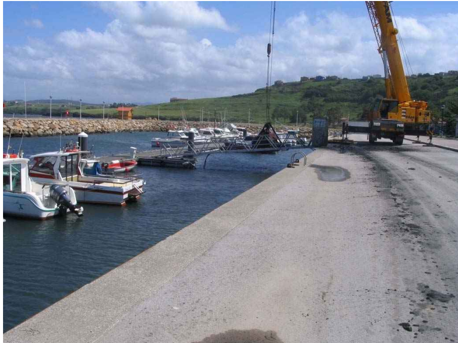
DRAGADO EN ZONA DE PANTALANES EN 2007 CON DESMONTAJE PARCIAL DE FINGERS
