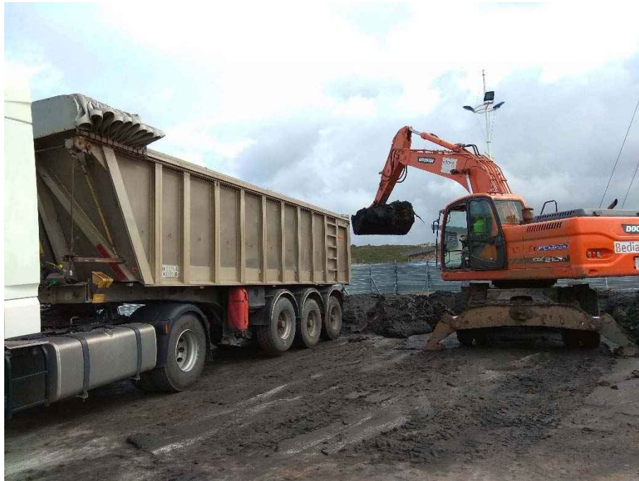
MEDIOS DE DRAGADO (2017). CARGA DESDE ERA DE SECADO A VERTEDERO
