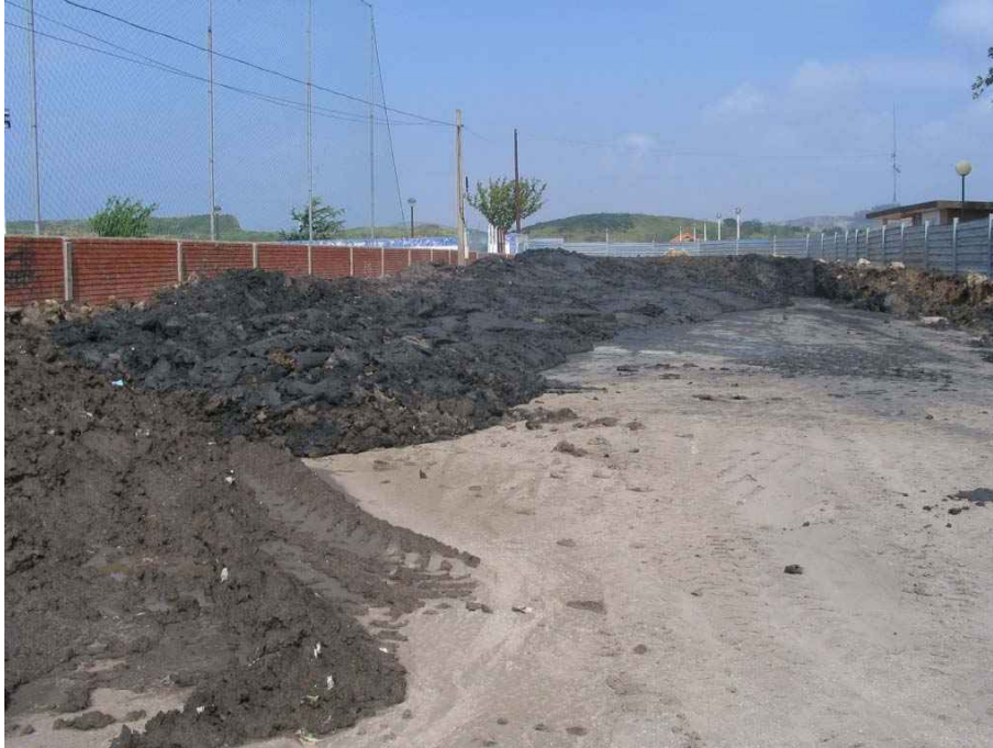
MATERIAL DE DRAGADO EN ERA DE SECADO.
