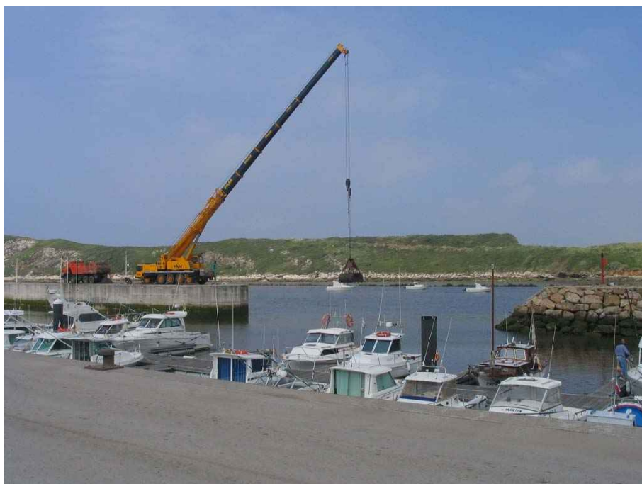
DRAGADO EN ZONA DE BOCANA EN 2007 DESDE DIQUE NORTE
