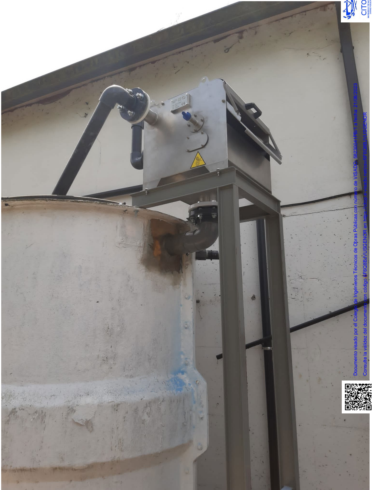
Foto N° 5.- Rotofiltro en cabecera de la línea de depuración EDAR industriales. Se observa la entrada del efluente por la parte anterior, salida al depósito homogeneizados por la parte inferior y el rebose, en su caso, por la parte frontal. Los sólidos por la parte posterior. En contenedor de sólidos sobre la rasante del suelo, no se aprecia en la foto.
