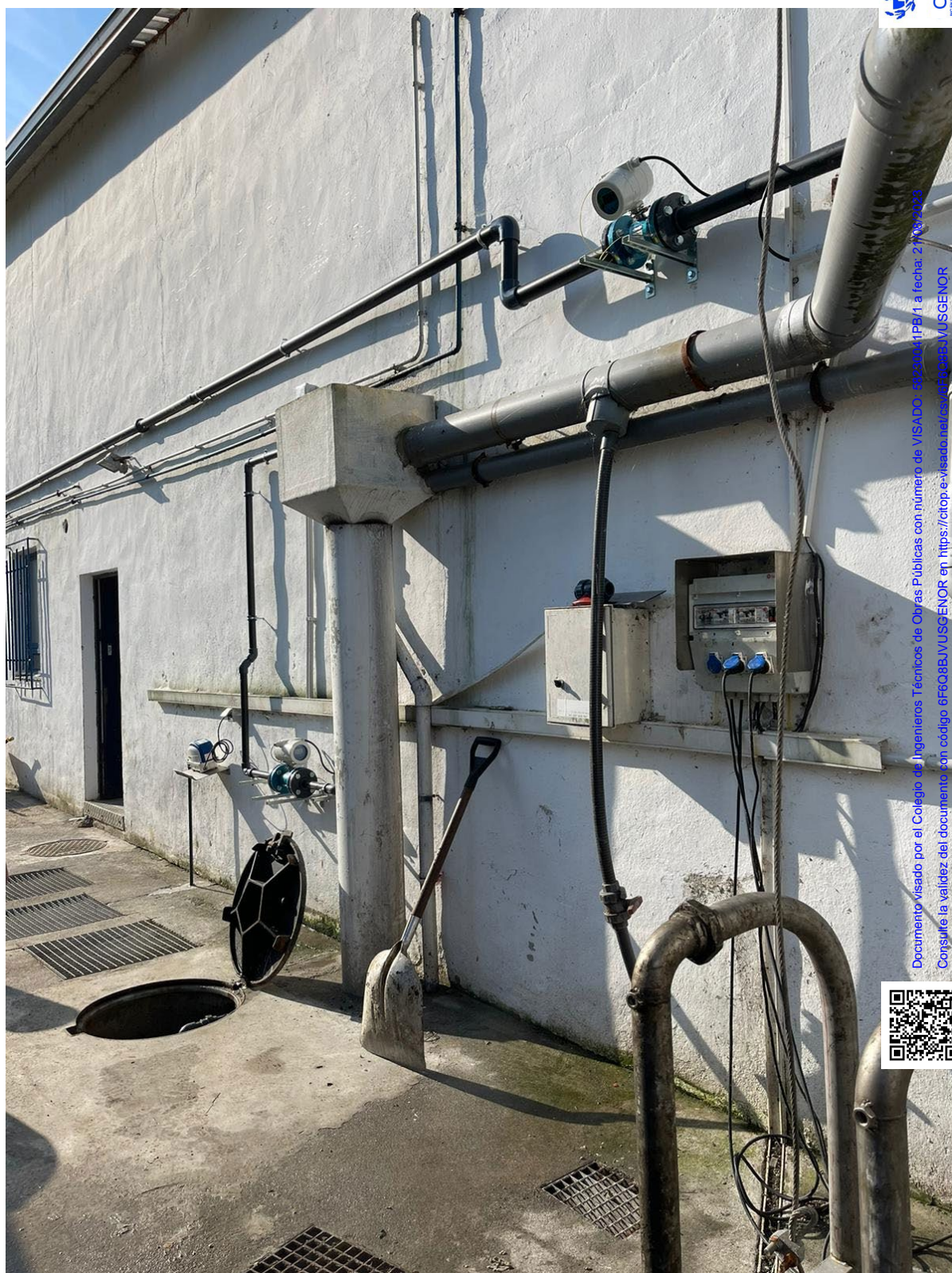
Foto N° 3.- Sistema de reunión de efluentes depurados, con registro en altura, desde donde arranca el colector de vertido a la Ría de Treto.
