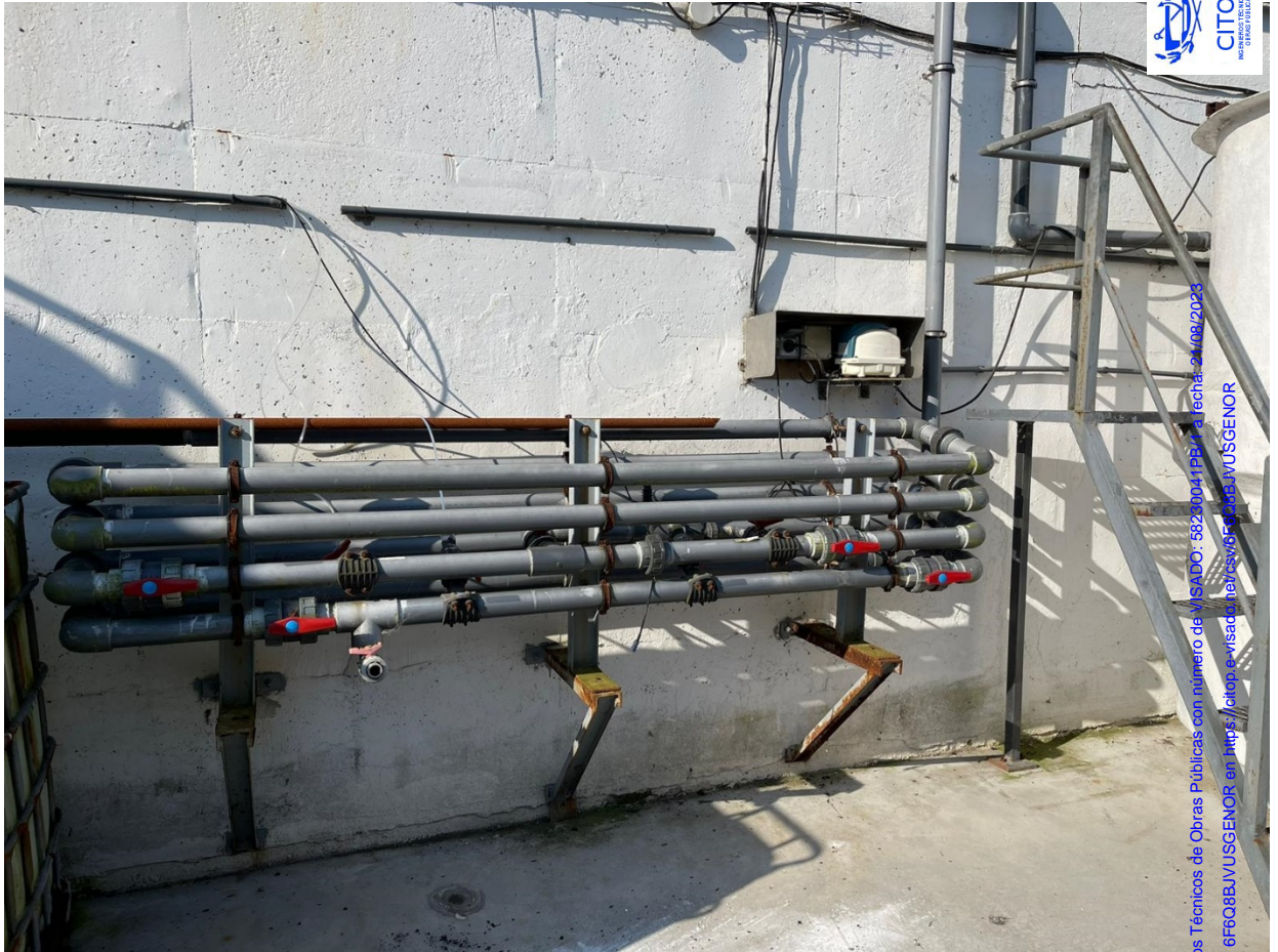
Foto N° 6.- Floculador tubular, 2'6 m x 0'80 m x 0'42 m. con la bomba dosificadora del floculante.
