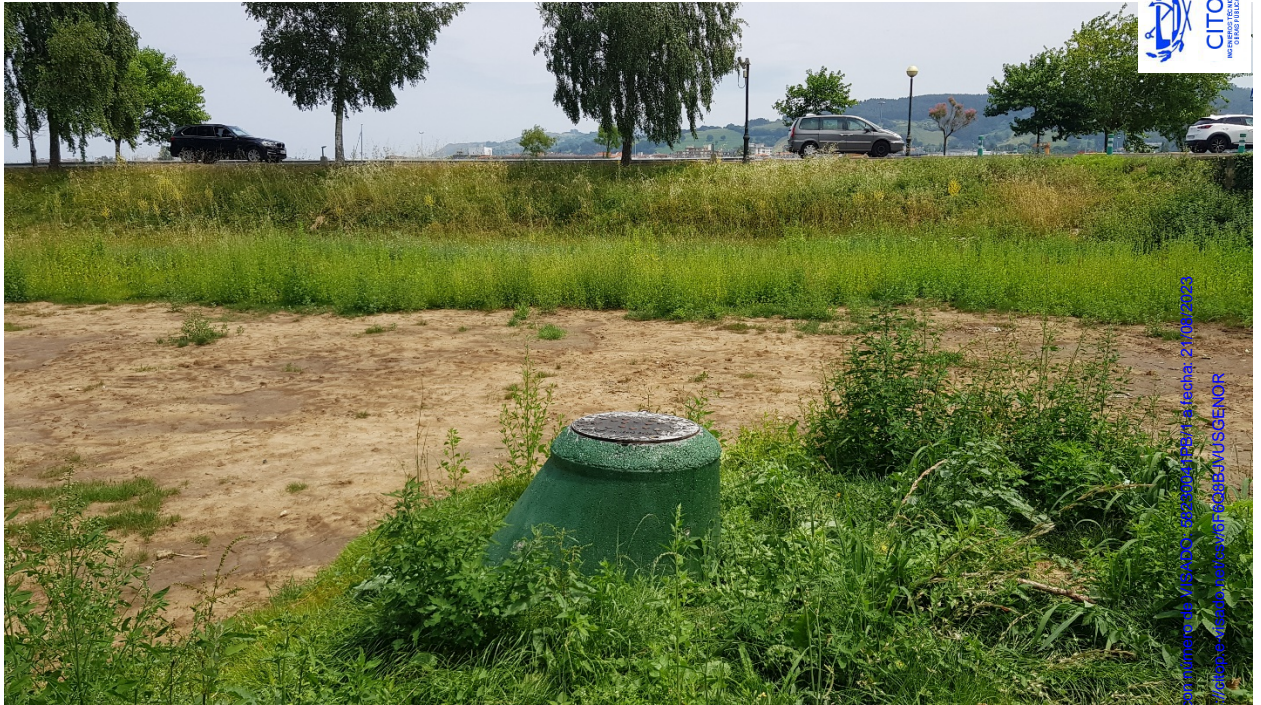
Foto N° 9.- Pozo de registro para toma de muestras del vertido depurado y caudales. Exterior a la factoría.
