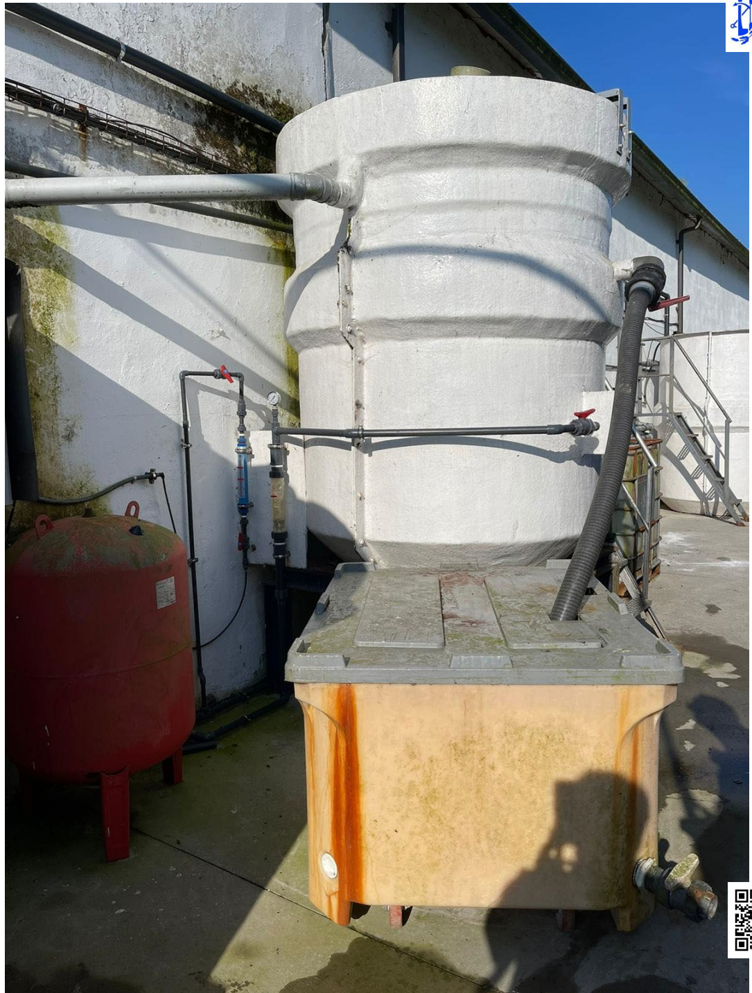
Foto N° 8.- DAF en EDAR industriales, \phi 1'6\text{ m} \times 1'95\text{ m} . Se observa la salida de aceites y grasas al contenedor de recogida y la salida del efluente depurado.
