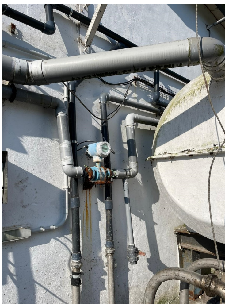
Foto N° 2.- Salida agua de lluvia depurada, de la Balsa separadora de grasa e hidrocarburos.
