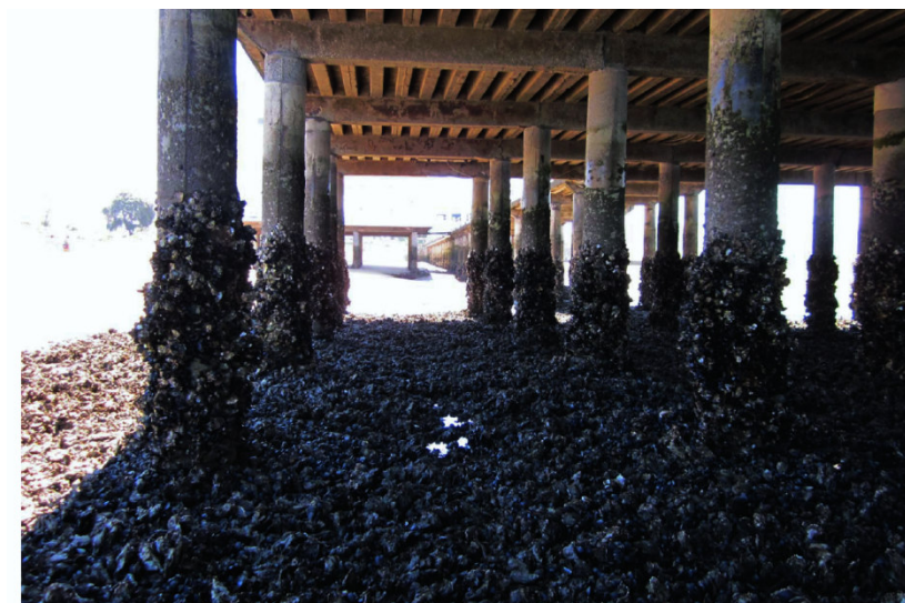
Fotografía de la colonia de moluscos bivalvos presentes en la estructura de sustentación
