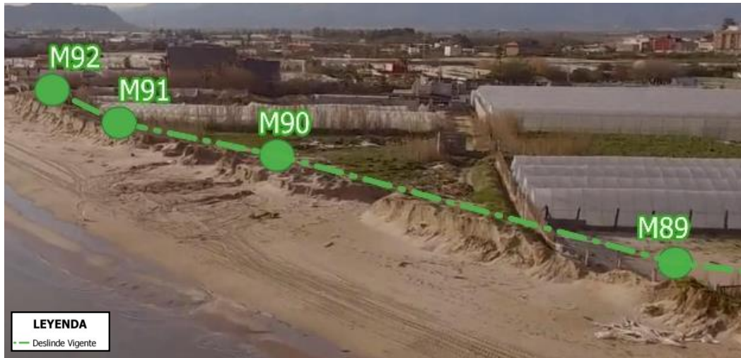
Figura 6. Fotografía detalle tras el temporal Gloria entre vértices M89 a M92 con la línea de DPMT vigente. Se observa el escarpe vertical del frente dunar (Fuente: Ayto. Sueca).
