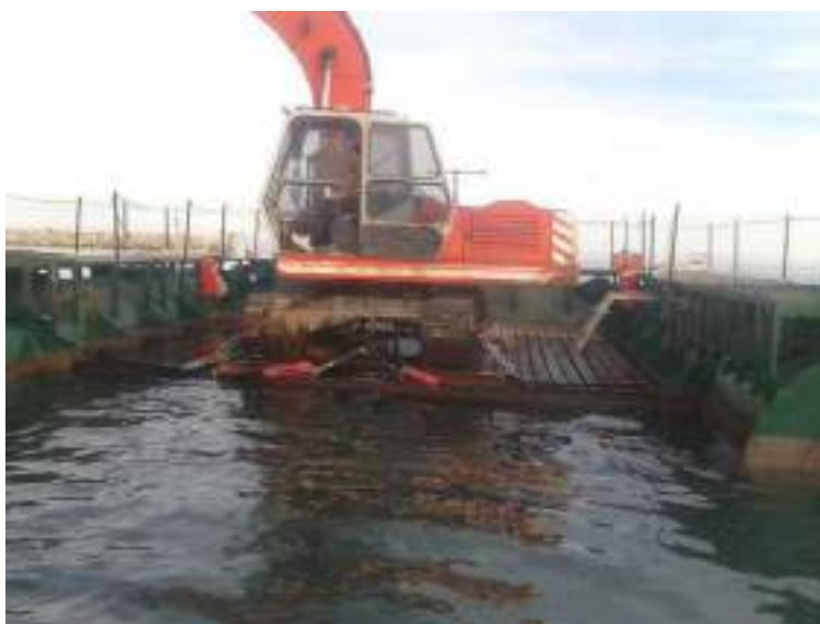
Retroexcavadora sobre pontona
