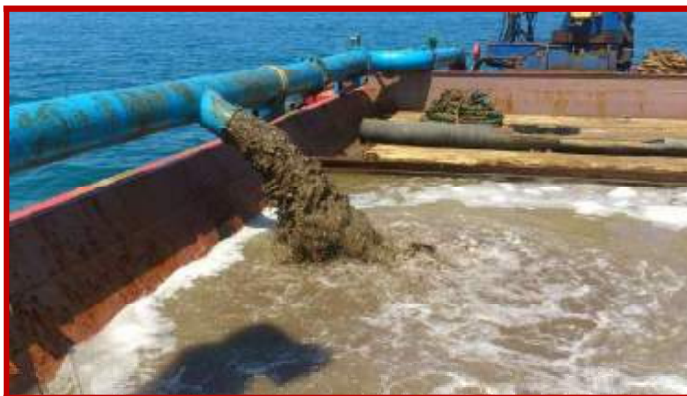
Foto draga ejecutando trabajos de dragado en arena.
