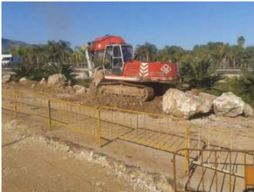
Máquina Retroexcavadora OK RH9 – Realiza trabajos desde dique de vaciado de contenedores de pontona y carga a camión.
