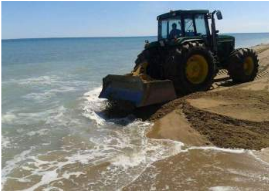
Máquina de extendido. Tractor 162 – Realiza trabajos de extendido de arena en la playa una vez realizado el vertido.
