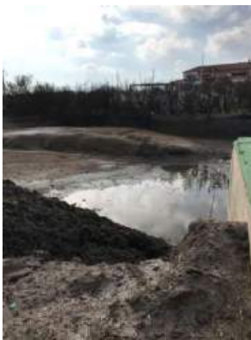
Balsa de decantación con arena sucia
