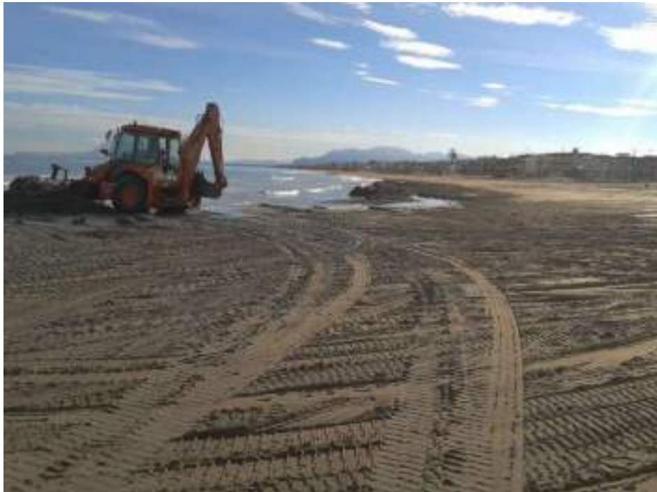
Máquina Mixta de extendido. – Realiza trabajos de extendido de arena en la playa una vez realizado el vertido.
