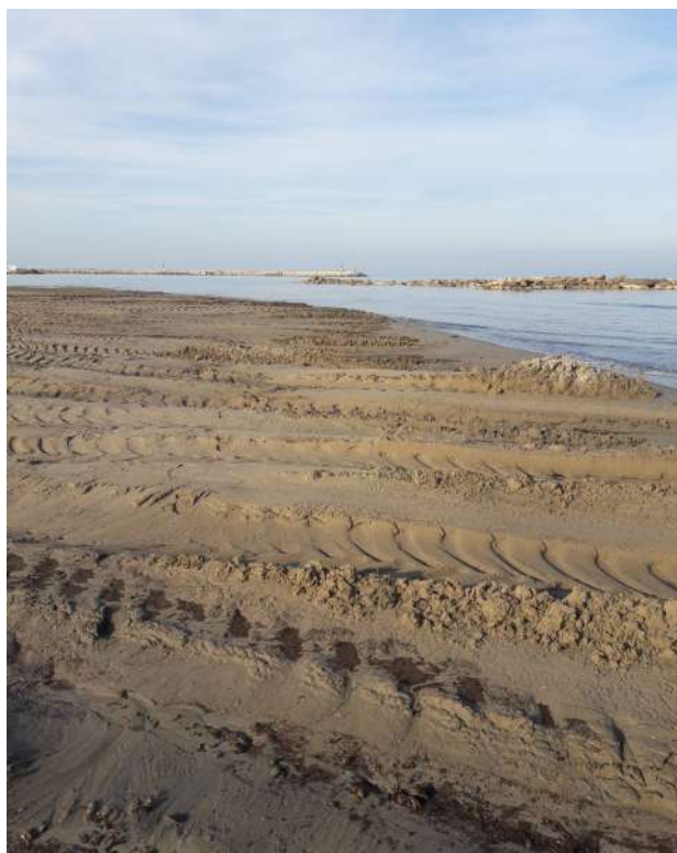
Extendido de la arena en la playa al Sur del dique exento
