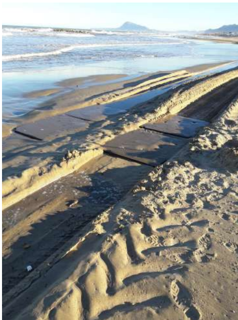
Elementos de reparto de cargas en el paso del emisario
