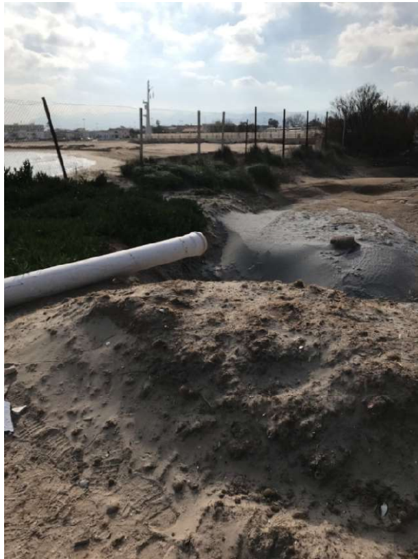
Derivación de la conducción a la balsa de decantación.
