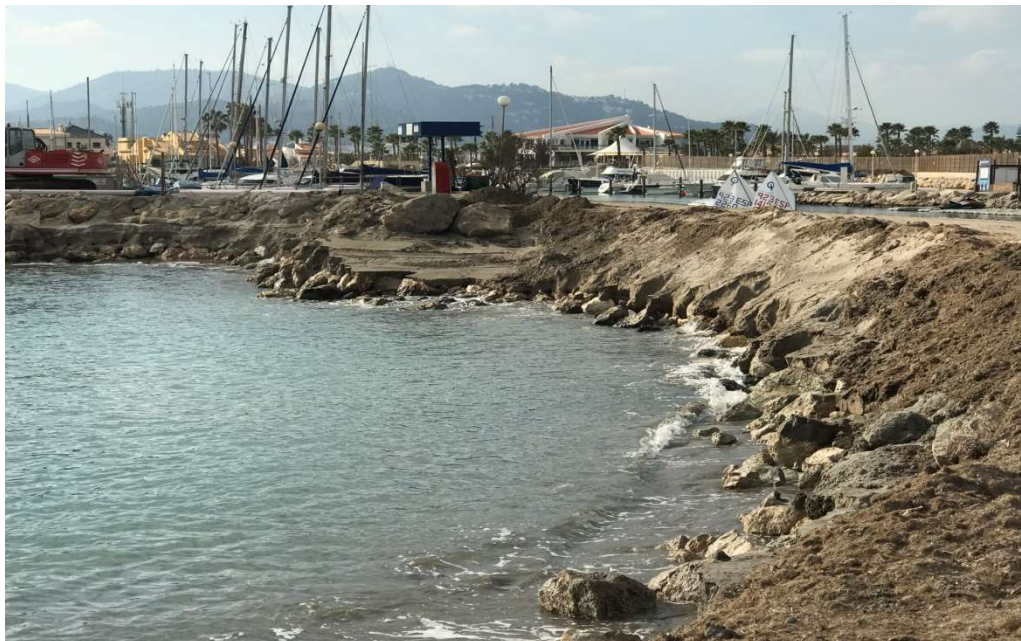
Rampa de acceso a la playeta para su vaciado y carga a camiones para traslado a las zonas de vertido
