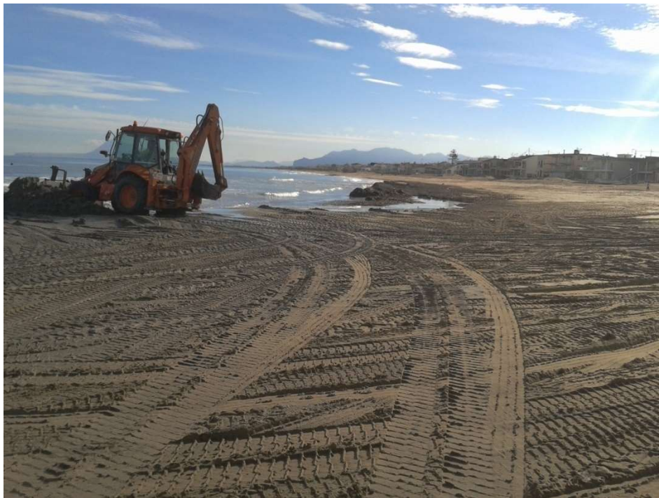
Pala extendiendo la arena en zona de vertido al Sur del espigón aislado.
