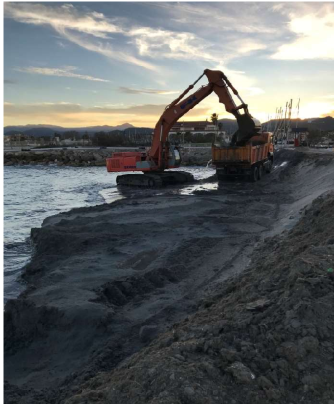
Retroexcavadora vaciando la playeta y cargando camiones para traslado a las zonas de vertido
