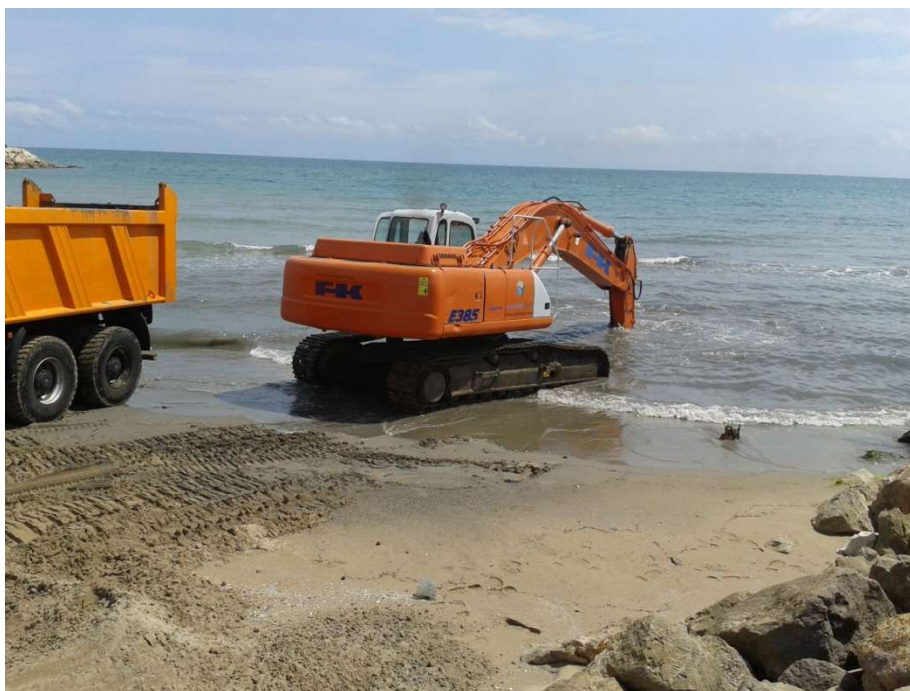
Pala extrayendo rocas del vertido y con limpieza de la playa en zona de vertido al Sur del espigón aislado.
