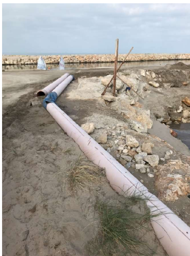
Conducción por donde se canaliza el material succionado por la draga embocando el Talón Sur.
