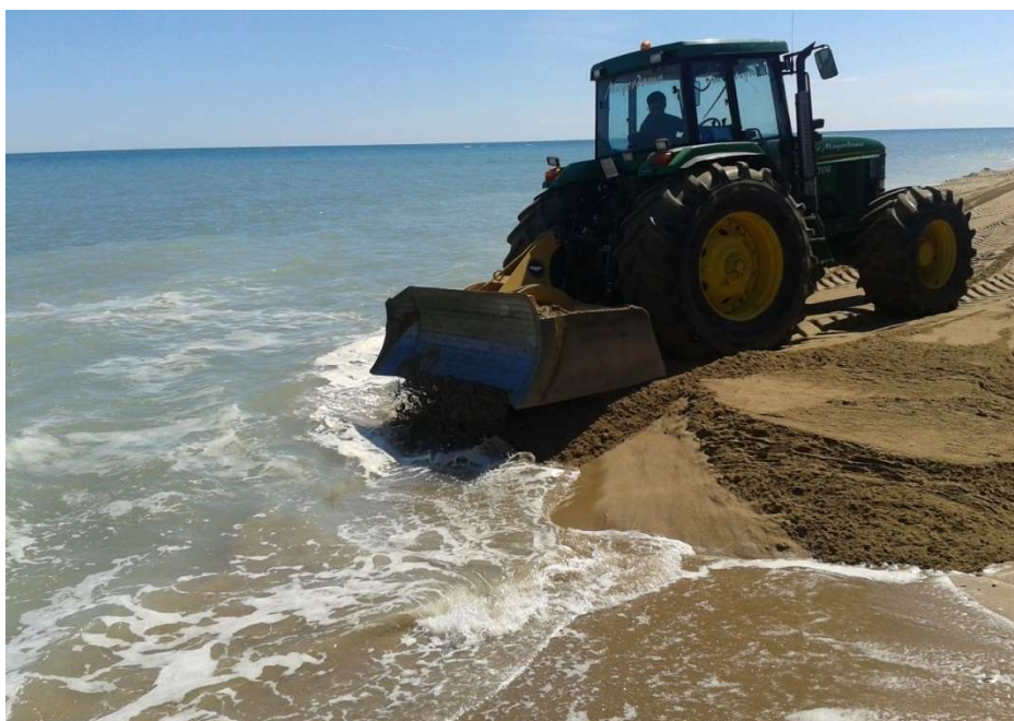
Pala extendiendo la arena en zona de vertido al Sur del espigón aislado.
