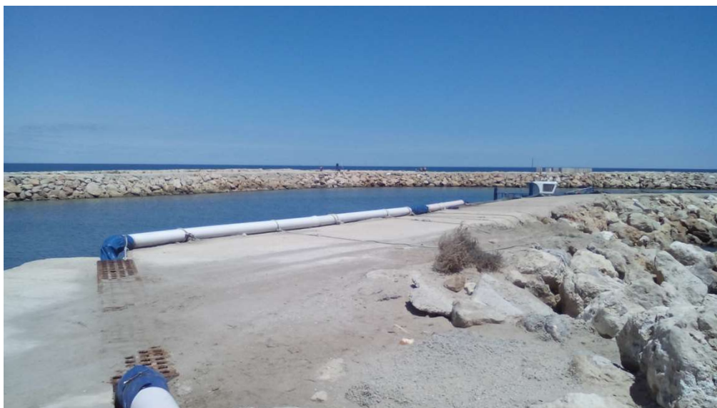
Conducción por donde se canaliza el material succionado por la draga por el Dique Sur.
