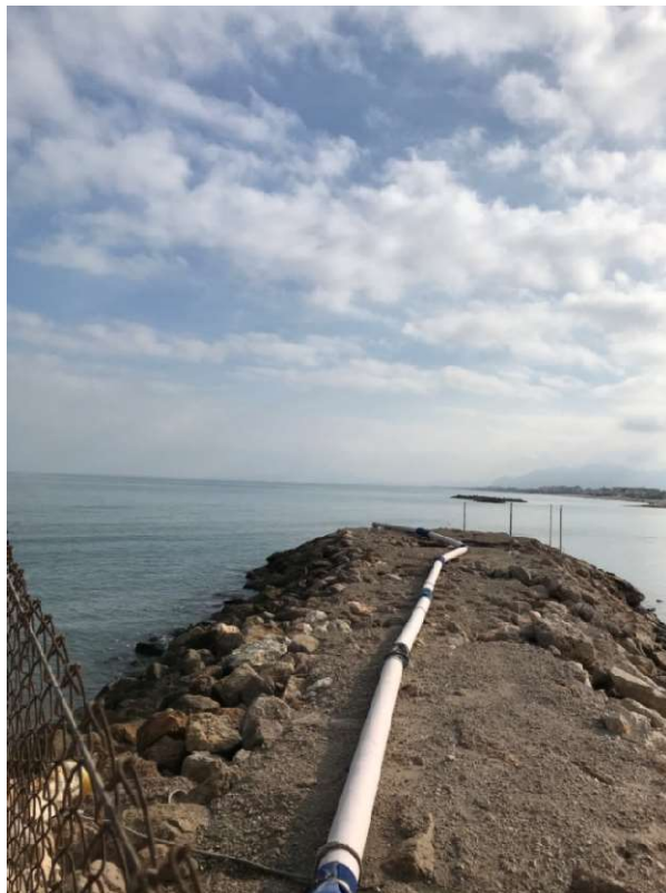
Desembocadura de la conducción por donde expulsa el material succionado, situado en el morro del Talón Sur.
