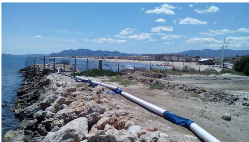
Conducción por donde se canaliza el material succionado por la draga por el Talón Sur.
