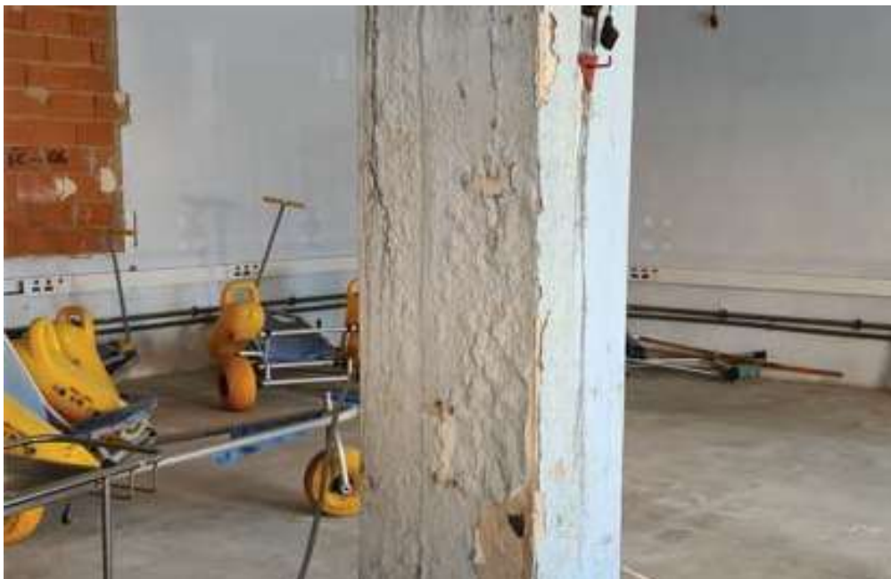
Humedad en pilar procedente de cubierta
