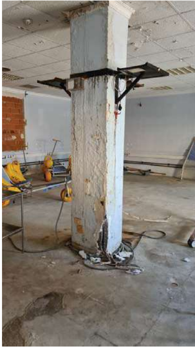
Vista del pilar y cata hasta armadura
