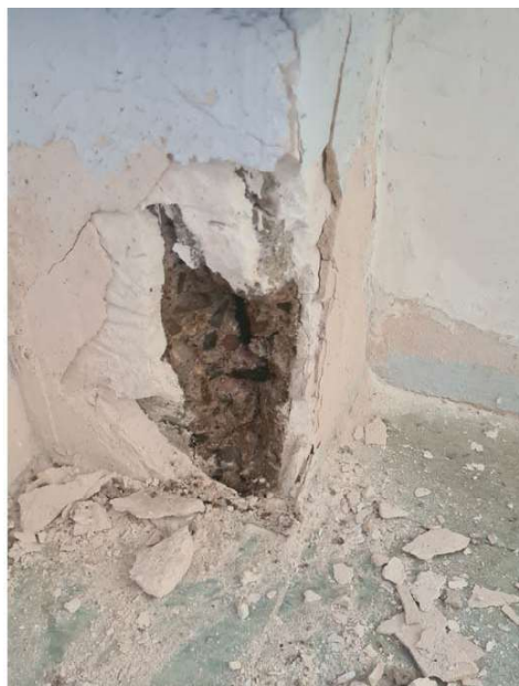
Detalle de la cata hasta armadura
