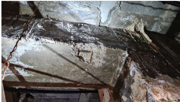
Vista de la viga y cata hasta armadura
