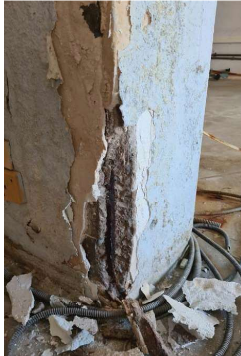
Detalle de la cata hasta armadura. Antes de fenolftaleína.
