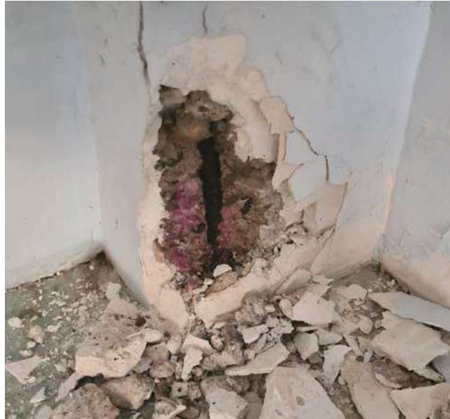
Detalle de la cata hasta armadura. Tras impregnación con fenolftaleína
