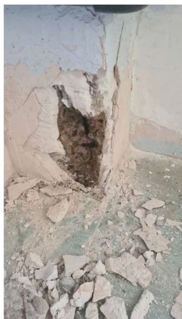
Cata en pilar 6. Arreglo con yeso
