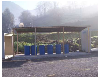
Punto limpio en construcción
