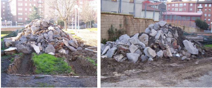
Acopio de residuos de construcción y demolición.
