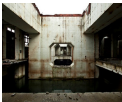
Figura 7. Nave de turbinas
