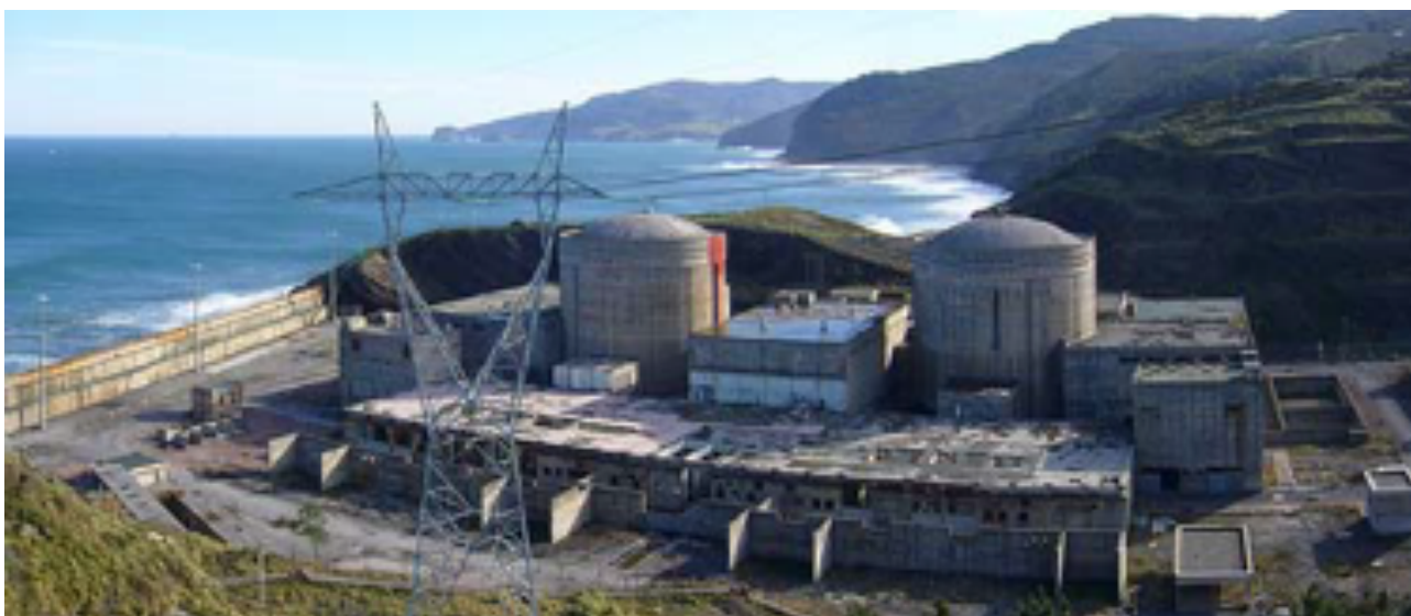
Figura 4. Estado de la central nuclear de Lemoiz en Cala Basordas.
