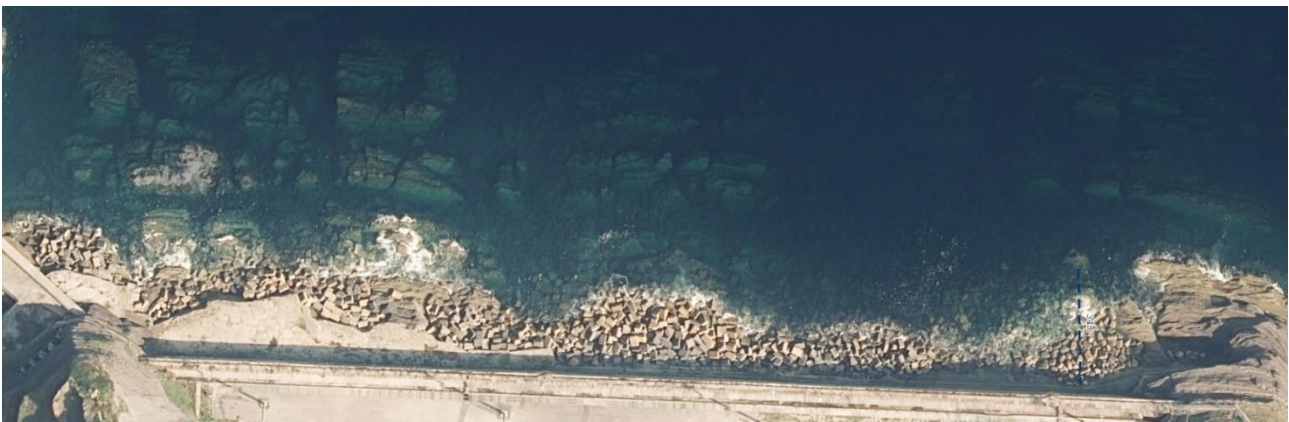
Tipología de la costa en las inmediaciones del dique-muro de la CN de Lemoiz.
