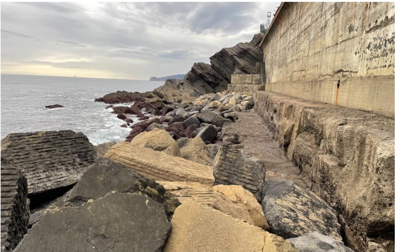
Vista de la zona de actuación. Bajos rocosos sobre los que se apoyan bloques de piedra caliza.
