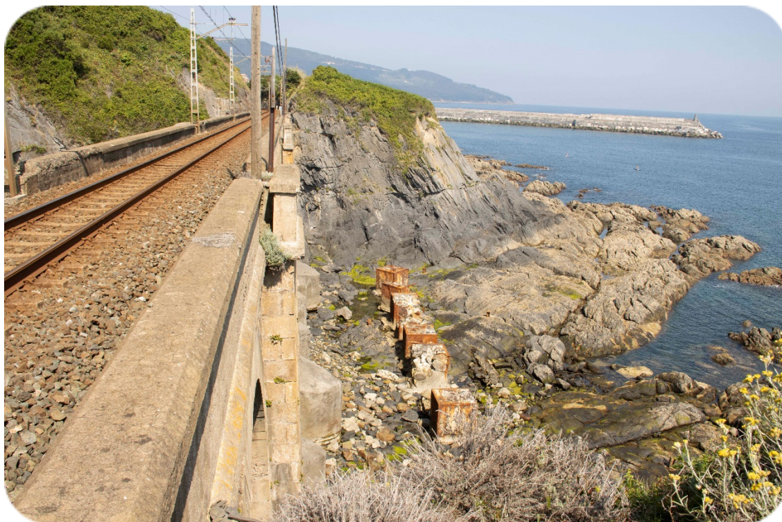
Foto 2. Vista del viaducto desde encima.
