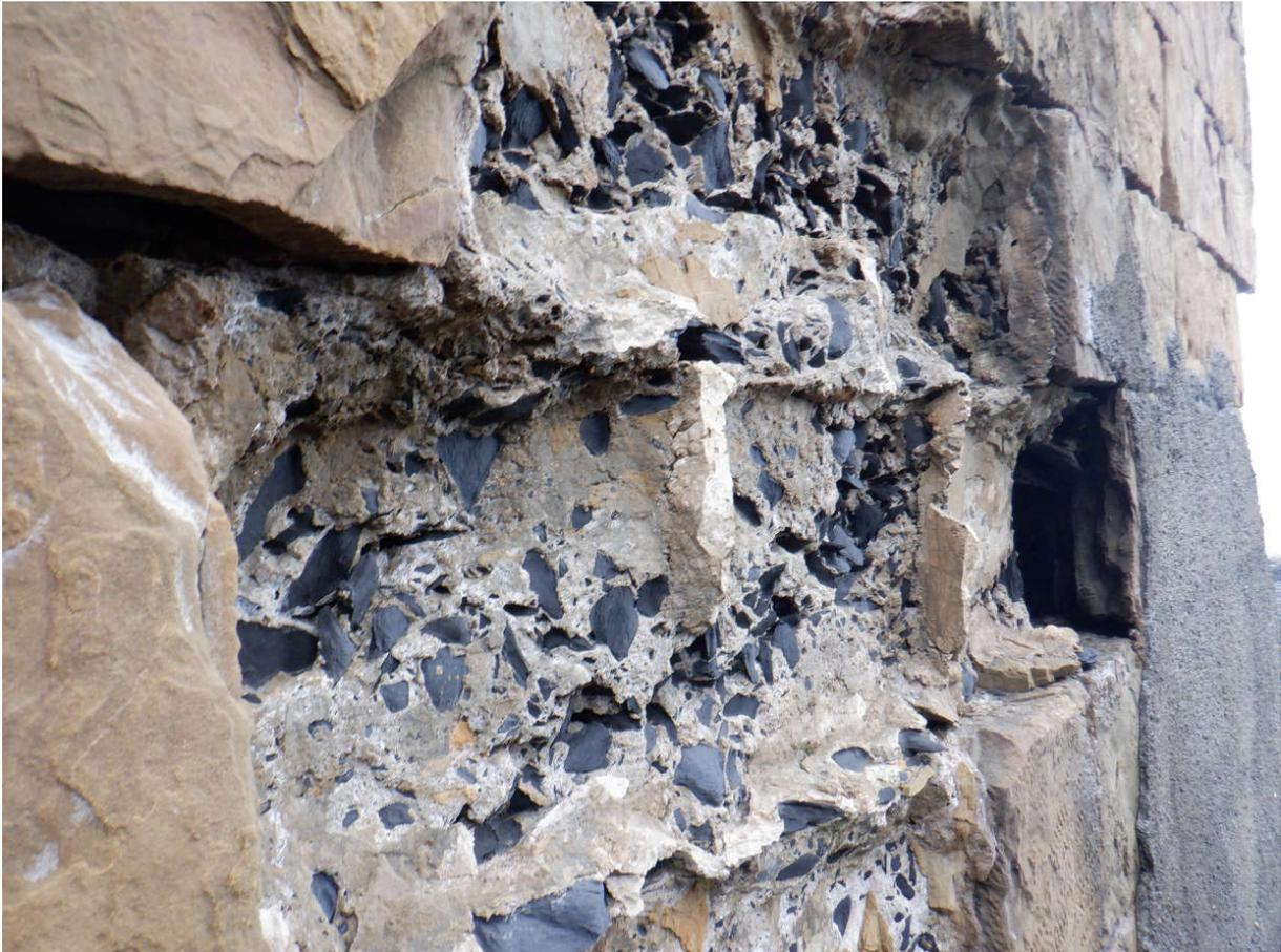
*Figura 35. Aspecto interior de las pilas*
