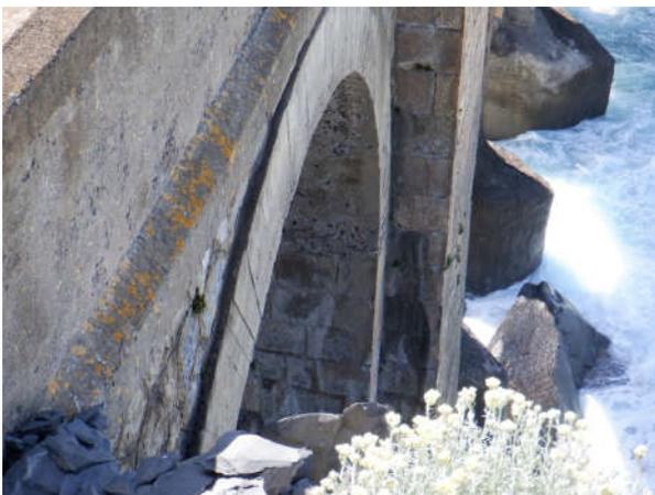
*Figura 36. Bóveda de hormigón*
