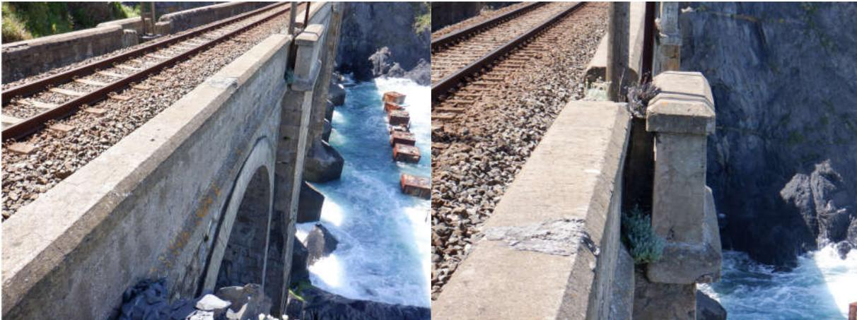
*Figura 39. Detalle de muretes guardabalasto*
