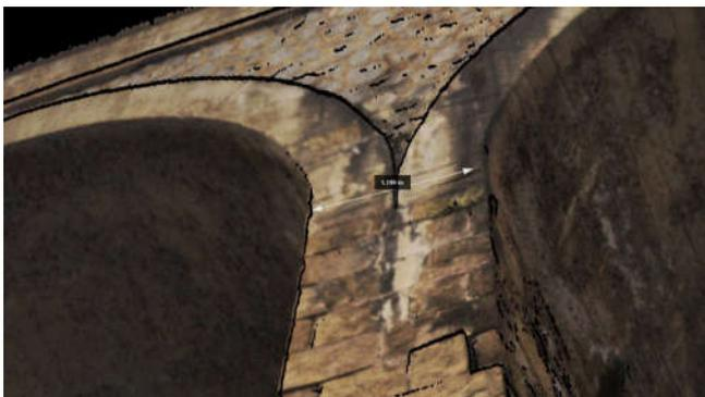
Figura 32. Acotación cabeza de pila
