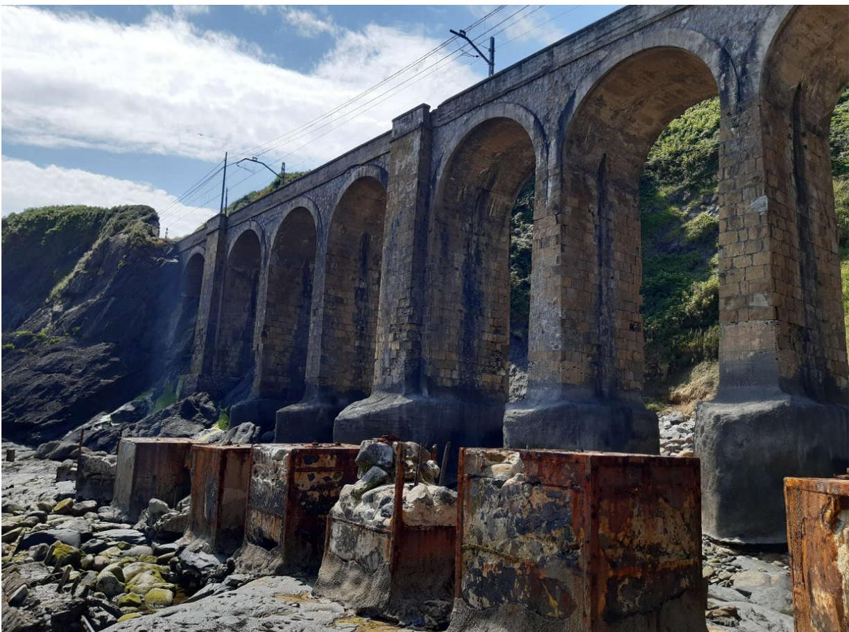
El dique actual se encuentra en un estado deficiente por lo que no cumple el objetivo de proteger el viaducto del embate de las olas y se producen descalces de las cimentaciones que pueden llegar a comprometer la estructura.
