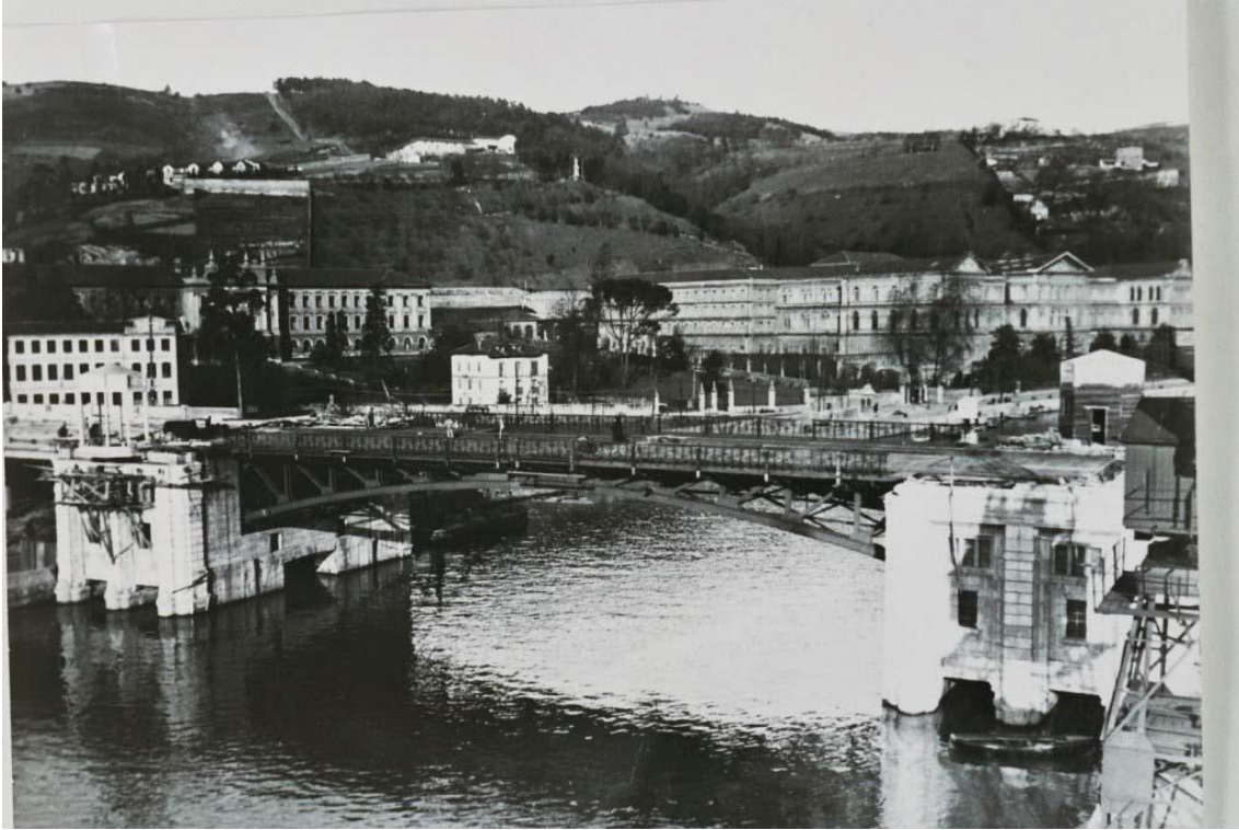
Figura 1.7-3. Fotografía del tramo móvil prácticamente terminado
