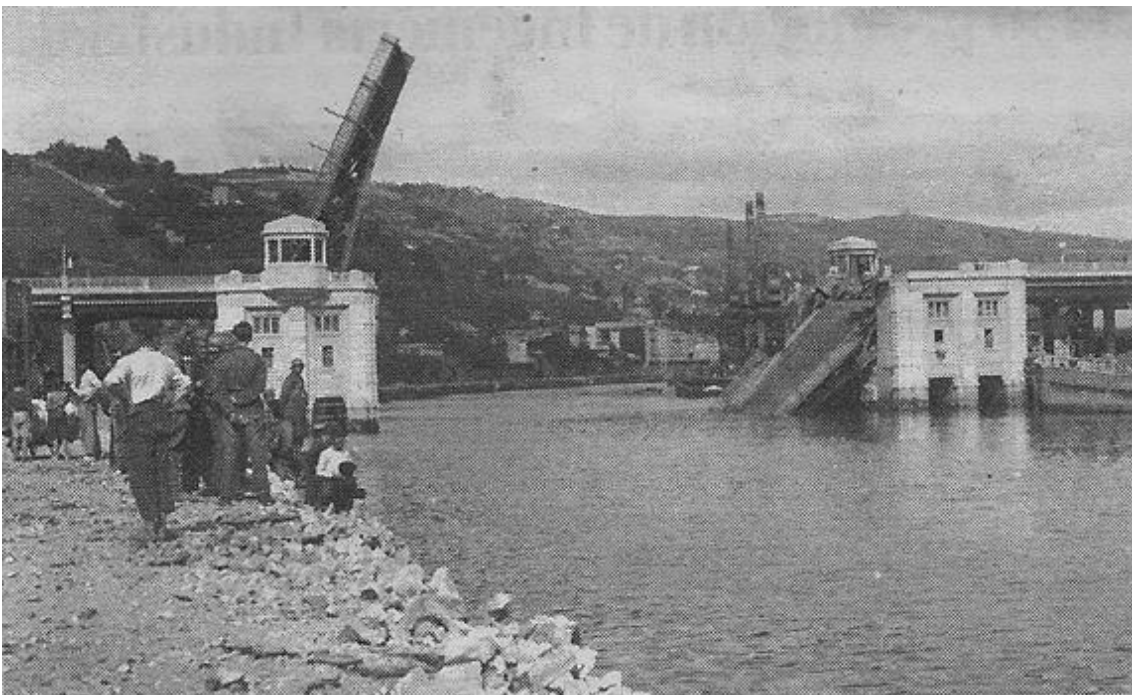
Figura 1.7-4. Fotografía del tramo móvil tras la voladura de la hoja del lado Bilbao
