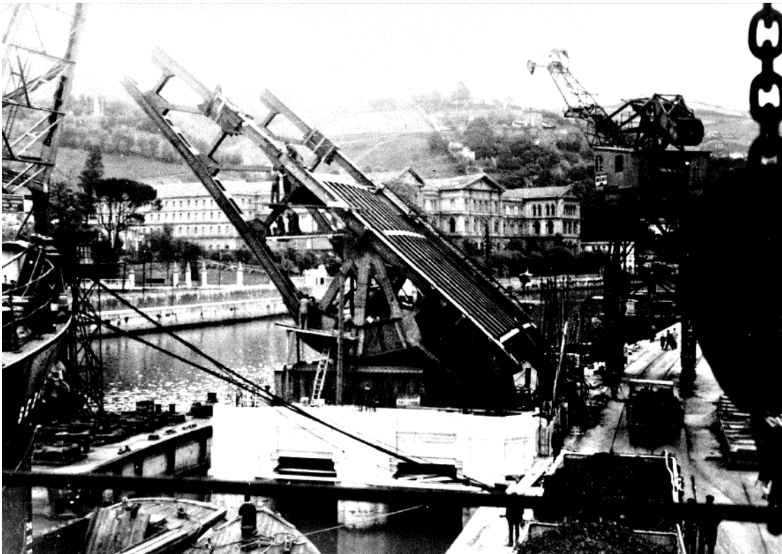
Figura 1.7-2. Tramo móvil. Hoja lado Bilbao durante su construcción
