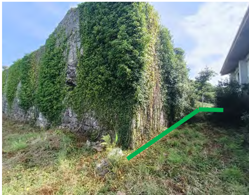
Hitos 1 a 2. Inspección 3 de julio 2025
