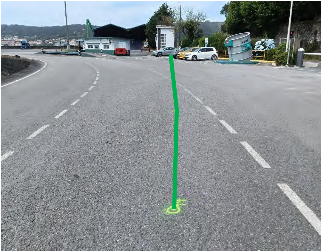
Hitos 14, 13 y 12. Inspección 3 de julio 2025
