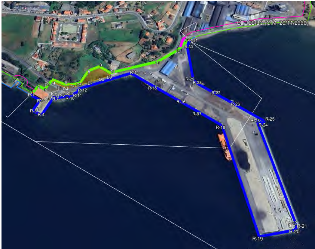
Montaje general tramo y zona a declarar innecesaria. (Fuente: Google Earth)
