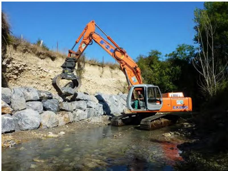
*Ilustración 1. Excavadora realizando una escollera en río*
