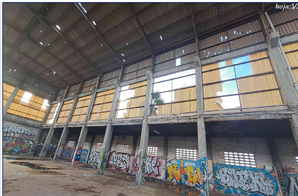
Laminas de fibra de vidrio desprendidas de laterales
