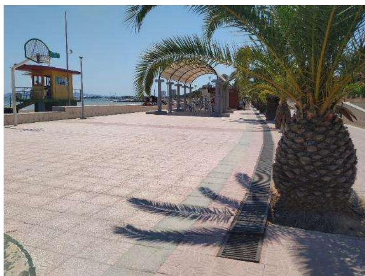
Vista general del imbornal corrido situado en el Paseo de Castillitos.
