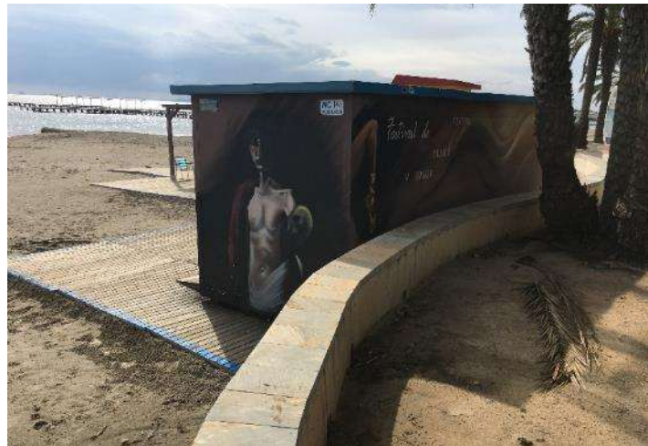
Vista general del aseo público.
