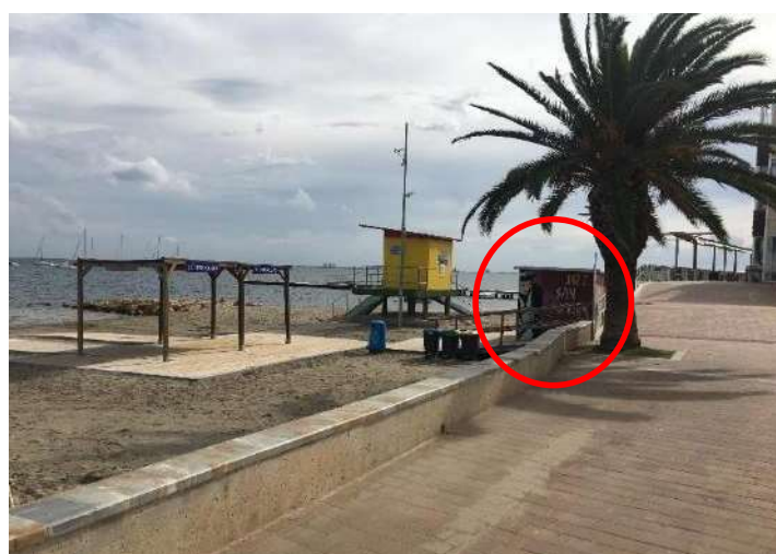
Vista general del aseo público.
