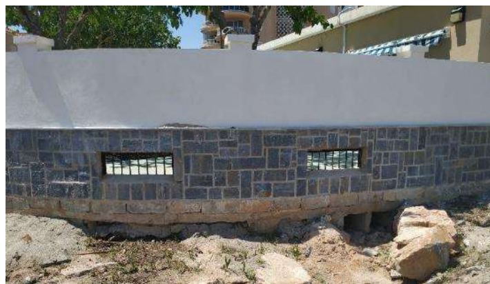
Conducción en el punto de vertido.
