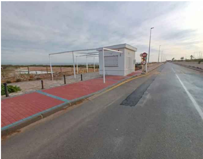
Vista de la construcción de Puerto desde donde se harán las conexiones
