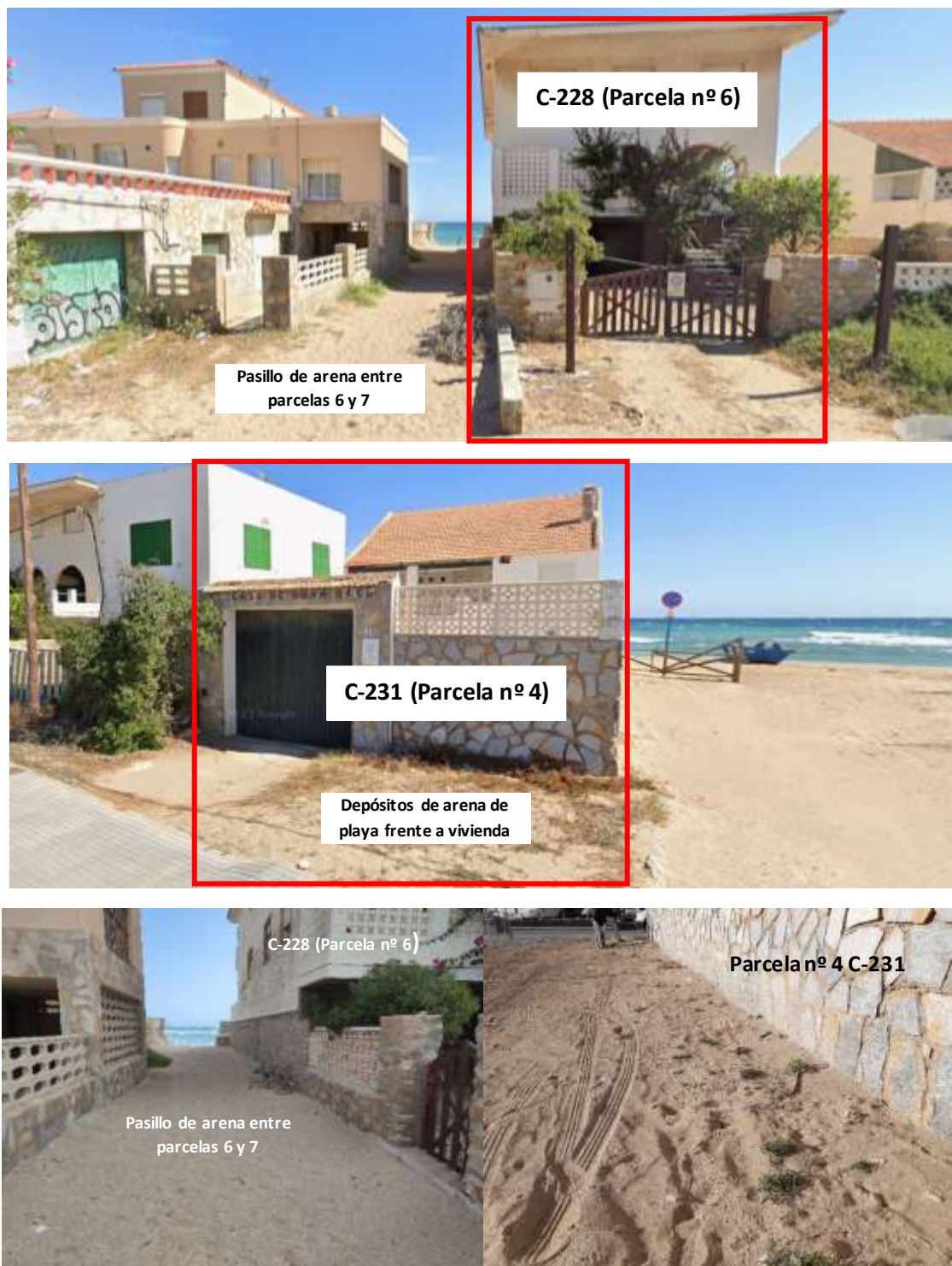
Figura 5. Reportaje fotográfico de las parcelas de deslinde nº4, nº5 y nº6. Se aprecia como las dos edificaciones quedan flanqueadas por todos sus vientos por arena de playa.
