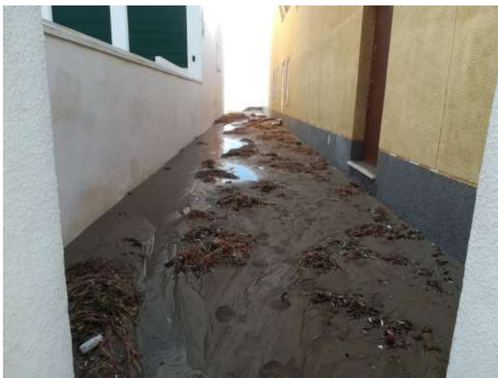
Figura 16. Pasillo de arena (parcela 13), durante temporal 2020.
