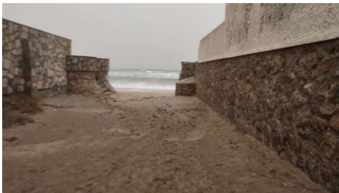
Figura 12. Pasillo de arena entre parcelas 6 y 7.
