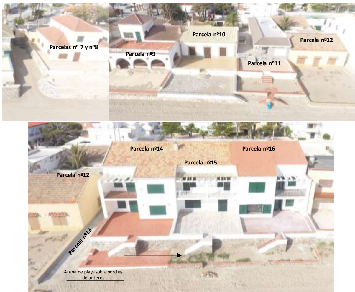
Figura 9. Vista aérea de las parcelas nº 7 a 16. Se observa como la arena de playa se acumula en la parte delantera de las viviendas
