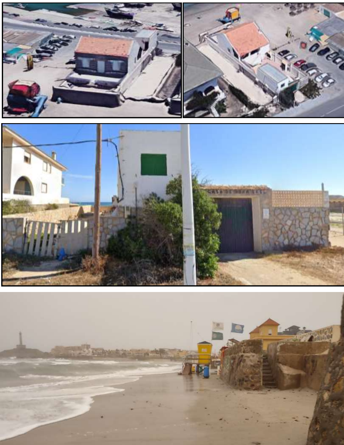
Figura 4. Parcela nº 4 y 5 de deslinde (C-231 MU). Superior izquierda: Fachada norte. Superior derecha: Fachada sur. Intermedia: Vista fachada sur desde carretera subida al Faro. Inferior: Vista fachada norte durante el temporal Gloria. Fuente: Google Earth y elaboración propia.
