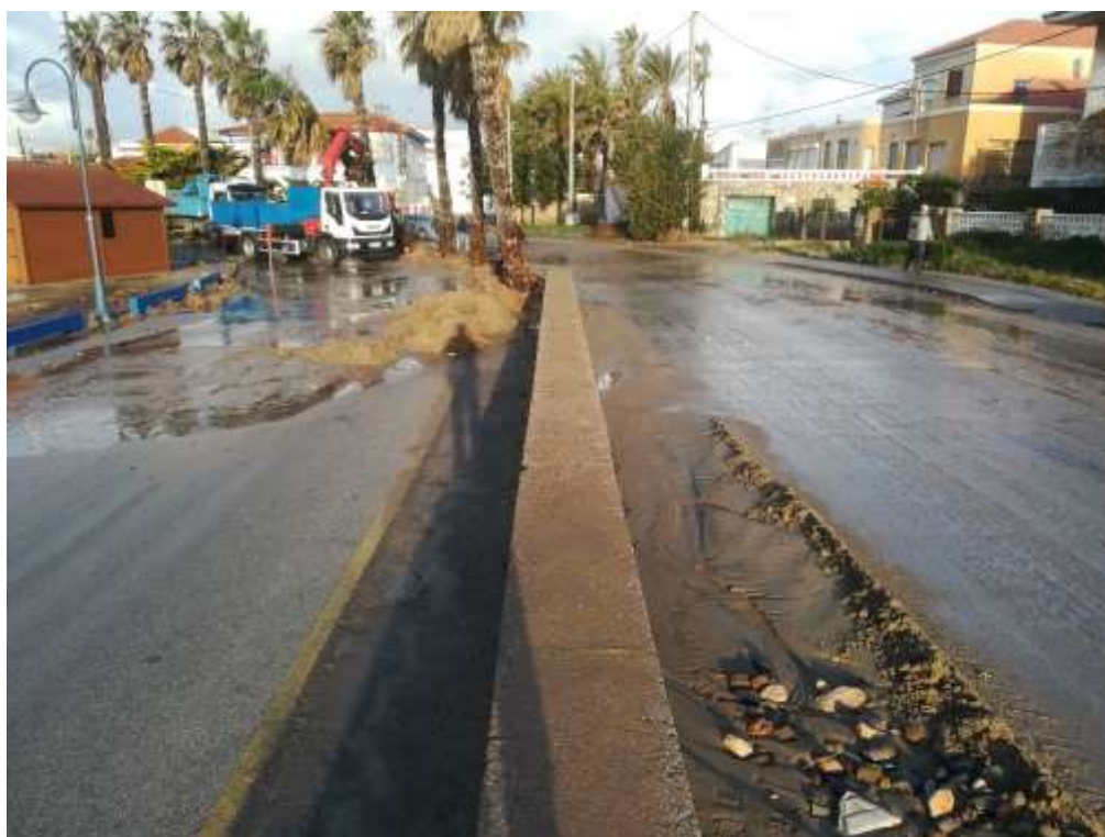
Figura 6. Mediana entre carretera del puerto y carretera del faro, durante temporal 2020.
