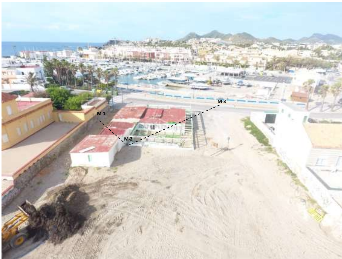
Figura 4. Vista aérea de la parcela nº 3, antes de la demolición del conocido restaurante KATY. Se marca la alineación del deslinde de ZMT de 1960 (línea negra discontinua) entre los vértices M-1 a M-3.
