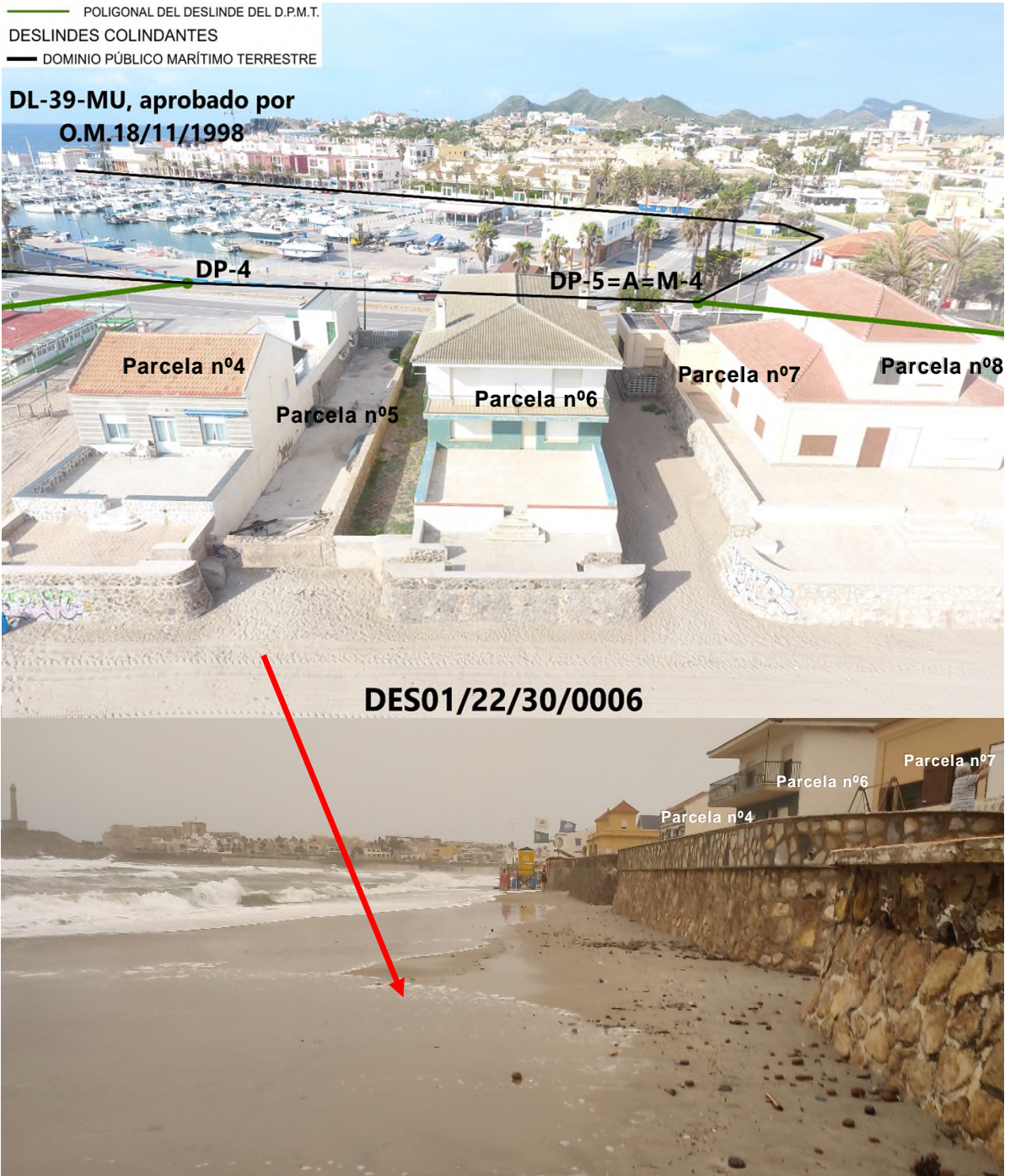
Figura.23. Imagen superior, fotografía aérea de la parcela 4, 6 y 7 del proyecto de deslinde. Fuente Demarcación de Costas. Imagen inferior fotografía de fachada litoral de las parcelas 4, 6 y 7 donde se aprecia el fuerte oleaje que azota la playa debido a la existencia de fuertes vientos de Levante, con restos de arribazones de posesidonia.
