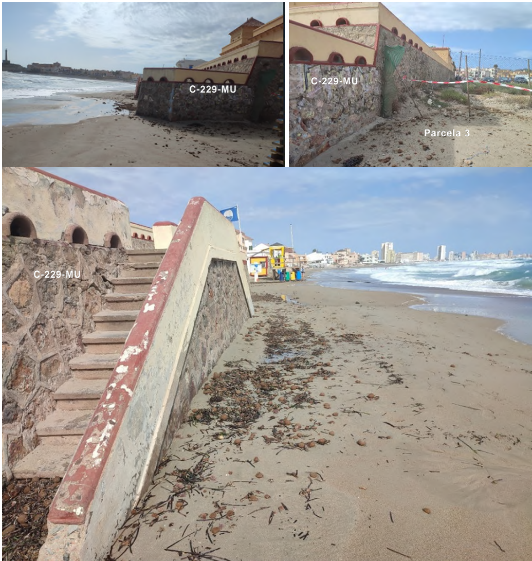
Figura.32. Imagen superior izquierda. Vista de la parcela nº1 y nº2 de la fachada frente al mar. Imagen superior derecha. Vista de la fachada oeste de la concesión C-229-MU, donde se observan restos de arena y posidonia que evidencian que los terrenos forman parte de la Playa de Levante. Imagen inferior. Vista de la fachada que da al mar de la concesión C-229-MU, donde se observa el efecto del oleaje sobre el muro de la fachada, depositando restos de vegetación marina y arena sobre la escalera que da acceso a la terraza de la vivienda.
