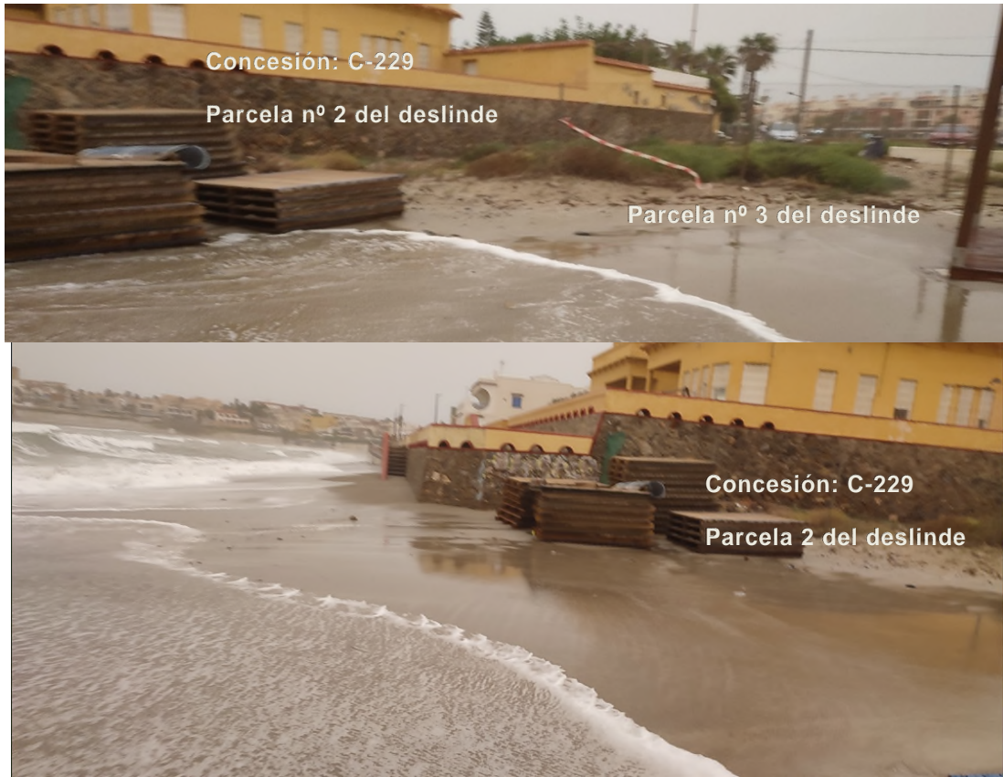
Figura.21. Imagen superior, fotografía aérea, donde se aprecia el antiguo restaurante Katy. Fuente: Demarcación de Costas de Murcia, Imagen del medio: Fotografía de campo 03/09/2023. Imagen inferior: Fotografía de campo 03/09/2023.
