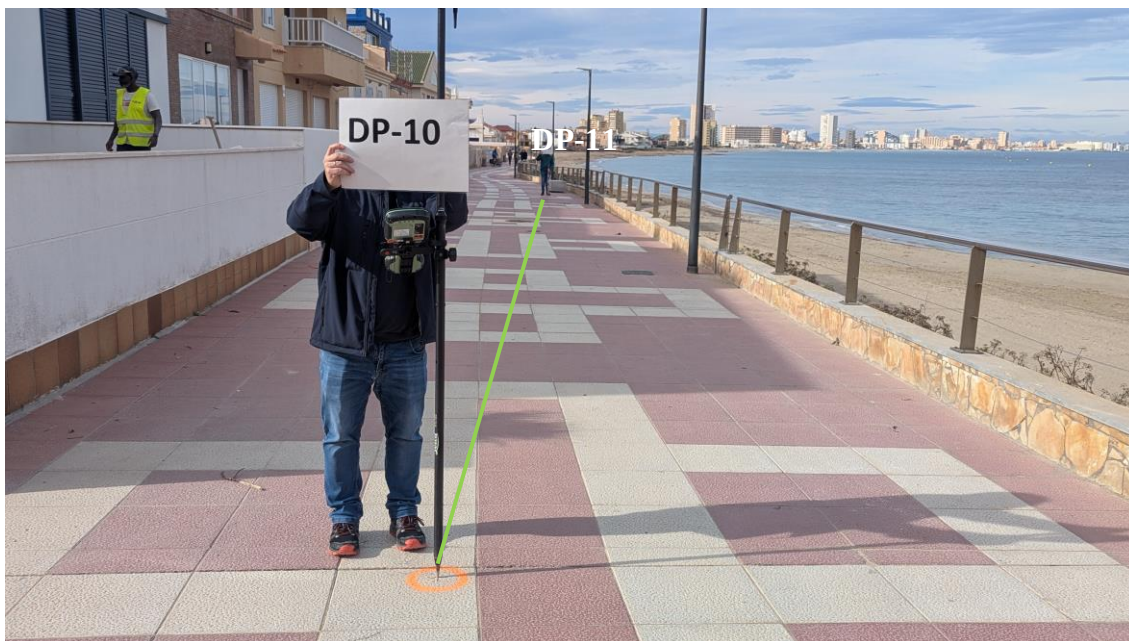
Figura 9. Tramo DP-10 a DP-11
