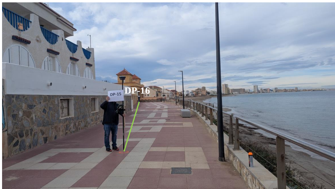
Figura 14. Tramo DP-15 a DP-16
