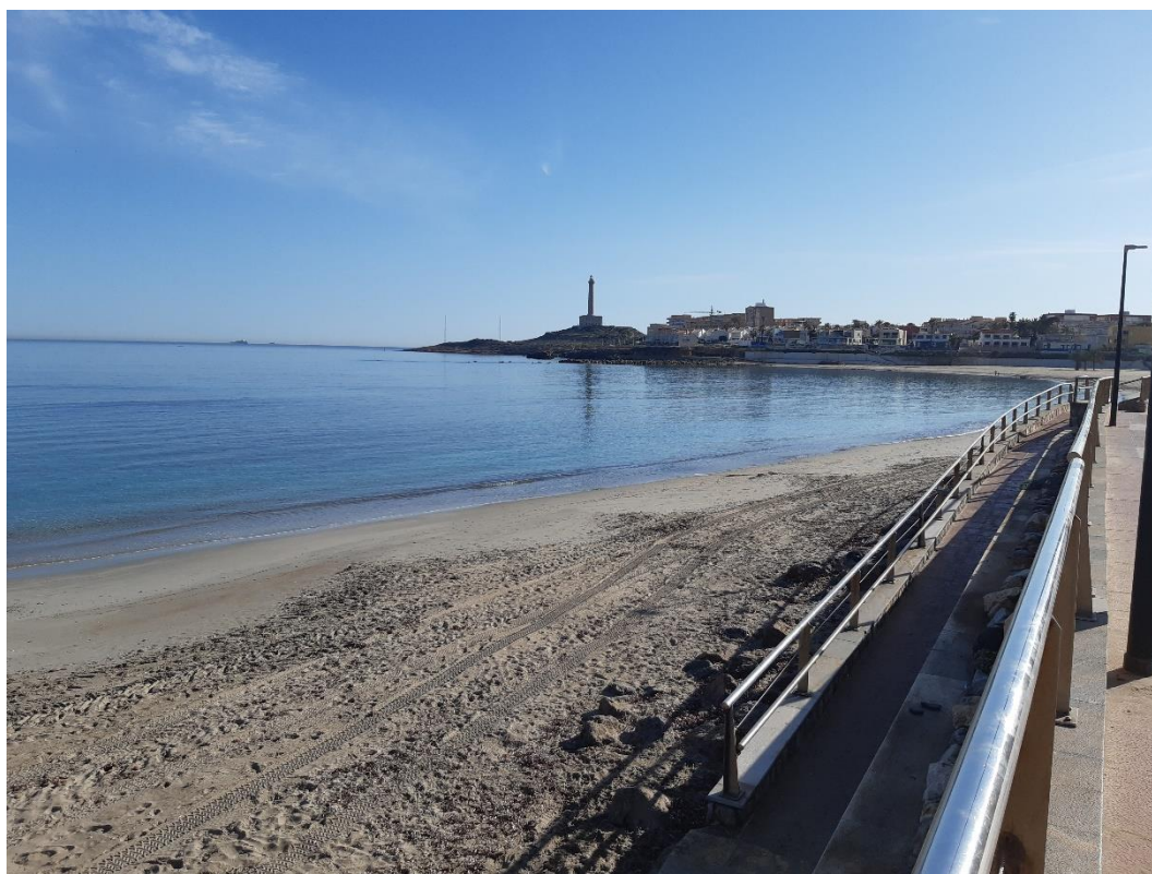
Figura 8. Vista hacia el este de la Playa de Levante, a la altura del vértice DP-16.
