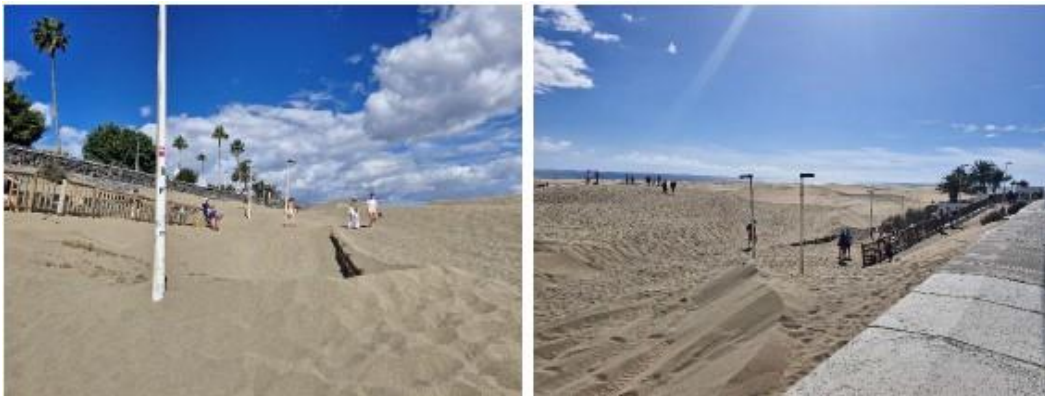
Figura 1. Desbordamiento de arena en el tramo del Paseo Costa Canaria.
