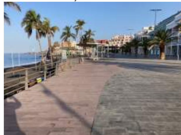
Paseo marítimo en buen estado, remodelado en 2013
