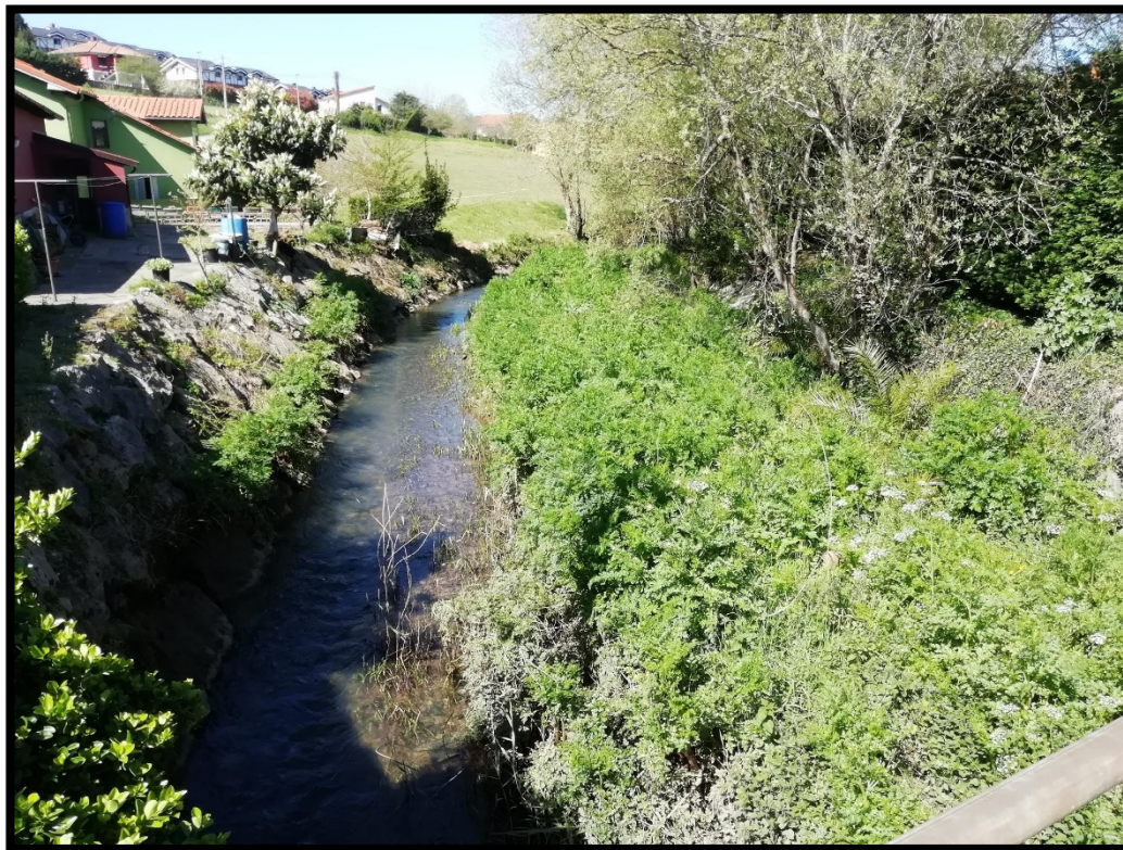
Imagen 1.- Depósitos de sedimentos aguas arriba del puente C/ El Borroñal
