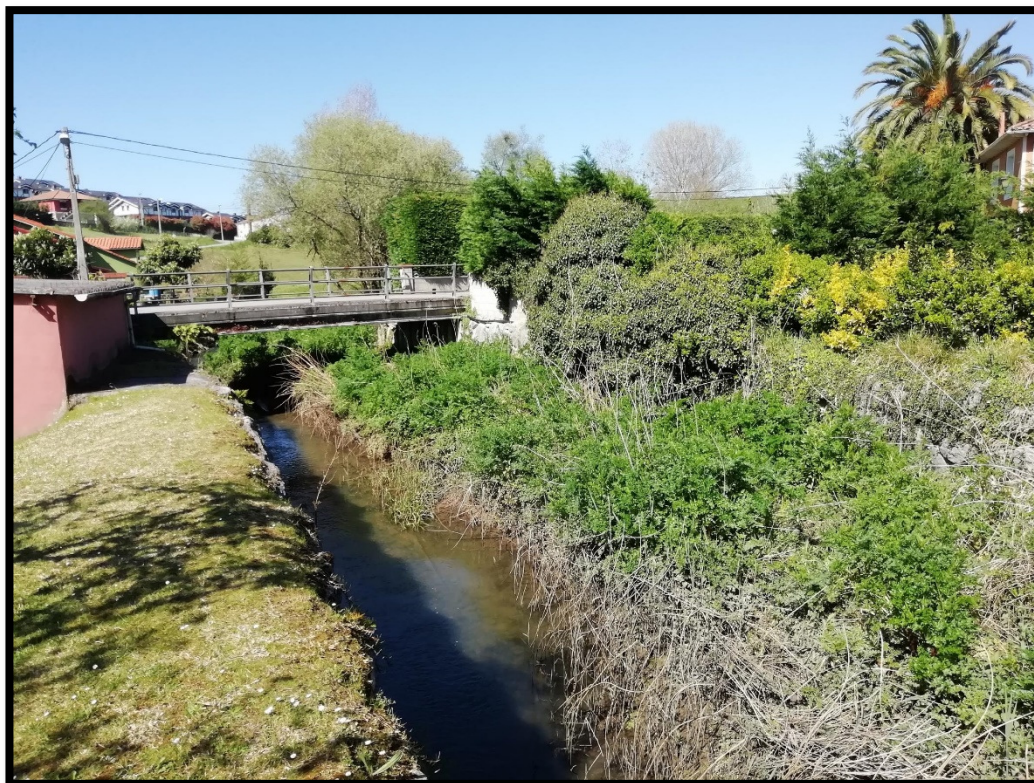
Imagen 2.- Depósitos de sedimentos aguas abajo del puente C/ El Borroñal
