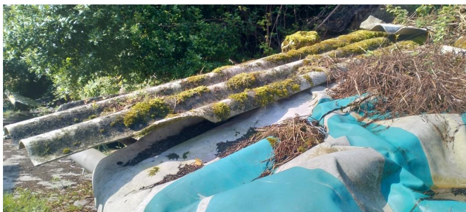
Estado de conservación de la cubierta de fibrocemento.
