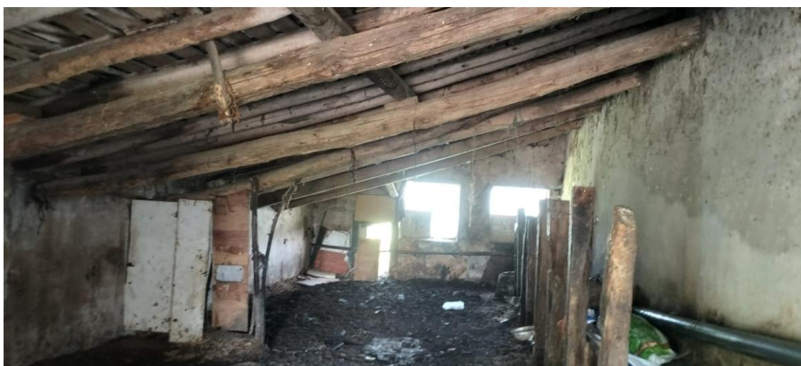
Detalle de vigas y correas de cubierta de madera.
