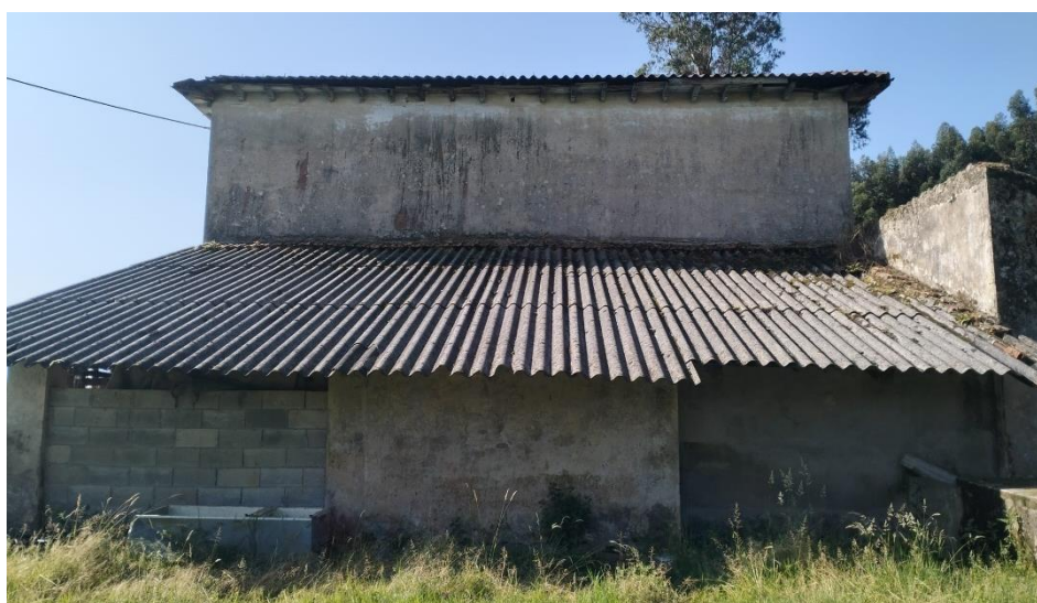
Cubierta de fibrocemento del edificio principal.
