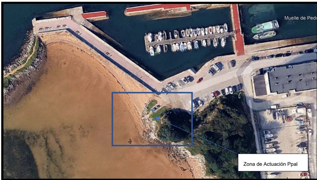
Figura 3. Fotografía Aérea de la Zona de Actuación.
