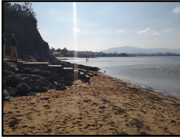
Figura 5. Detalle de Escaleras Existentes NO Accesibles.
