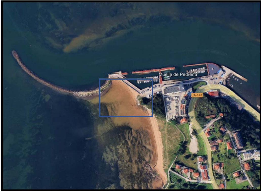
Figura 1. Imagen Aérea Emplazamiento de Actuación.
