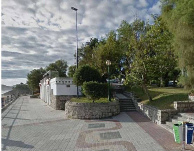
Encuentro del edificio con los accesos al parque, evidenciando su encaje en la topografía existente.
