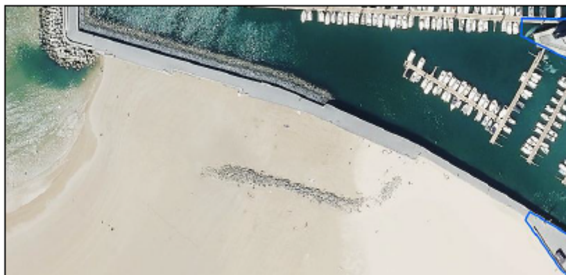
Escollera existente sobre la playa de Laredo o de Salvé (fuente: visor DPMT)
