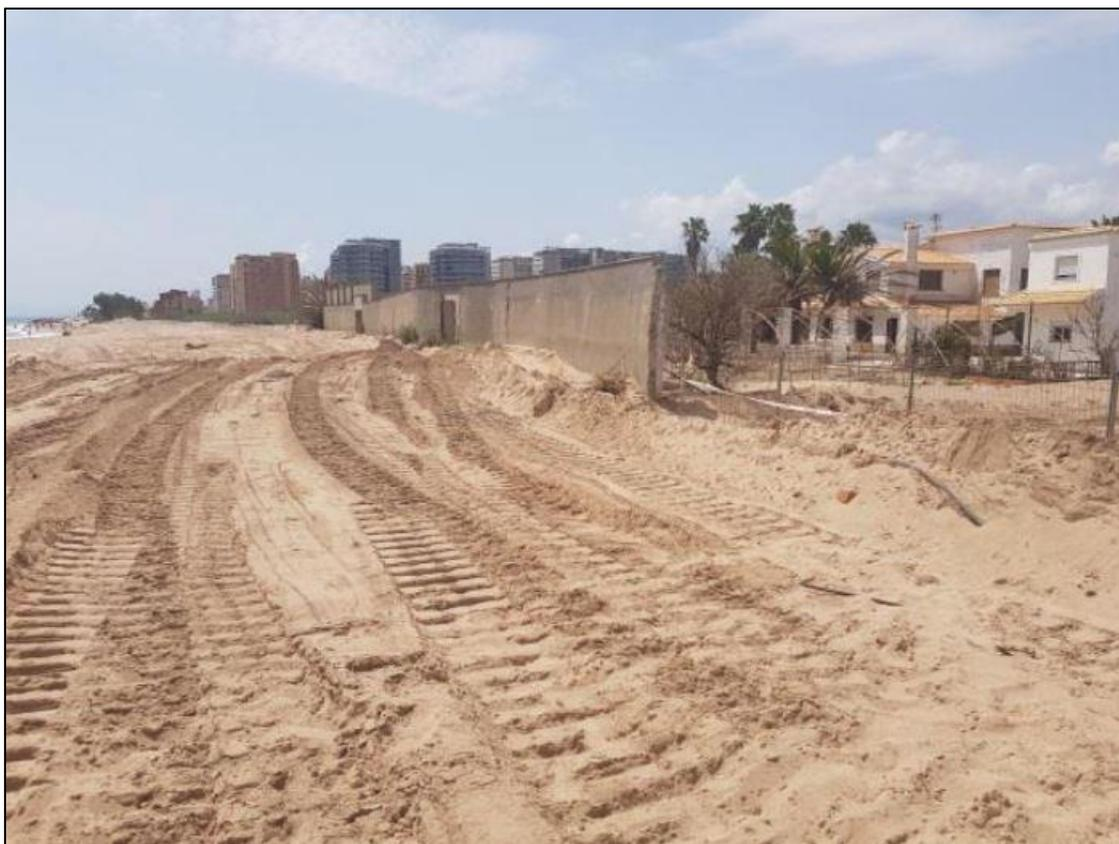
Figura 33. Detalle del derribo parcial del muro perimetral de una parcela ubicada en la zona sur de estudio tras el temporal de 2020.
