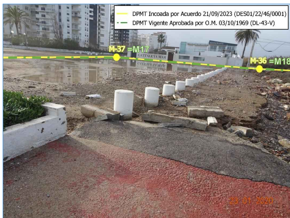
Figura 15. Afección del temporal "Gloria" en enero de 2020 entre vértices M-35 y M-38.
