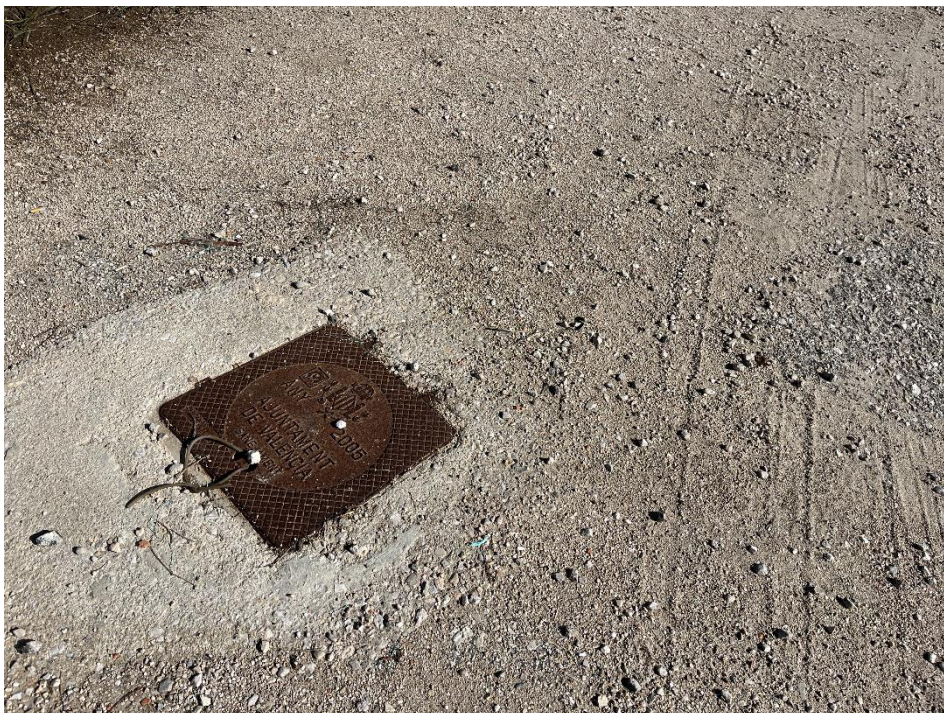
Ilustración 2. Arqueta existente ubicada en el punto donde se instalarán los módulos.
