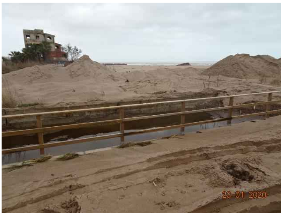
Fotografía 30. Afección del temporal "Gloria", vértices M-462 y M-474.
