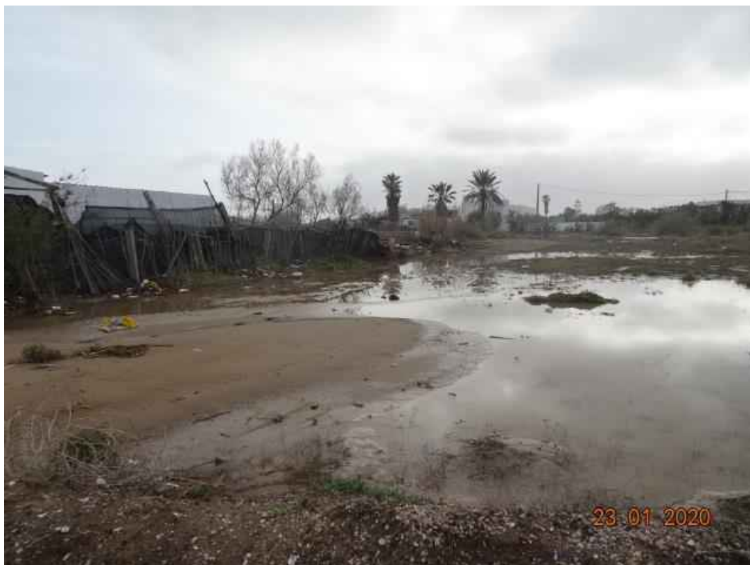
Fotografía 19. Afección del temporal "Gloria", vértices M-446 y M-447.
