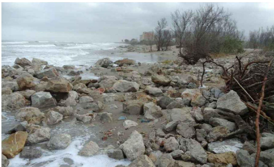
Fotografía 26. Afección del temporal “Gloria”, vértices M-456 y M-457.
