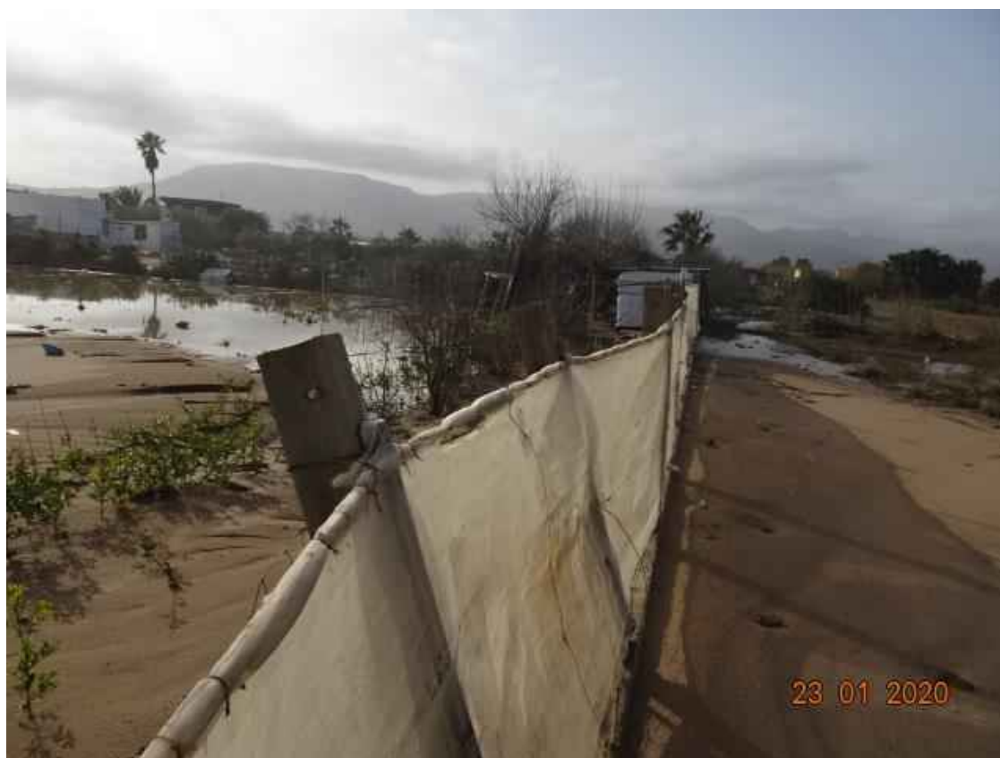
Fotografía 10. Afección del temporal “Gloria”, vértices M-446 y M-447.
