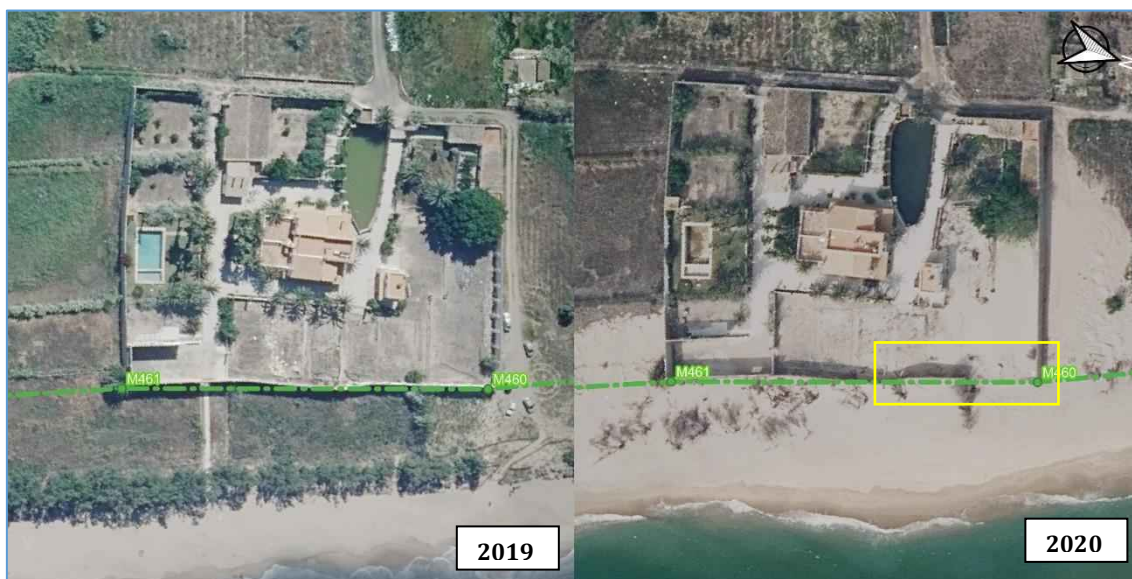
Figura 32. Muro perimetral en la zona sur de estudio en 2019 (izq.) y tras el temporal de 2020 (dcha.).
