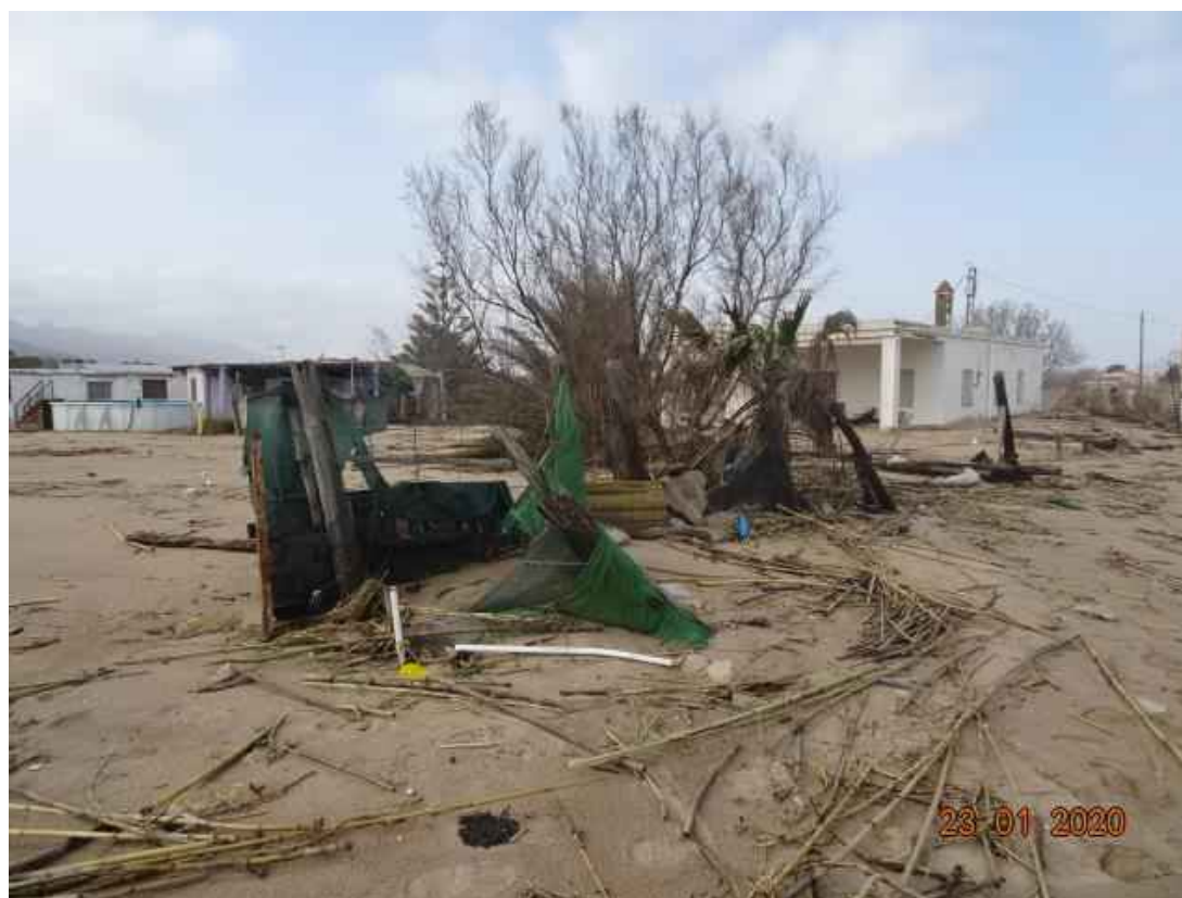
Fotografía 22. Afección del temporal “Gloria”, vértices M-446 y M-447.
