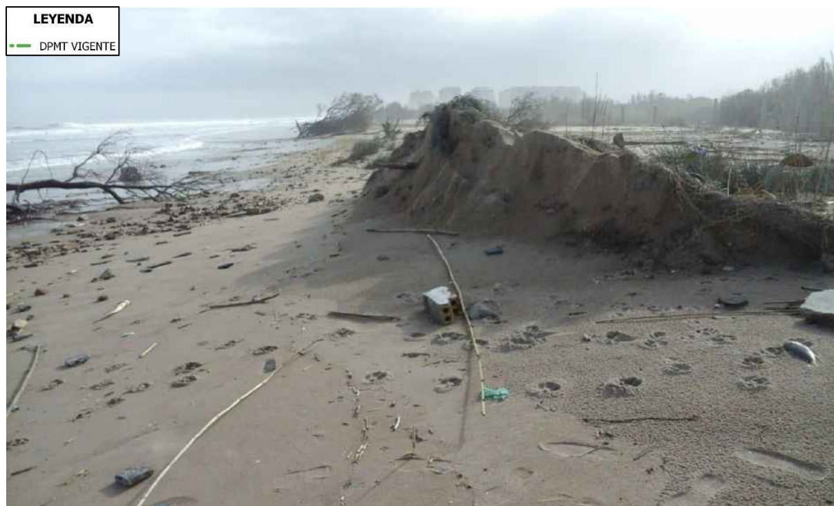
Fotografía 24. Afección del temporal "Gloria", vértices M-447 y M-449.
