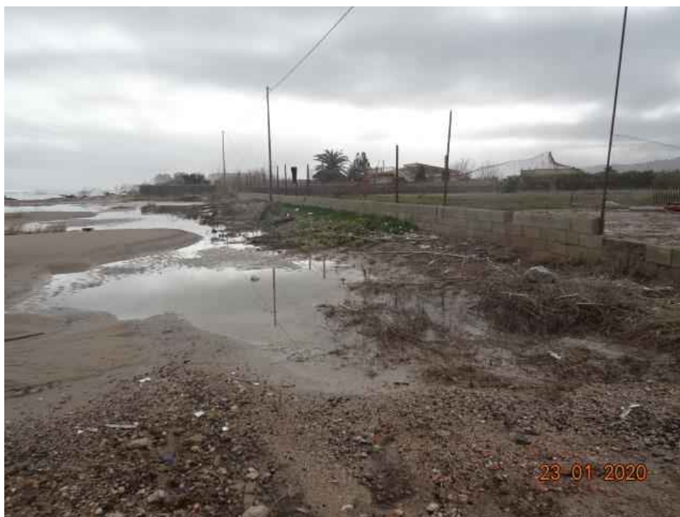
Fotografía 5. Afección del temporal “Gloria”, vértices M-441 y M-443.
