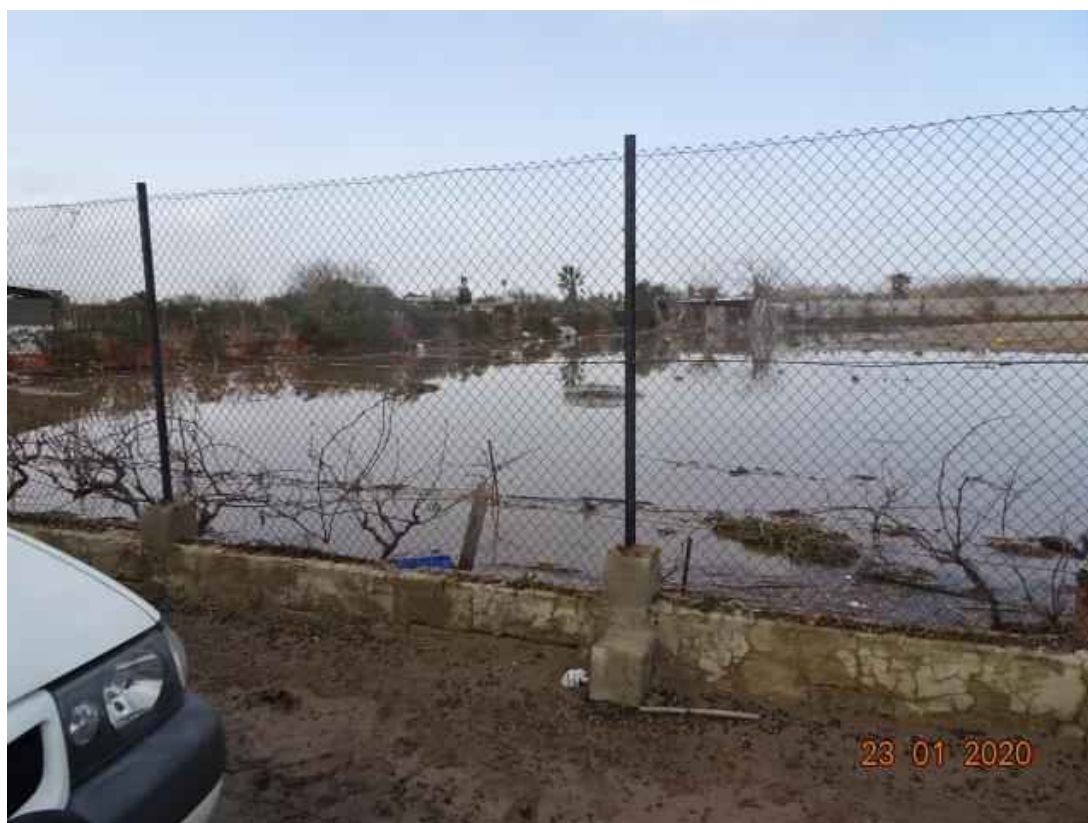
Fotografía 17. Afección del temporal "Gloria", vértices M-446 y M-447.
