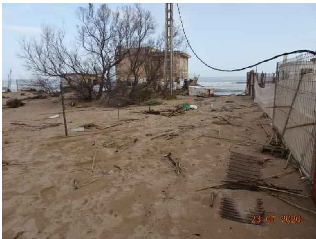
Fotografía 14. Afección del temporal “Gloria”, vértices M-446 y M-447.
