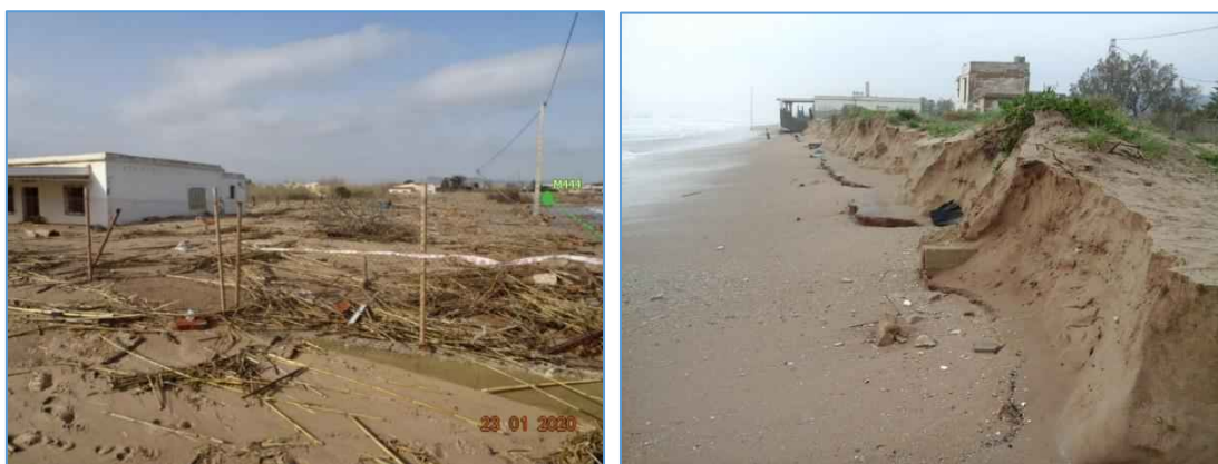
Figura 28. Afección de los temporales en dunas de la zona de estudio, provocando su descalce o deterioro.
