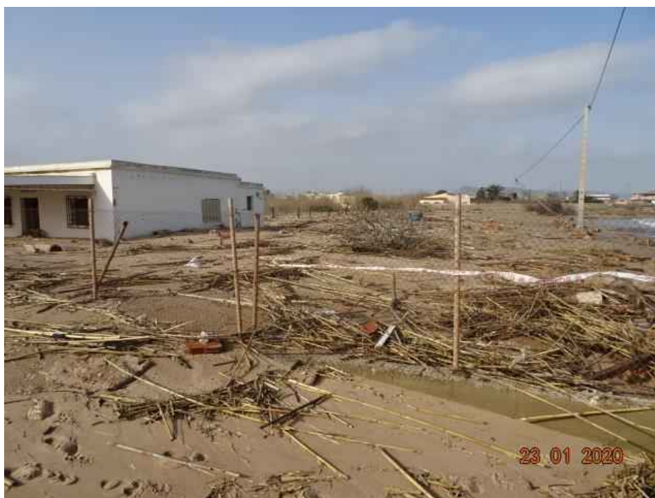
Fotografía 6. Afección del temporal “Gloria”, vértices M-444 y M-445.
