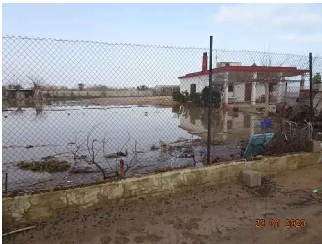
Fotografía 16. Afección del temporal “Gloria”, vértices M-446 y M-447.
