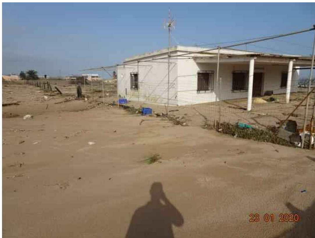
Fotografía 7. Afección del temporal "Gloria", vértices M-444 y M-445.
