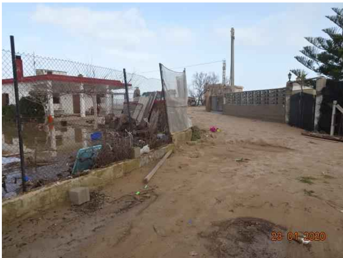
Fotografía 15. Afección del temporal “Gloria”, vértices M-446 y M-447.
