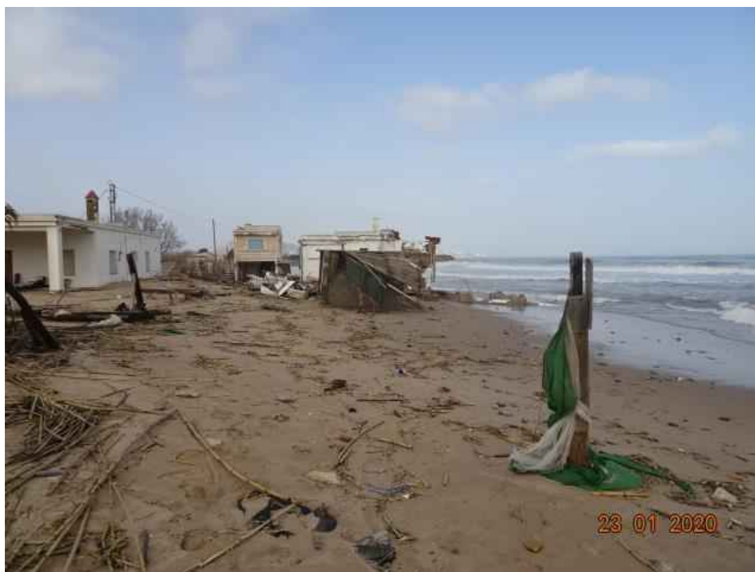
Fotografía 21. Afección del temporal “Gloria”, vértices M-446 y M-447.
