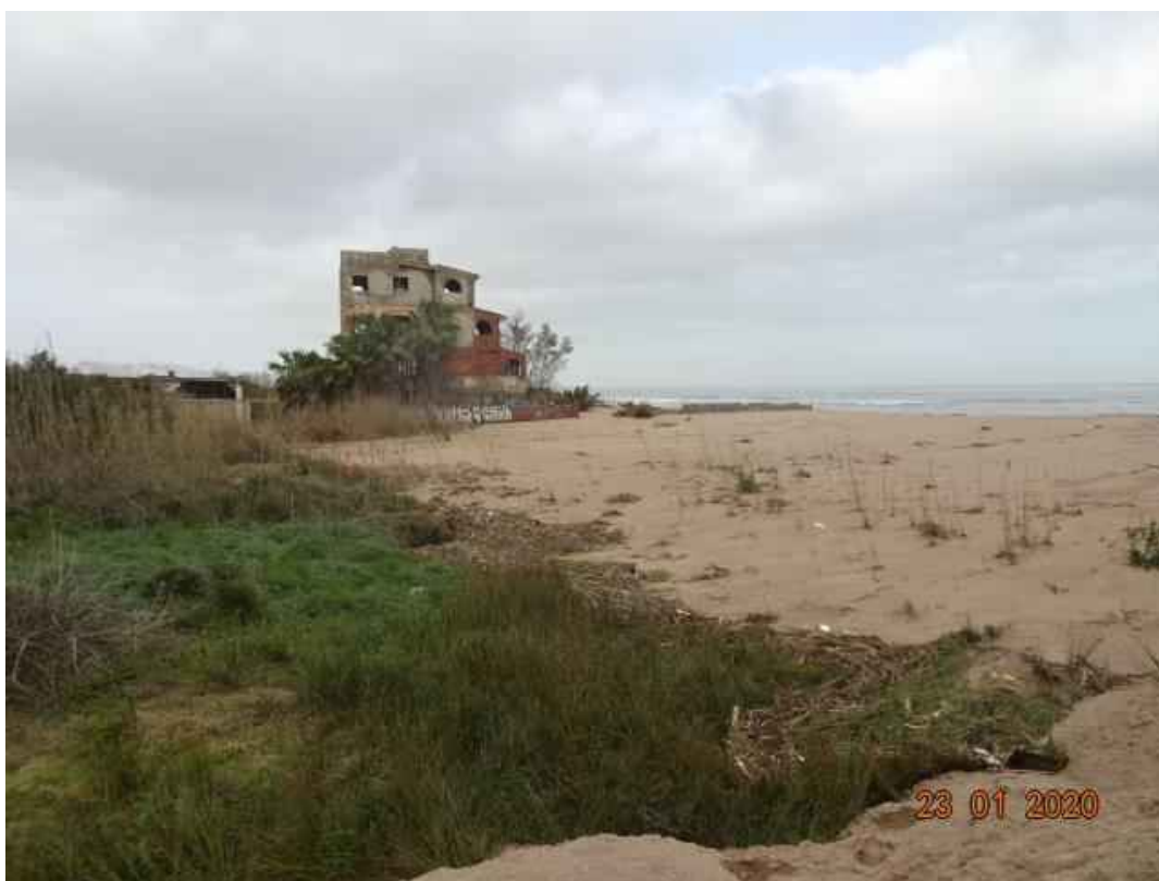
Fotografía 29. Afección del temporal "Gloria", vértices M-462 y M-474.
