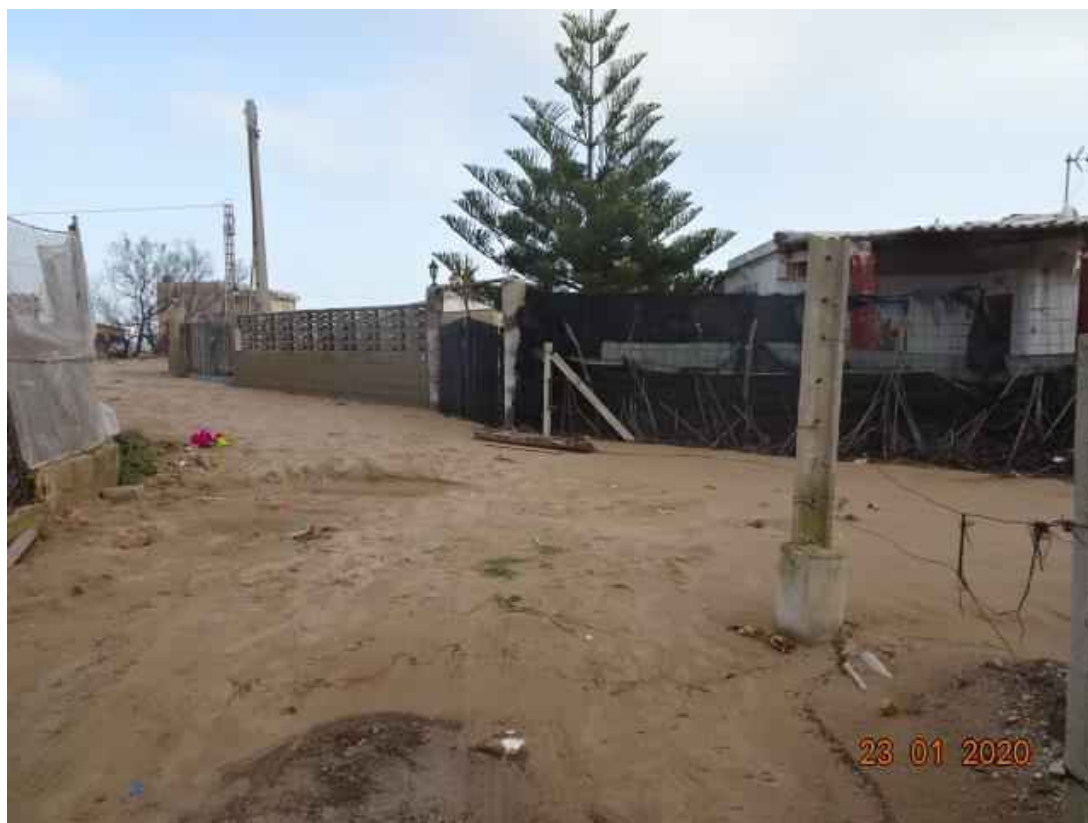
Fotografía 18. Afección del temporal "Gloria", vértices M-446 y M-447.
