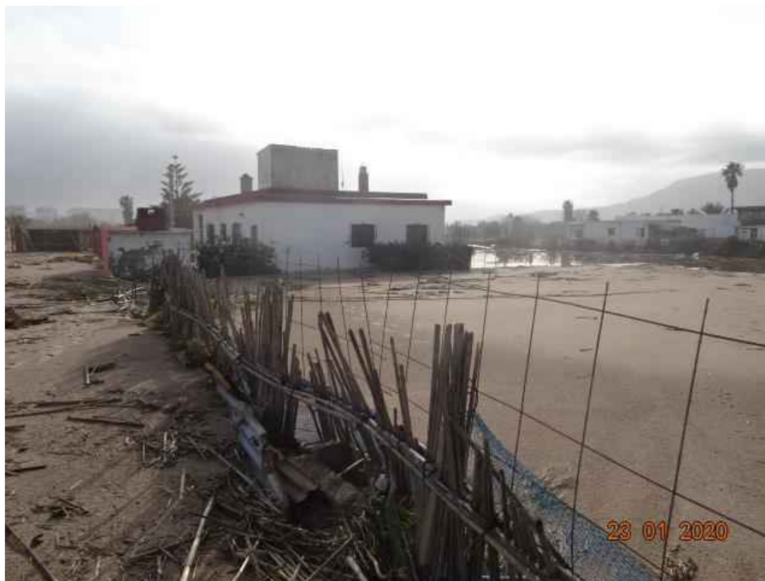
Fotografía 8. Afección del temporal "Gloria", vértices M-446 y M-447.
