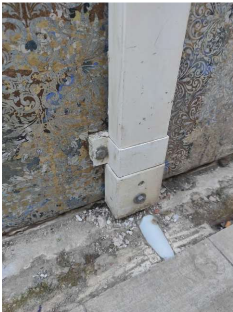
Anclaje de la pérgola al suelo
