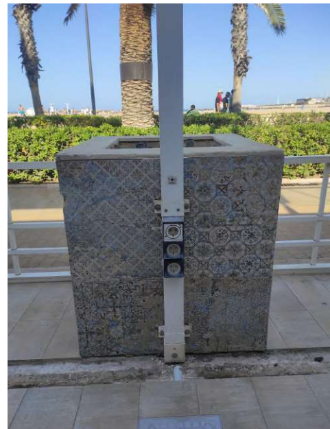
Anclaje de la pérgola al macetero
