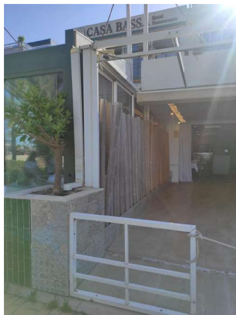
Evacuación de aguas y valla exterior
