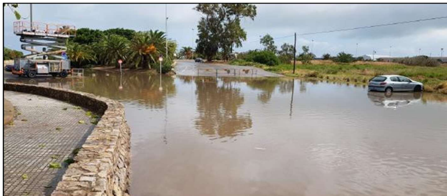
*Foto archivo: Acumulación de agua pluvial en la zona previa al canal
