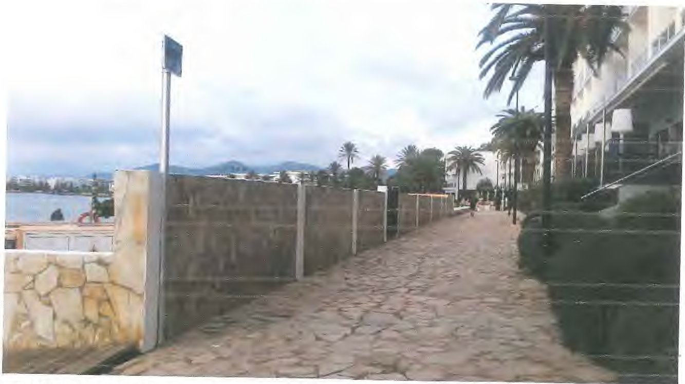
F-20: Vista en dirección este del lado de la piscina paralelo al paseo. El muro está aplacado con piedra natural de las mismas características del pavimento, quedando plenamente integrado con las características arquitectónicas del entorno.
