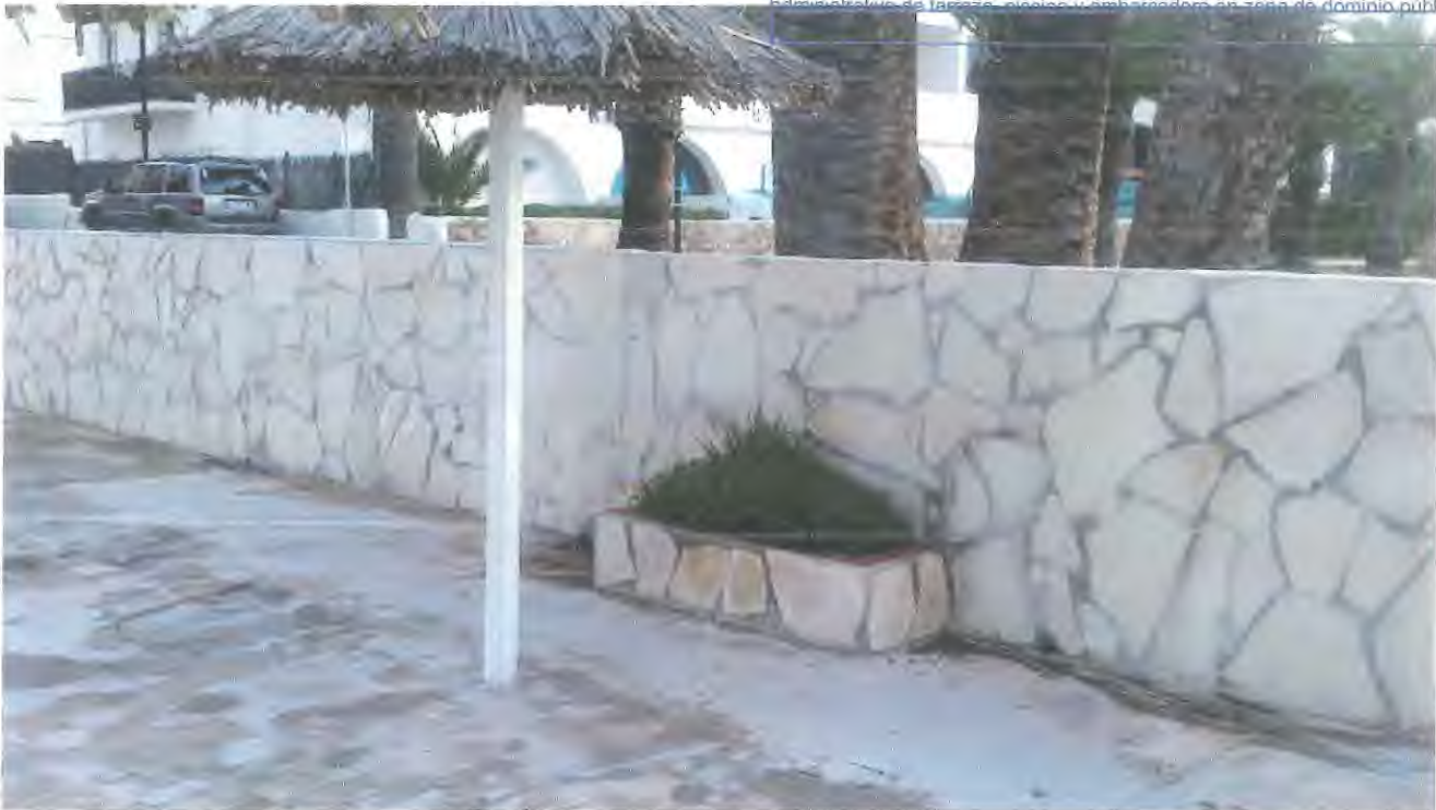
F-27: Vista en dirección este del aplacado del interior del muro con las jardineras adosadas.
