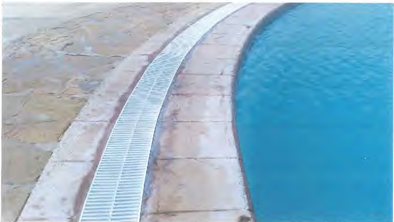
F-28: Vista en dirección sur. Detalle del borde de coronación de la piscina con el remate de la coronación con piedra, la canaleta de recogida de aguas incrustada y el pavimento de piedra natural circundante.
