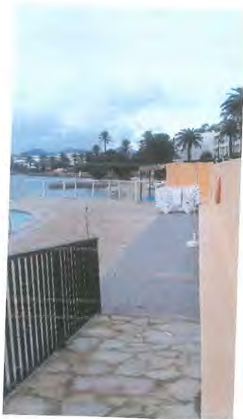
F-22: Vista en dirección este de rampa de acceso desde el paseo a la piscina.
