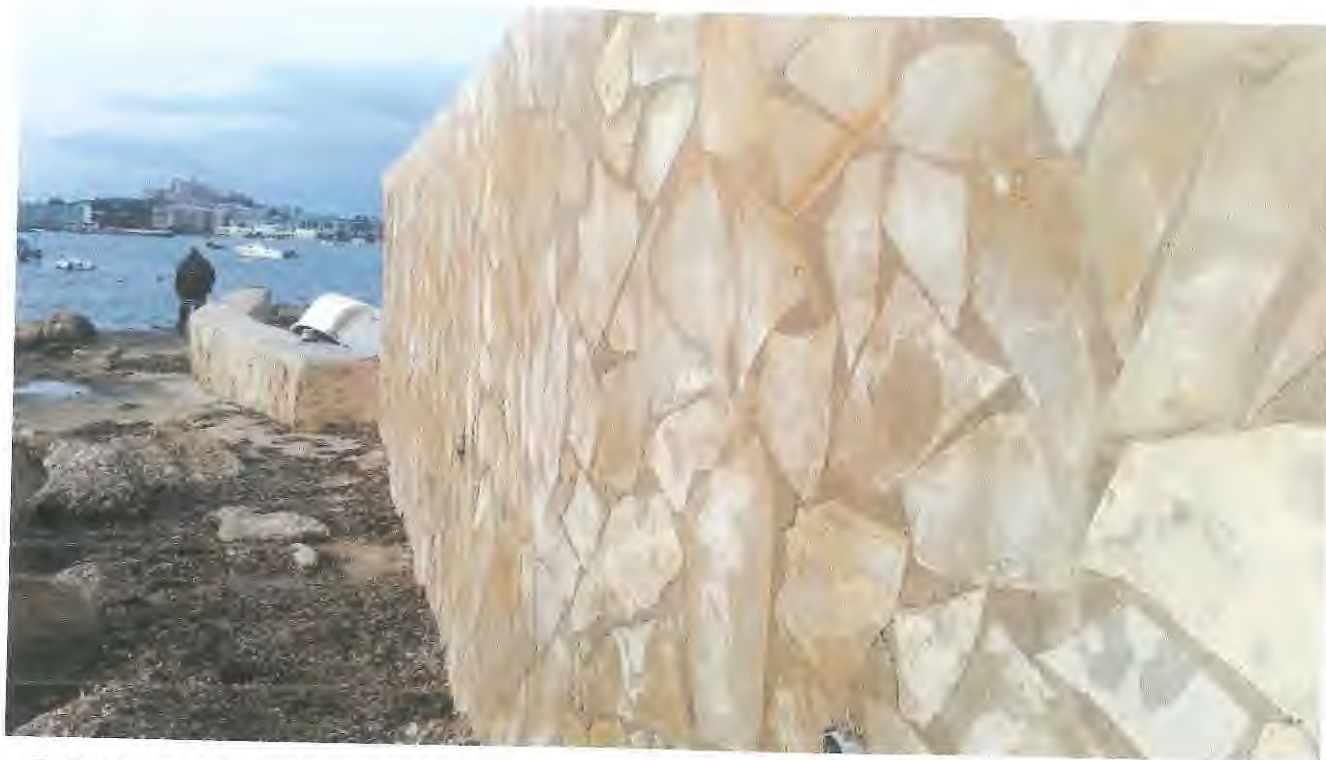
F-16: Vista en dirección suroeste del muro de la terraza de la piscina. Al fondo se aprecia el espaldón del dique.
