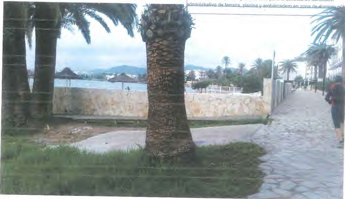
F-19: Vista en dirección oeste del paseo y de la piscina. En primer termino se pueden apreciar las rampas de acceso a la playa.
