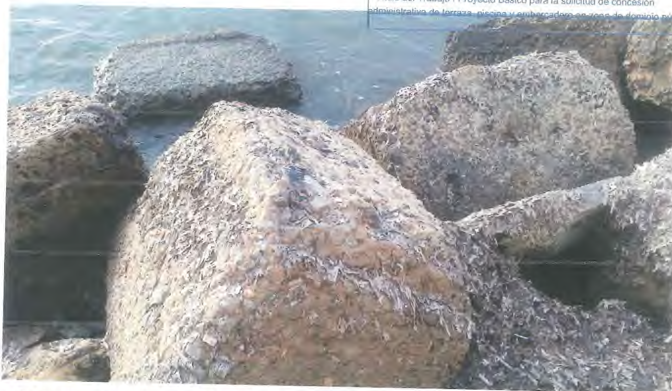
F-15: Vista en dirección sureste, detalle de la escollera.
