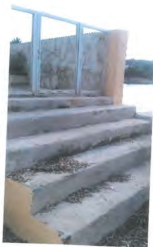
F-10: Vista en dirección este de escalera de acceso a la piscina desde el embarcadero.
