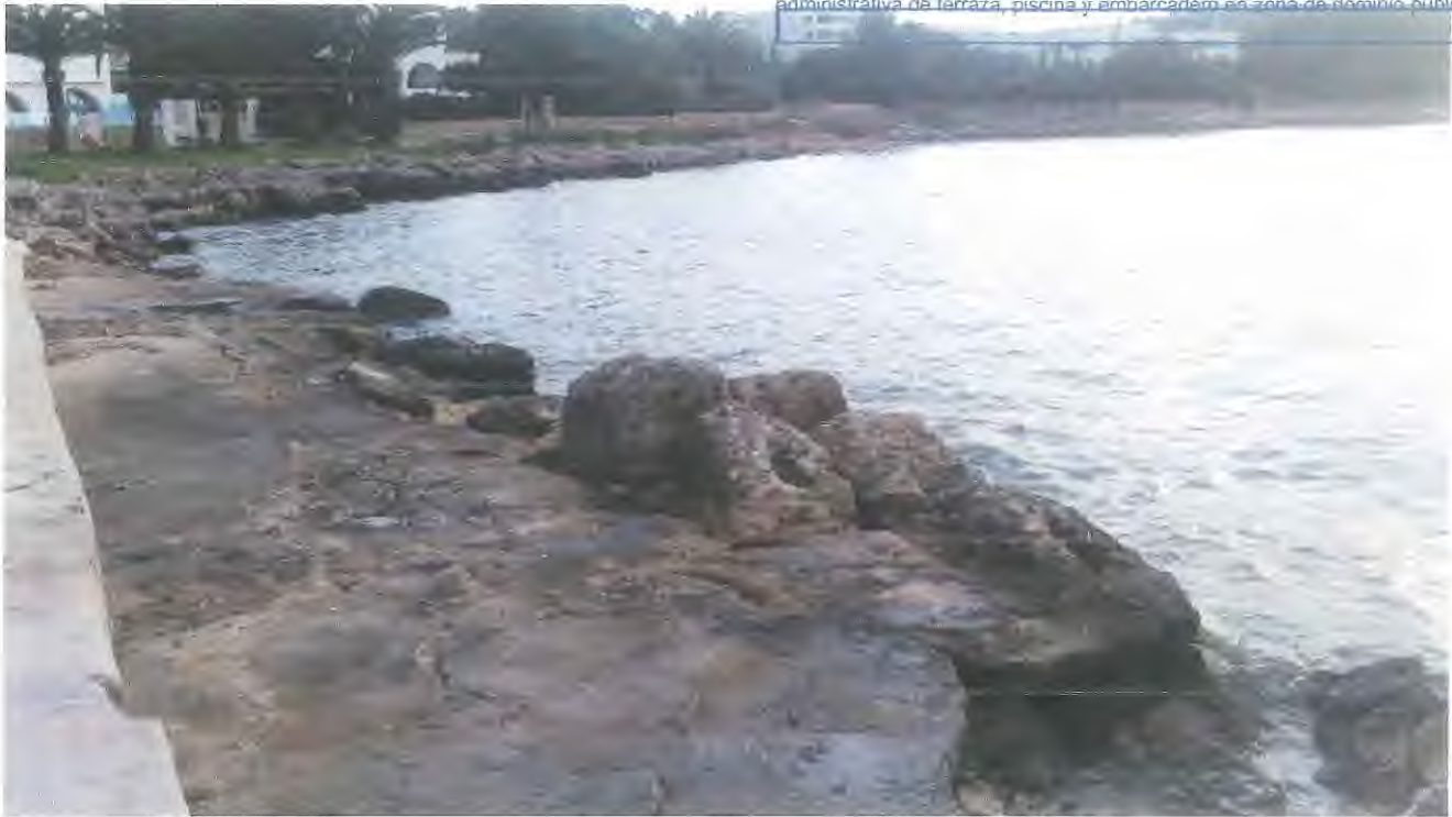
F-13: Vista en dirección este del lado exterior del embarcadero donde se aprecia los bloques de hormigón existentes formando la escollera.
