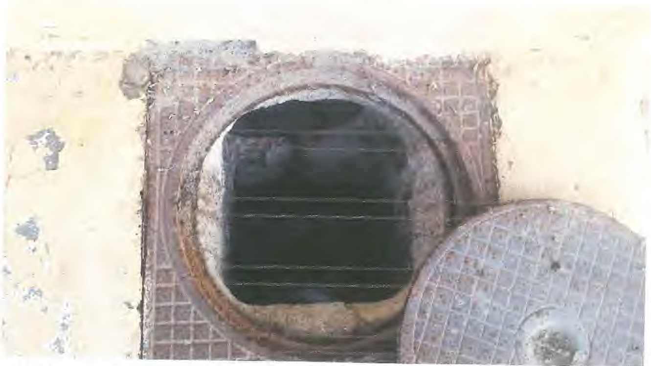
F-38: Vista en dirección noroeste de la arqueta de paso que conecta el desagüe de la piscina con la red de saneamiento, en la mitad del tramo que discurre por el paseo.
