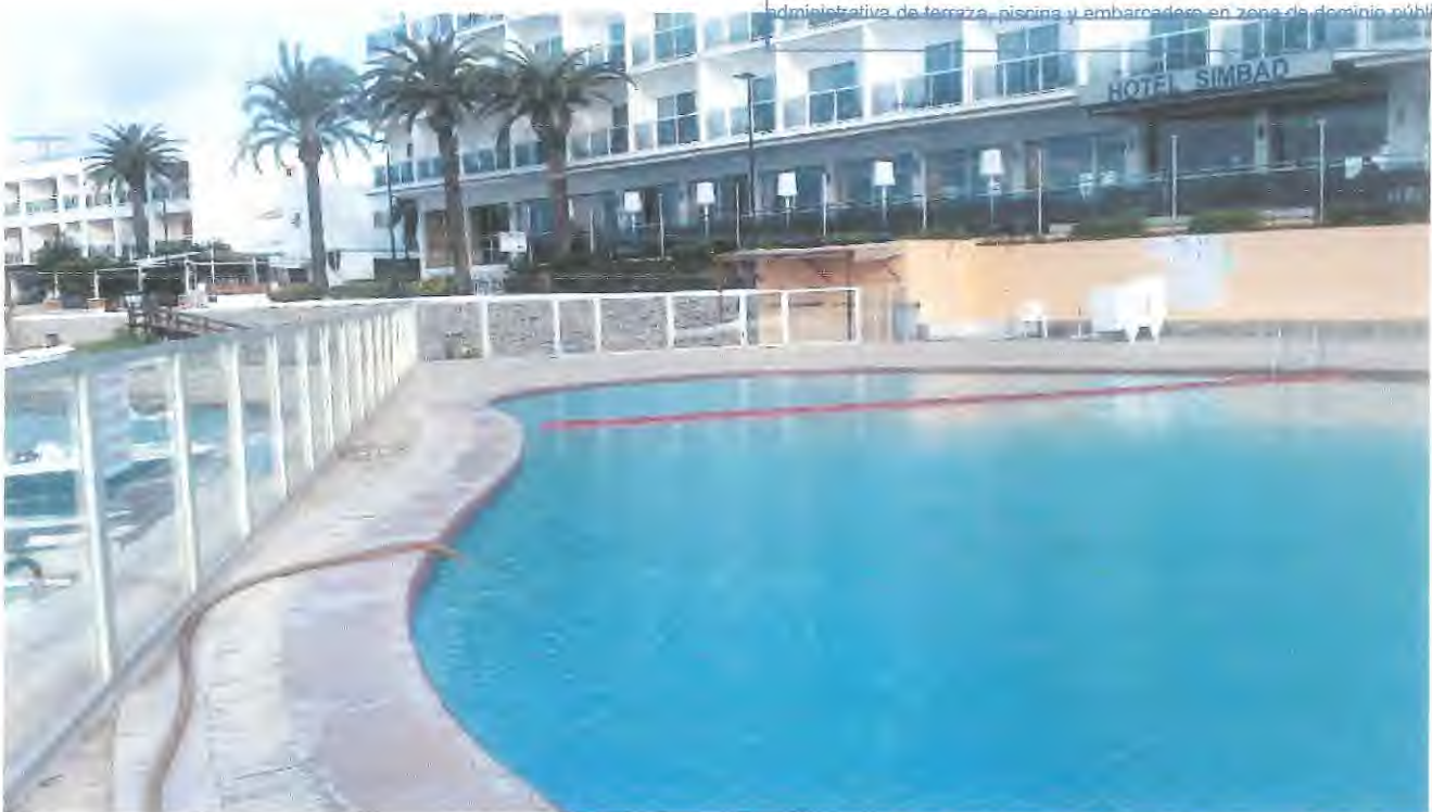
F-29: Vista en dirección noroeste de la terraza y piscina. En los lados sur y oeste de la piscina existe un cerramiento de un metro de altura de vidrio y aluminio que sirve de barandilla para salvar el desnivel existente.
