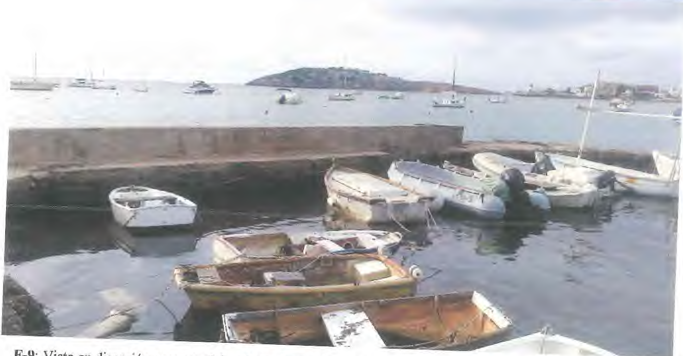
F-9: Vista en dirección suroeste del embarcadero existente.
