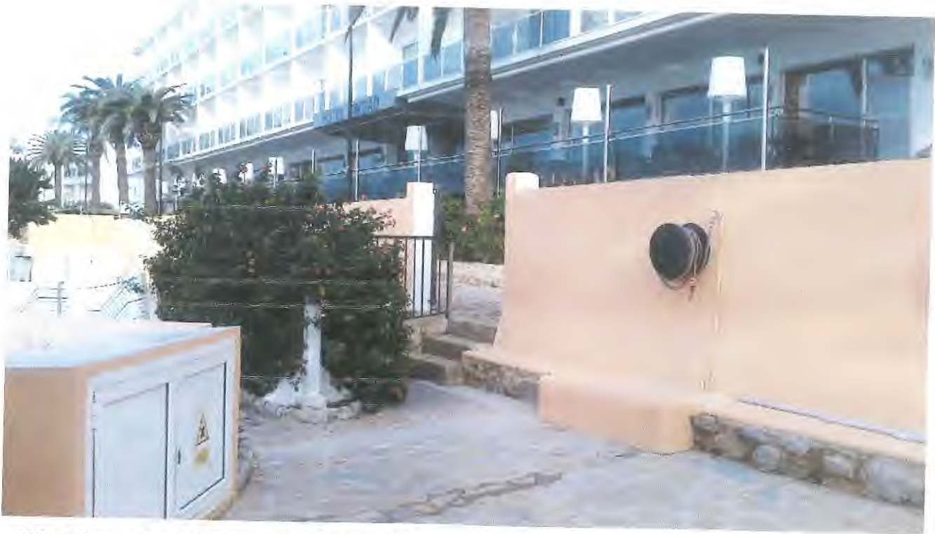
F-24: Vista en dirección noroeste de la escalera de acceso desde el paseo.
