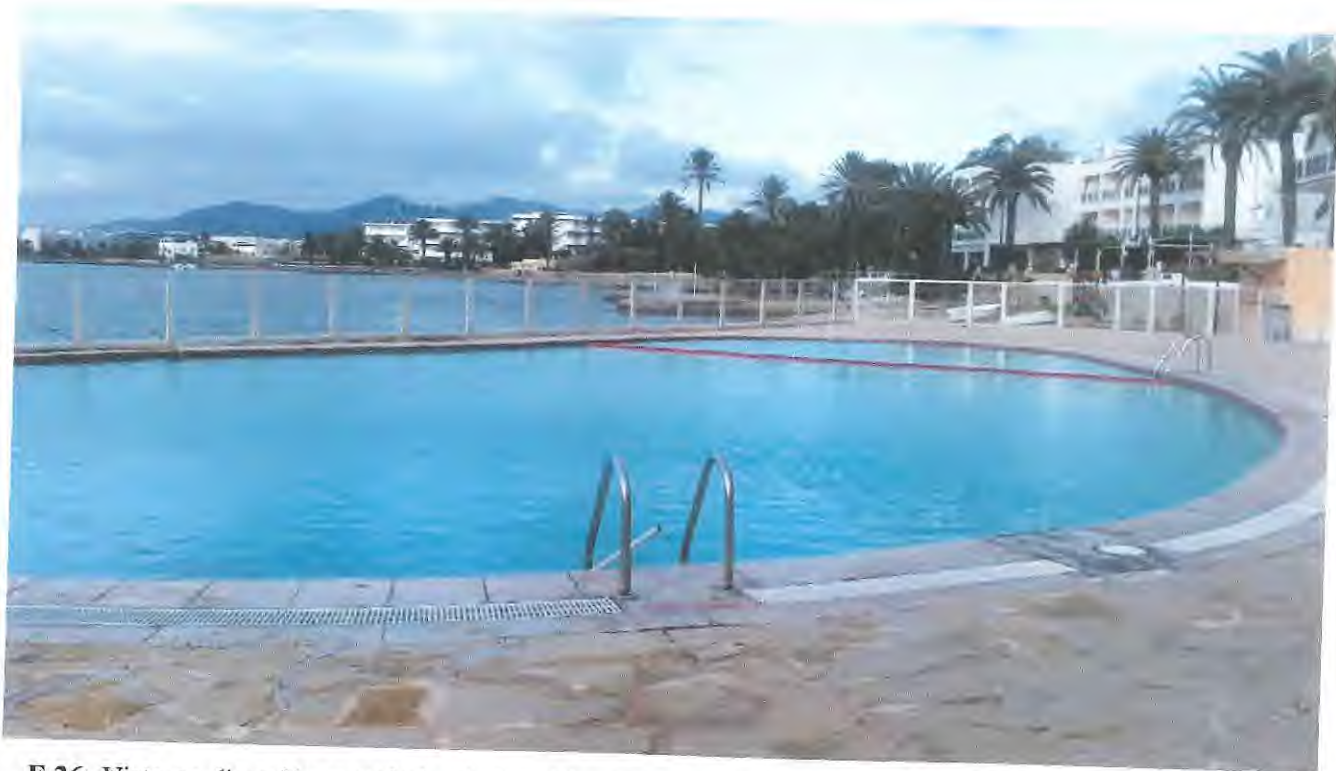
F-26: Vista en dirección este de la piscina. El pavimento que lo circunda es de piedra natural irregular de las mismas características del aplacado de muros y del pavimento del paseo.
