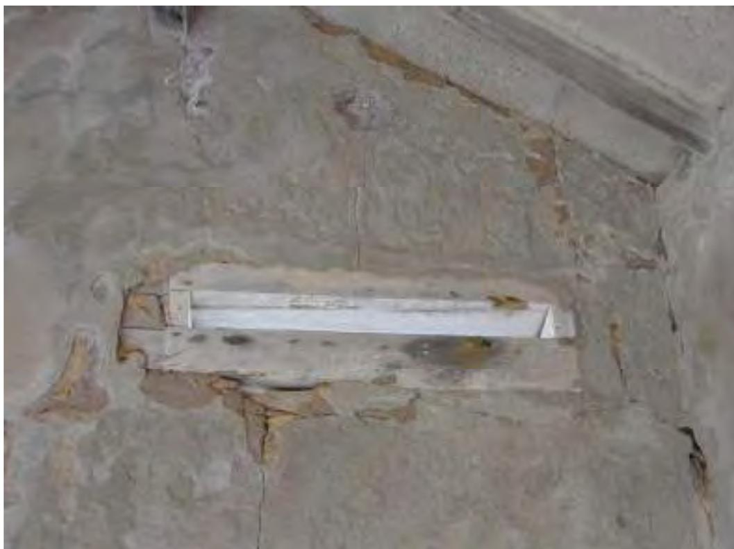
F.19. Detalle del interior, con la aspillera apaisada con marco de madera.
