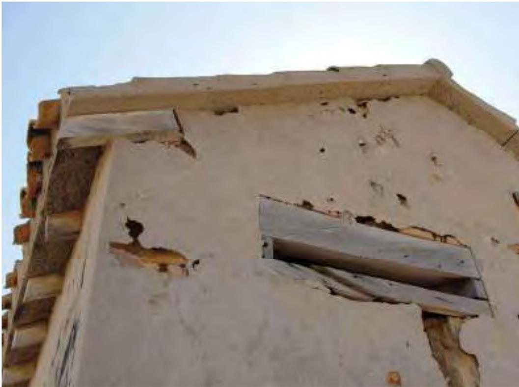
F.18. Detalle del testero, con la aspillera horizontal con marco de madera. Se aprecia uno de los falsos pares de la cubierta, que resuelven la esquina del alero manteniendo el ritmo de la estructura.
