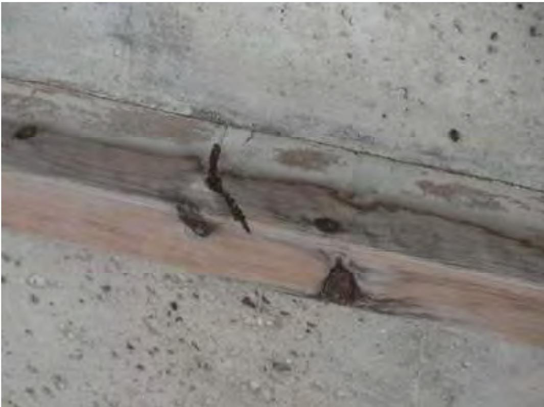
F.17. Detalle de un par de cubierta, con restos de la antigua instalación eléctrica.
