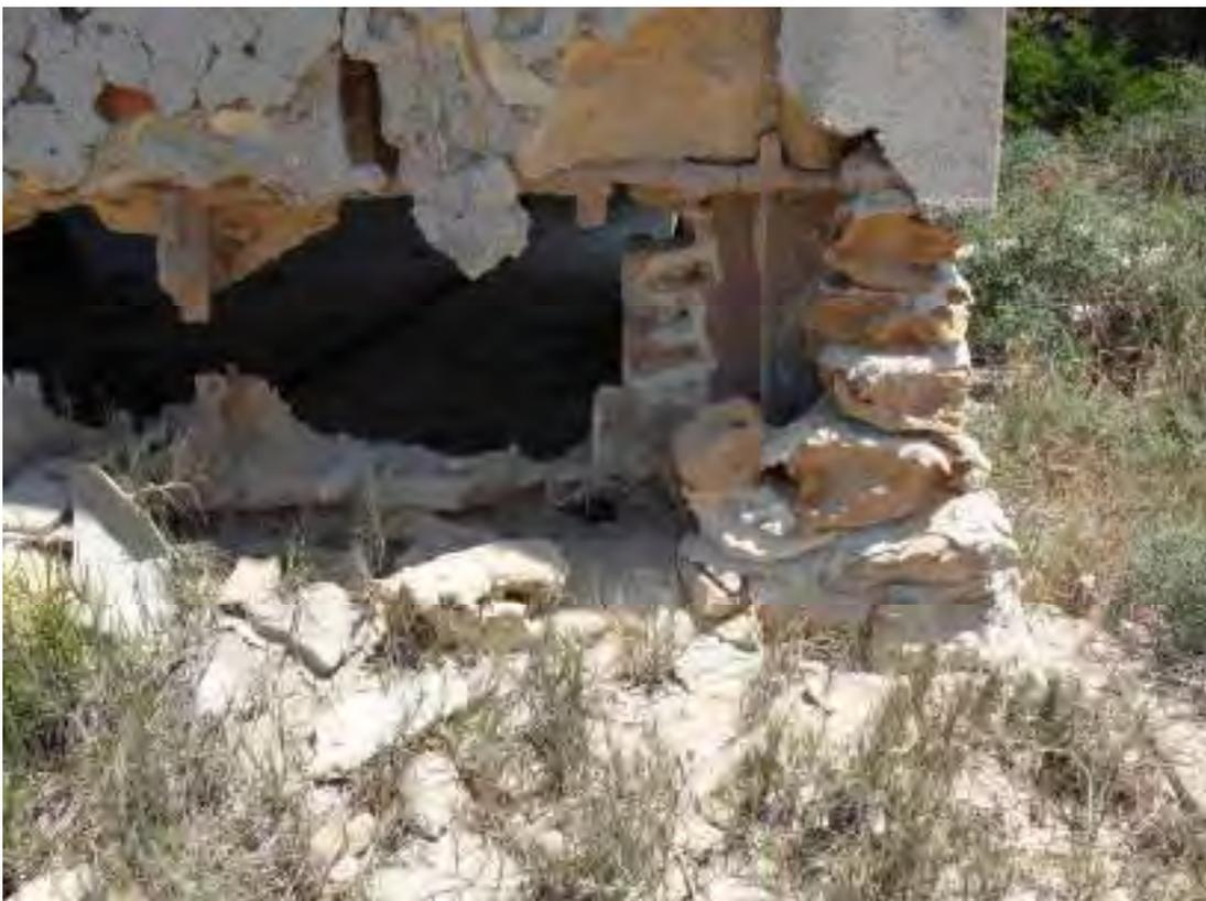
F.14. Detalle del avanzado deterioro del zócalo del edificio en su testero izquierdo.
