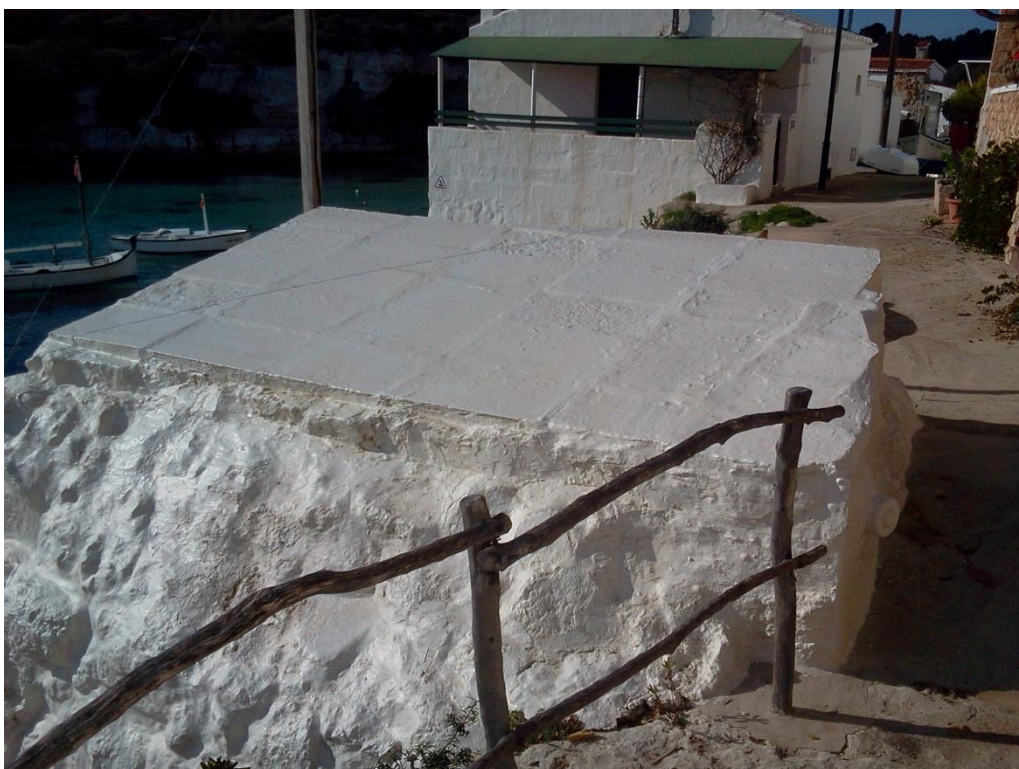
Figura 4. Cubierta, tablero de marés.
