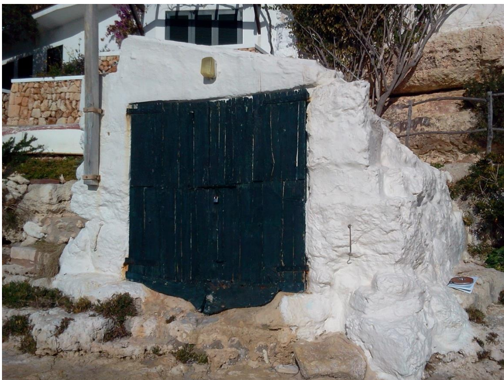
Figura 3. Fachada sur, puerta de madera con herrajes y pintura de verde carruaje.
