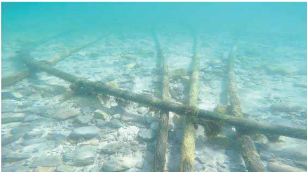
Ilustración 14. Estado de los cables sobre fondo en la zona de cala Mesquida
