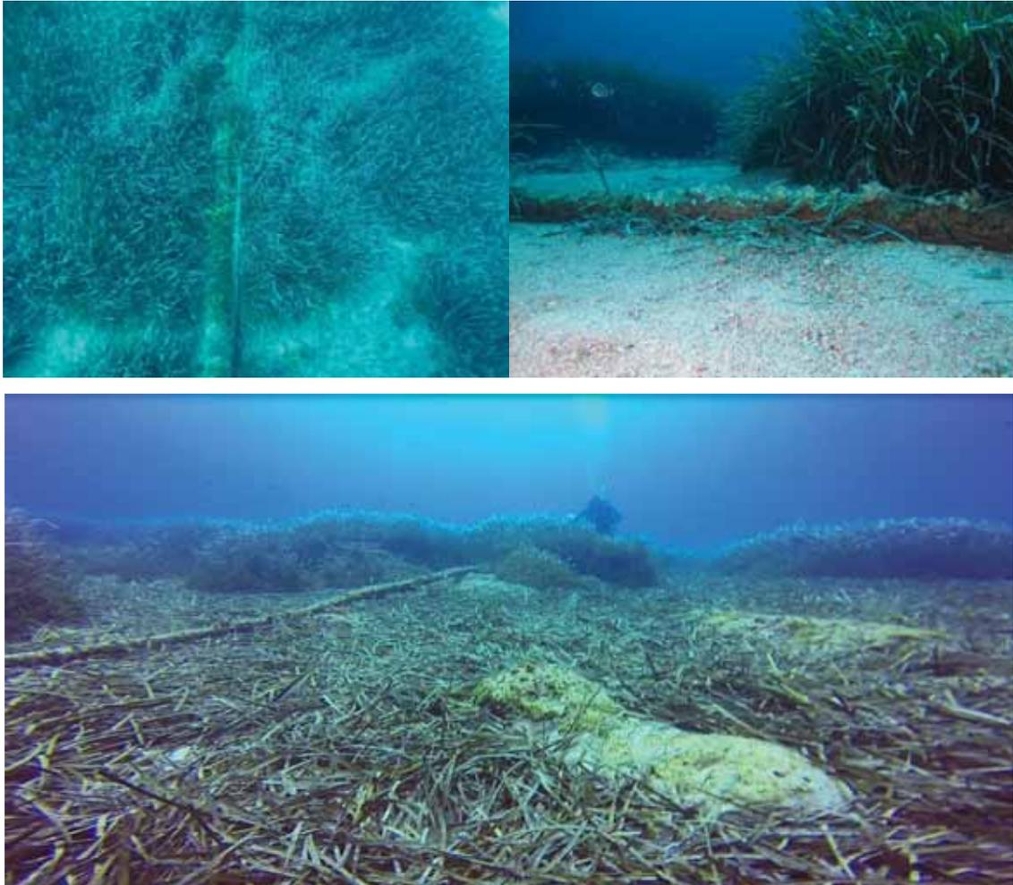
Ilustración 71. Aspecto general del cable en el HIC 1120\* Posidonia oceanica (REE, 2016-2020)
