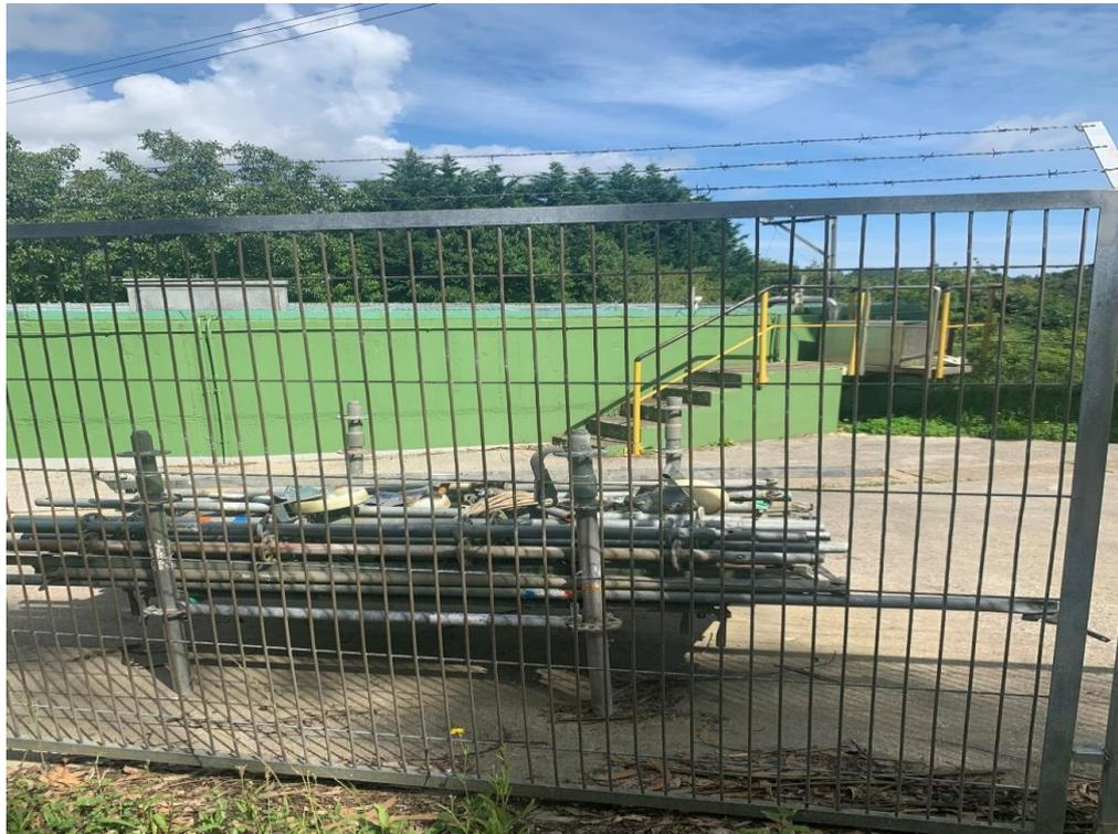
Figura 6. Vista del tanque de hormigón para nivelación de altura piezométrica.
