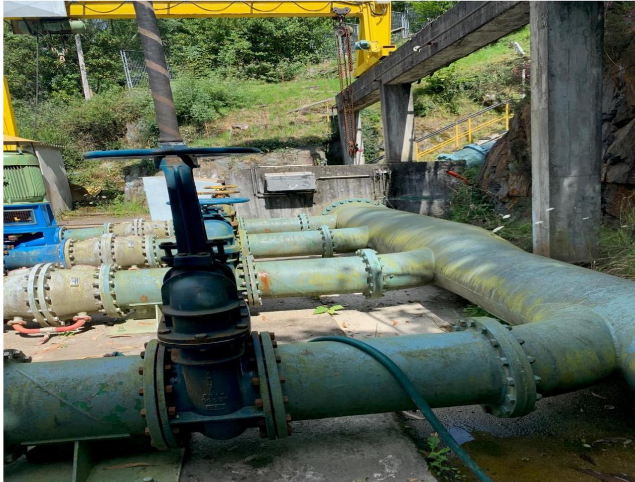
*Foto 2: Válvulas de protección frente a golpe de ariete y esquema de conexión de bombas a la tubería forzada de ascensión.*
