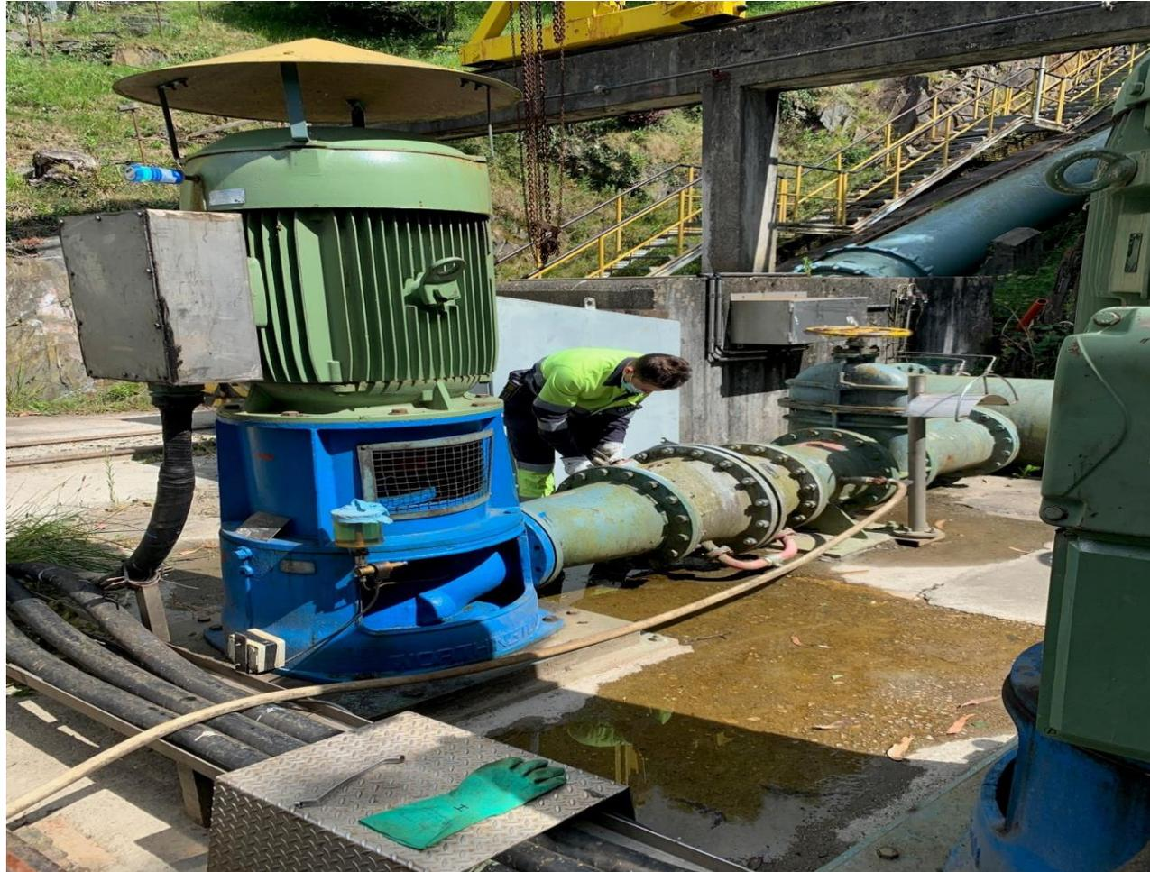
Foto 3.2: Conexión de bomba de aspiración a tubería de impulsión. Vista 2.
