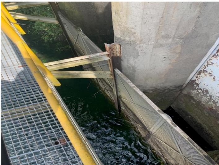
Figura 4.1. Detalle de entrada por compuerta con malla.
