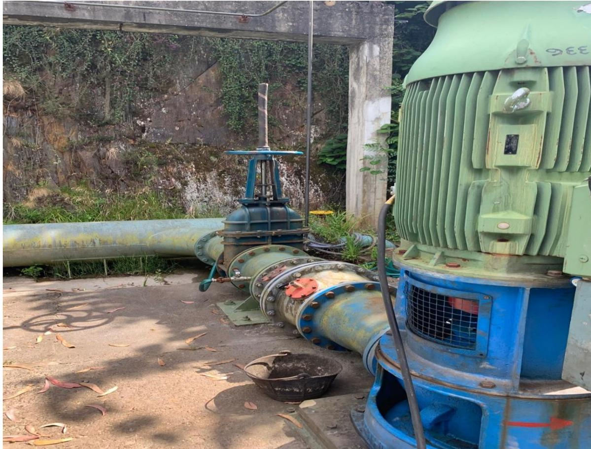
*Foto 3.1: Conexión de bomba de aspiración a tubería de impulsión. Vista 1.*
