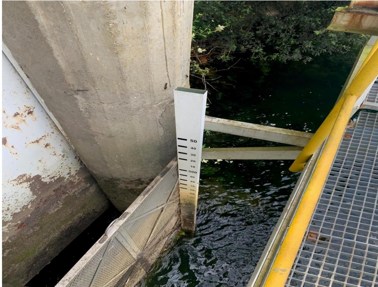
Foto 5: Control de niveles del río y rejilla de compuertas. Vista desde pasarela volada de mantenimiento.
