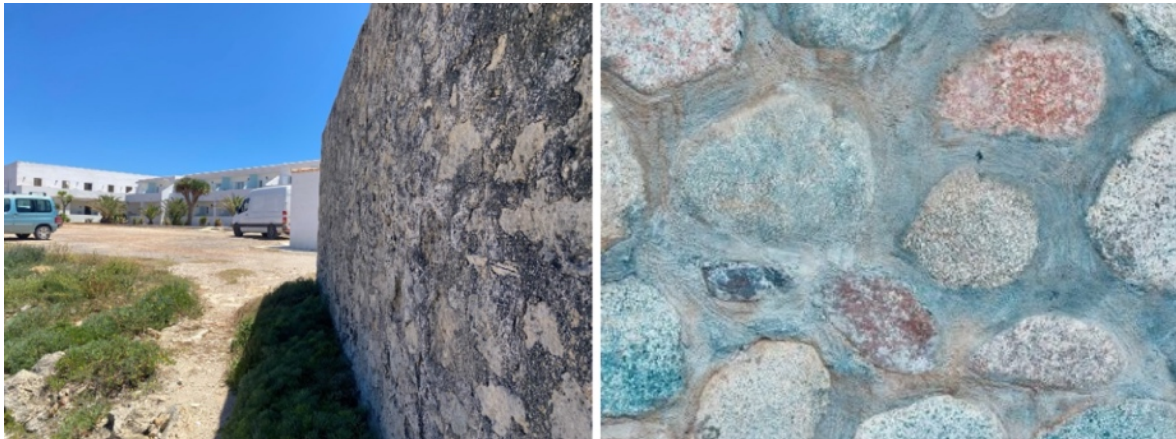
Pared de piedra en caseta en el entorno de la actuación. Propuesta de hormigón ciclópeo para la losa de la rampa de varada.
