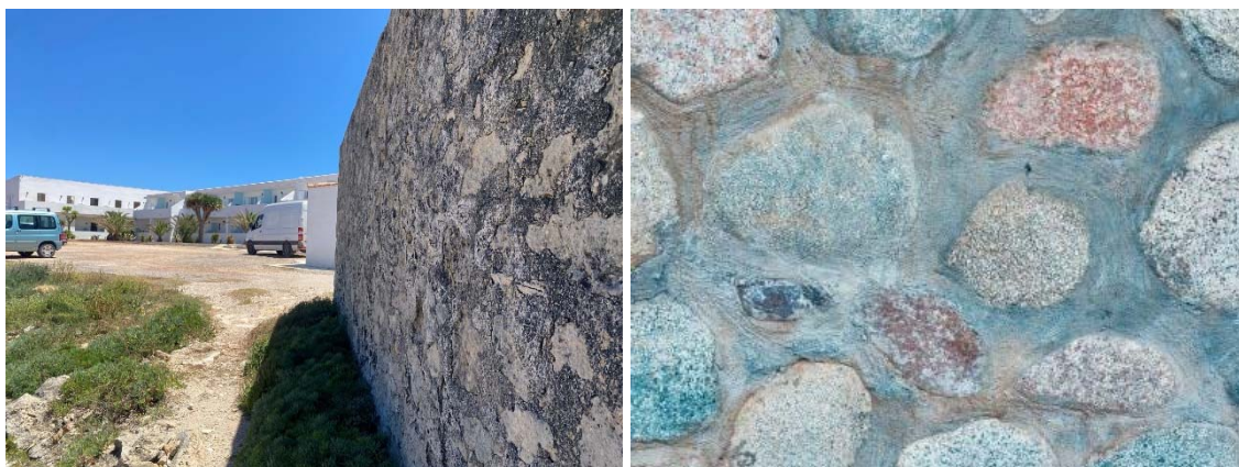
Ilustración 7 Pared de piedra en caseta en el entorno de la actuación. Propuesta de hormigón ciclópeo para la losa de la rampa de varada.
